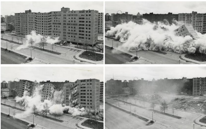
7. Demolición de Pruitt-Igoe, St. Louis, Misuri, el 15 de julio de 1972
