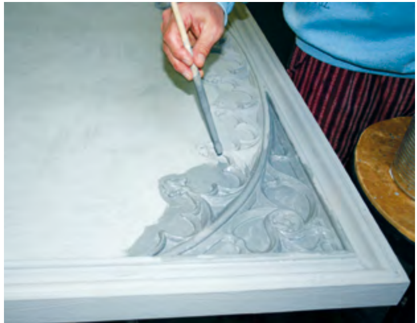
41. Treball pràctic. Aplicant la segona mà de guix gros.
