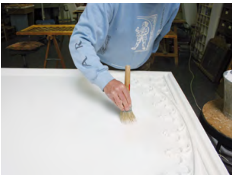
◆ 45. Treball pràctic. Aplicant la darrera mà de guix fi.
