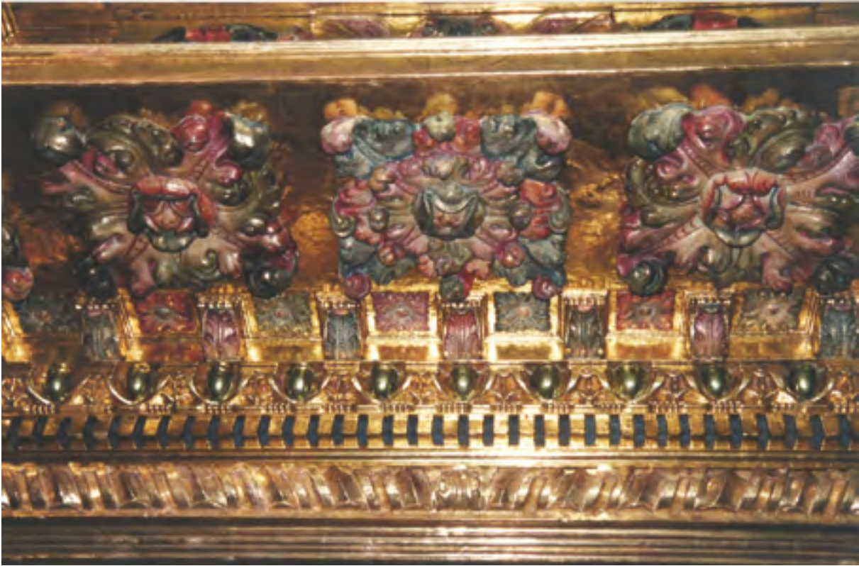
◆ 136. Detalls del retaule. Ratllat, daurat a l'aigua, brunyit, espolinat esgrafiati, espolinat a punta de pinzell, colradures, pintura al tremp i a l'oli.
