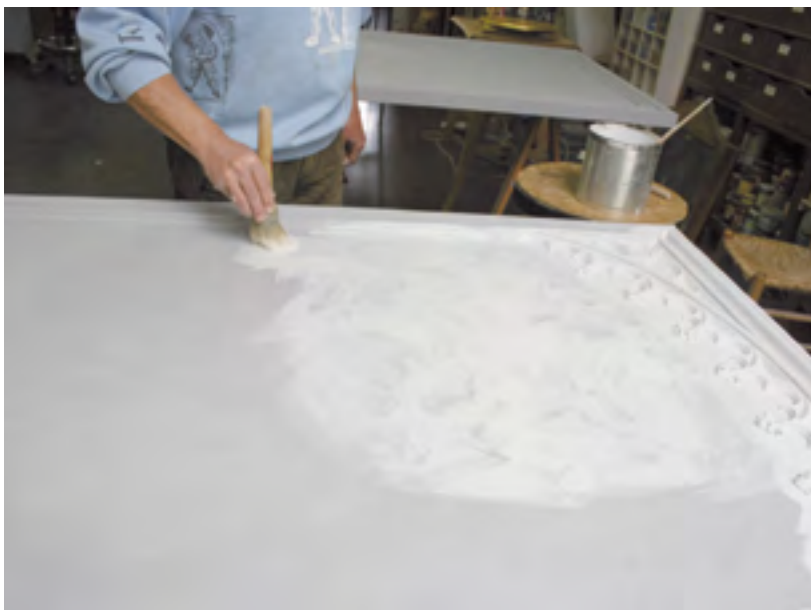
◆ 44. Treball pràctic. Aplicant la primera mà de guix fi.
