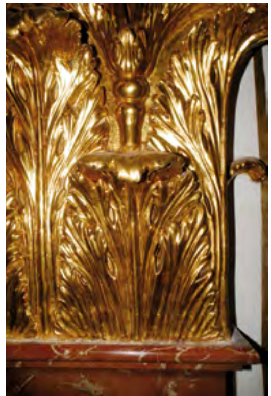
◆ 95. Basílica de la Mare de Déu de València. Reintegració de la colradura realitzada en la restauració de 2008.
