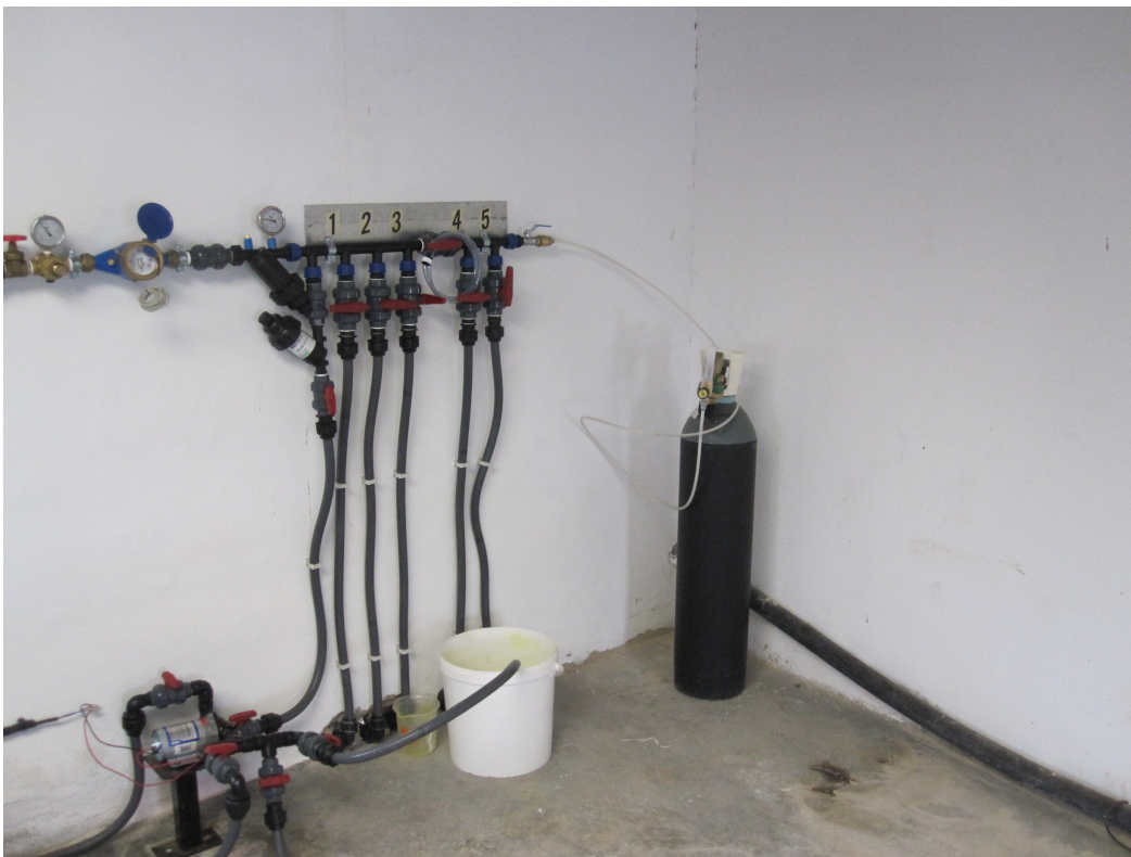
Figura 8. Incorporación del sistema de fertilización carbónica en el cabezal de riego.
