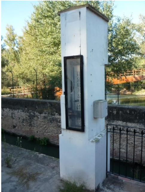
Antiguo hidrómetro en la cabecera de la cañada de Moncada
