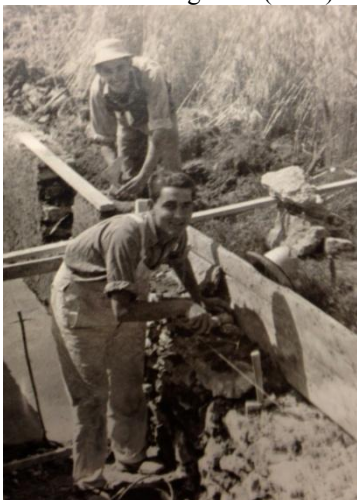
Revestimiento de hormigón de una acequia (Massamagrell)
