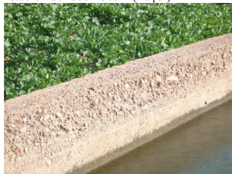
Revestimiento de hormigón del canal de Moncada (detalle)
