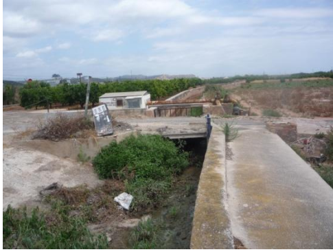
Final del Canal de Moncada 1
