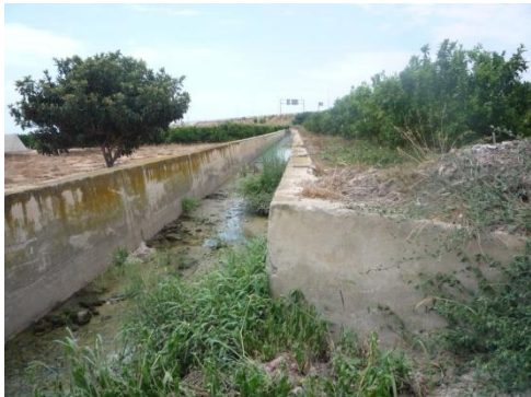
Final del Canal de Moncada 6
