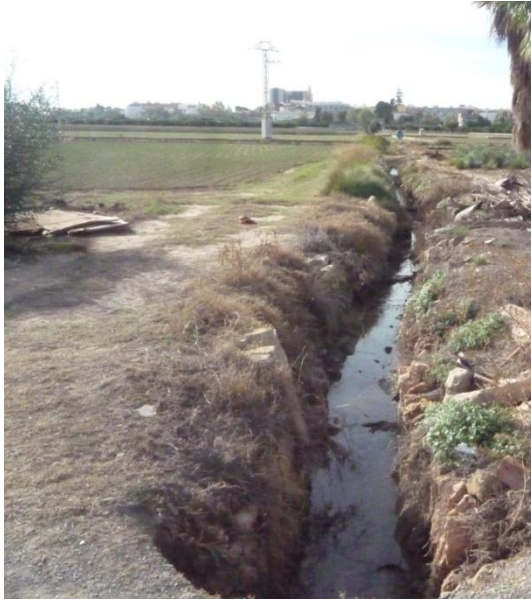
Godella. Acequia sin revestimiento. Piedra seca y tierra vegetal.
