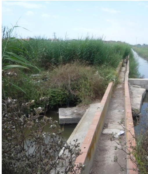
Puçol. Circuito de recuperación de retornos de riego en Puçol tras la concentración parcelaria.
