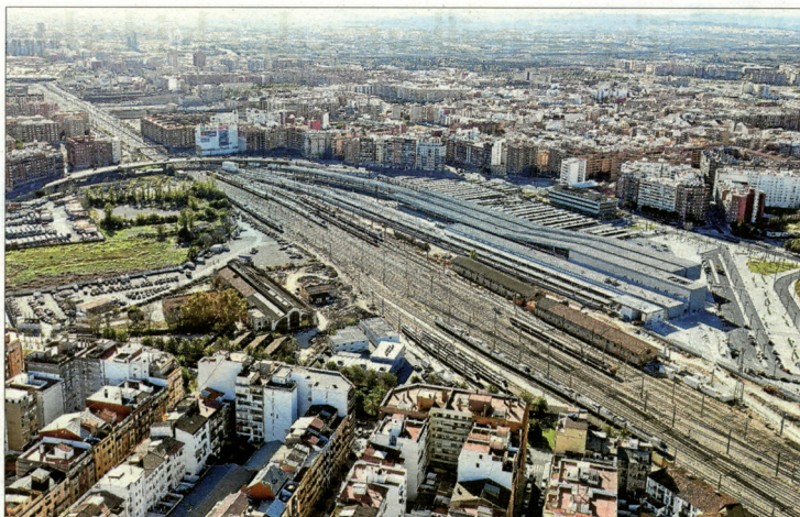
Vista general del Parque Central, gran parte del cual sigue ocupado por la playa de vías y la estación provisional del AVE. ADF
