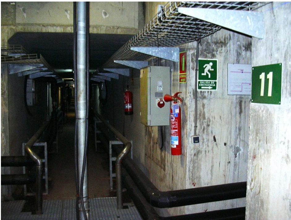
Imagen 3.- Intersección en galería de servicio, indicada con su código.
