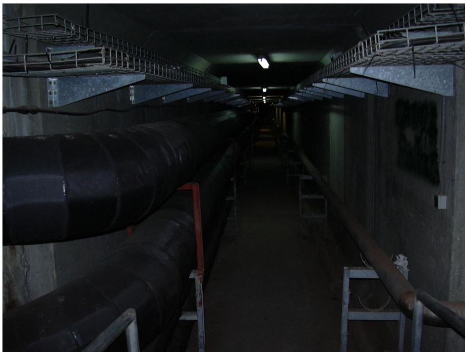
Imagen 4.- Sistemas de sopotación en galería de servicios.
