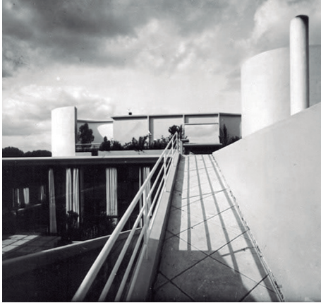
Acceso al solarium de la Villa Savoye desde la terraza jardín. Œuvre Complète 1929-1934 , p.30.
