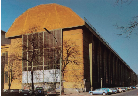
Fabrica de turbinas AEG. Peter Behrens. Imagen extraída del libro de William Curtis La Arquitectura Moderna desde 1900 p.51.
