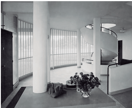
Vestíbulo de acceso de la Villa Savoye. Œuvre Complète 1929-1934, p.26.
