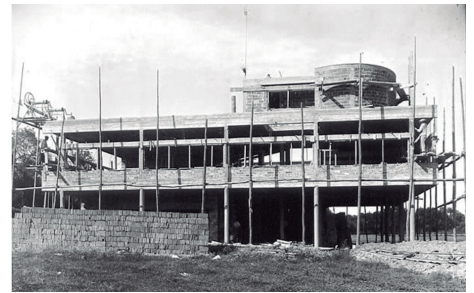
Villa Savoye en construcción. FLC.
