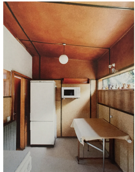
Casa Varela. Vista estar hacia acceso y puerta salida terraza a sur Vista hacia cocina y puerta galería con chimenea construida posteriormente. Define núcleo baños. Cocina con revestimientos de Fibromármol y Termotex barnizado
