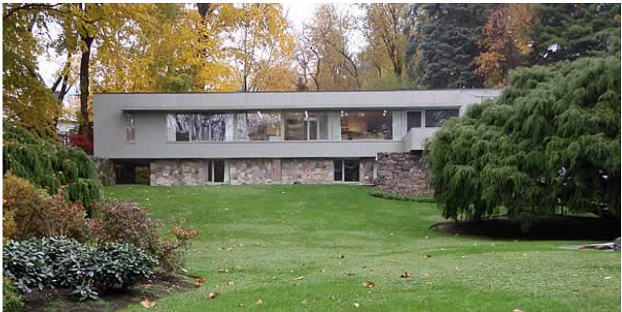
Casa Breuer I New Canaan. Details of cables - Additional steel plates Detalle de las pletinas y cables de refuerzo instalados durante la obra para intentar corregir el desplome del balcón. Imagen de época con el muro de mampostería para sustentar el balcón. Fotografía actual tras la intervención en 1981 de Robert Gatje, ex socio de Marcel Breuer
