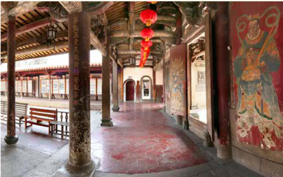
Figura 4.3.22.- Las galerías. En el fondo de esta imagen está la sala del club de la música tradicional. Fuente de la foto: Página oficial de Lukang Longshan Temple (照片鹿港龍山寺官網).
