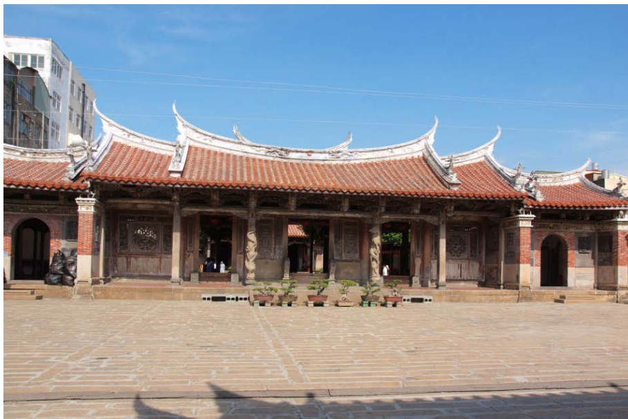
Figura 4.3.6.- Antesala de cinco puertas (五門 Entrada Principal).
