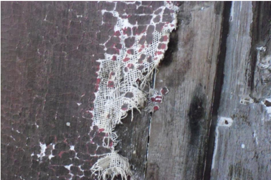
Figura 5.2.6.- Detalle de desprendimiento de la tela de lino aplicada entre el soporte de madera y las capas de policromía.
