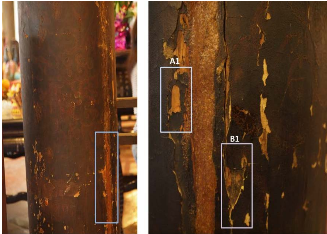
Figura 5.6.2.- Formulaciones adhesivo/consolidante A1 y B1 aplicadas sobre las policromías de una de las columnas del Palacio Principal.
