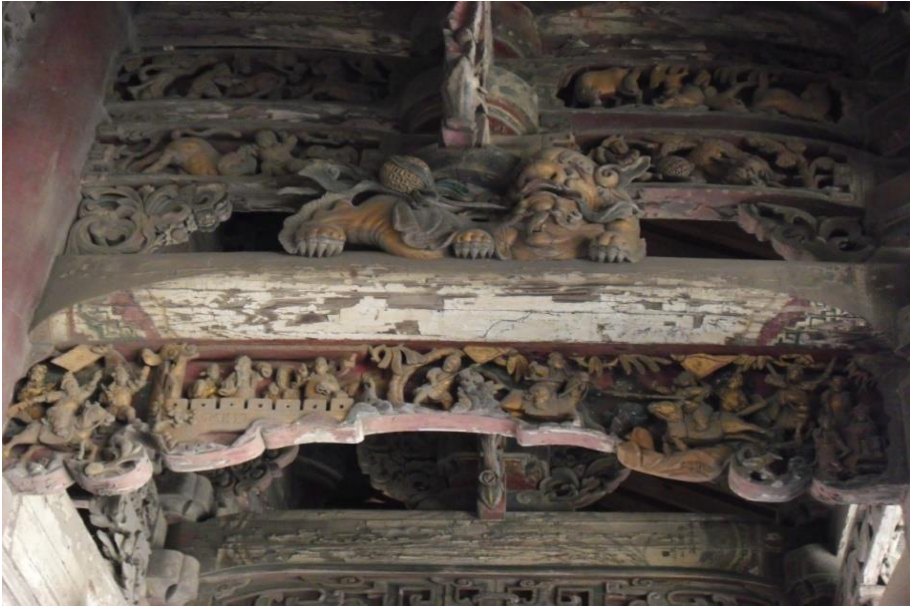
Figura 5.2.8.- Viga en Palacio Principal.
