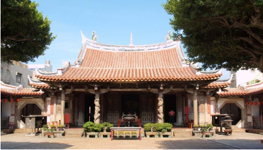
Figura. 4.3.23.- La fachada, está dividida en cinco partes, y hay una puerta con forma octogonal (Bakua, Los Ocho Diagramas ( del Libro de los cambios )) en cada extremo que unen a las galerías.
