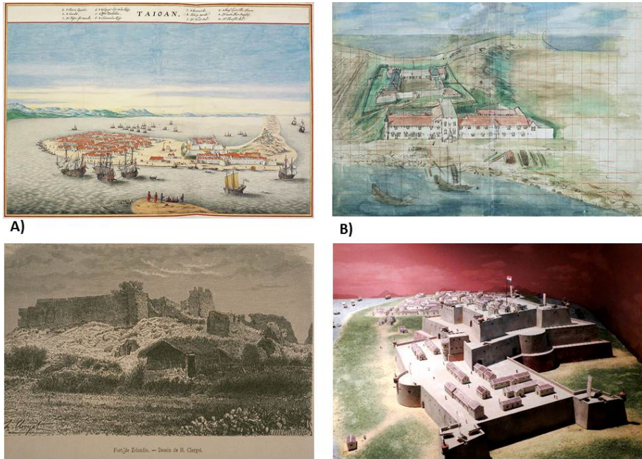
Figura 4.1.6.- Fuerte Zeelandia. A) Acurela de Fuerte Zeelandia después de 1624 en la isla de Formosa. La imagen incluye una leyenda que identifica edificios gubernamentales, mercados, barrios etc. (Colección del Museo Zeeuws, Países Bajos.), B) vista de pájaro de Fuerte Zeelandia y la residencia del responsable máximo (1653). Pintada por Johannes Vingboons (Colección Archivo Nacional de Haya, Países Bajos.), C) Lámina de Hubert Clerget (1875) ( The Straits of Malacca, Indo-China and China or, Ten years' travels, adventures, and residence abroad ) y D) Maqueta reproducción de Fuerte Zeelandia. (Foto de Koika, Wikipedia.)
