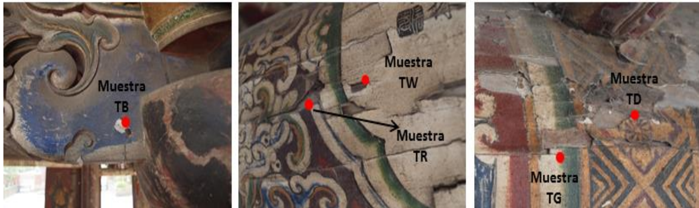
Figura 5.1.2.- Muestras extraídas de la techumbre en el Escenario.
