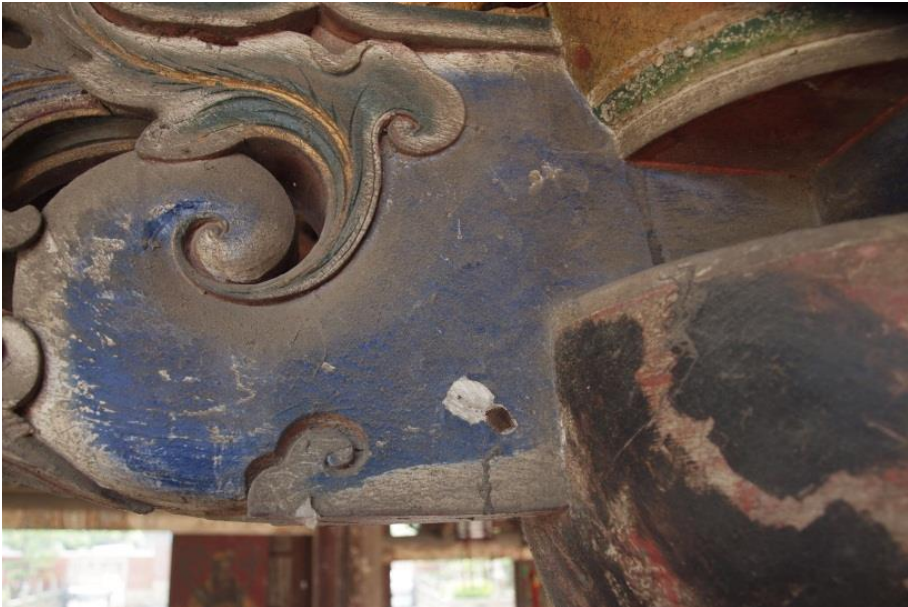
Figura 5.2.3.- Policromía realizada con aceite de tung y pintada directamente sobre la madera. Presenta un estado de conservación mejor que las policromías con capas de preparaciones.
