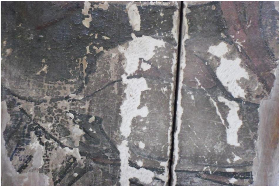
Figura 5.2.9.- Detalle de la viga en Figura 5.2.8.
