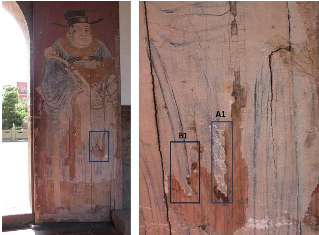
Figura 5.6.1.- Las formulaciones adhesivo/consolidante A1 y B1 aplicadas sobre las policromías en la zona de la puerta de la Entrada Principal (Wu Men)
