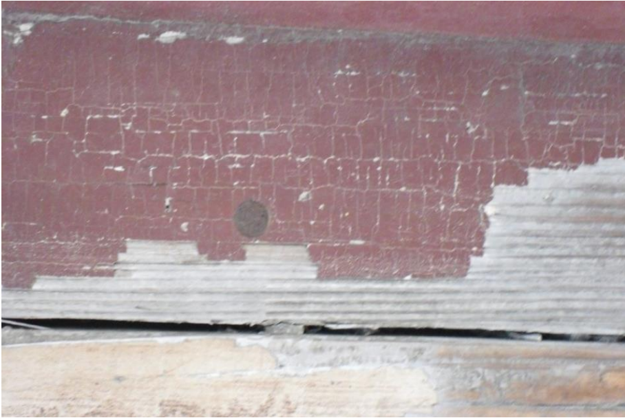
Figura 5.2.2.- Detalle ampliado de zona con red de craquelados formada por la intersección de las dos direcciones de agrietamiento longitudinal y transversal.
