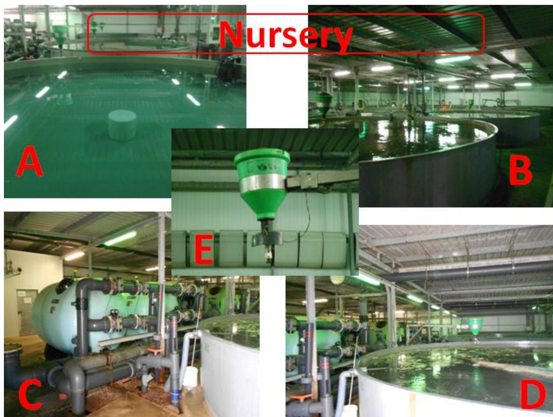
Figura 13: (A y B) Imagen de los tanques redondos, (C y D) Sistema de filtrado con los filtros de arena, (E) Comedero automático. *Fuente: Alexandre Garcia Guimarães.
