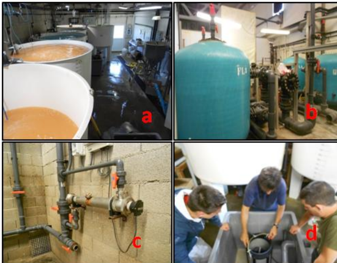
Figura 10: (a) Sala de artemia compuesta de 6 tanques troncocónicos, (b) Sistema de filtrado con filtros de arena, (c y d) Sistema de filtrado con filtros ultra violeta (U.V). *Fuente: Alexandre Garcia Guimarães.
