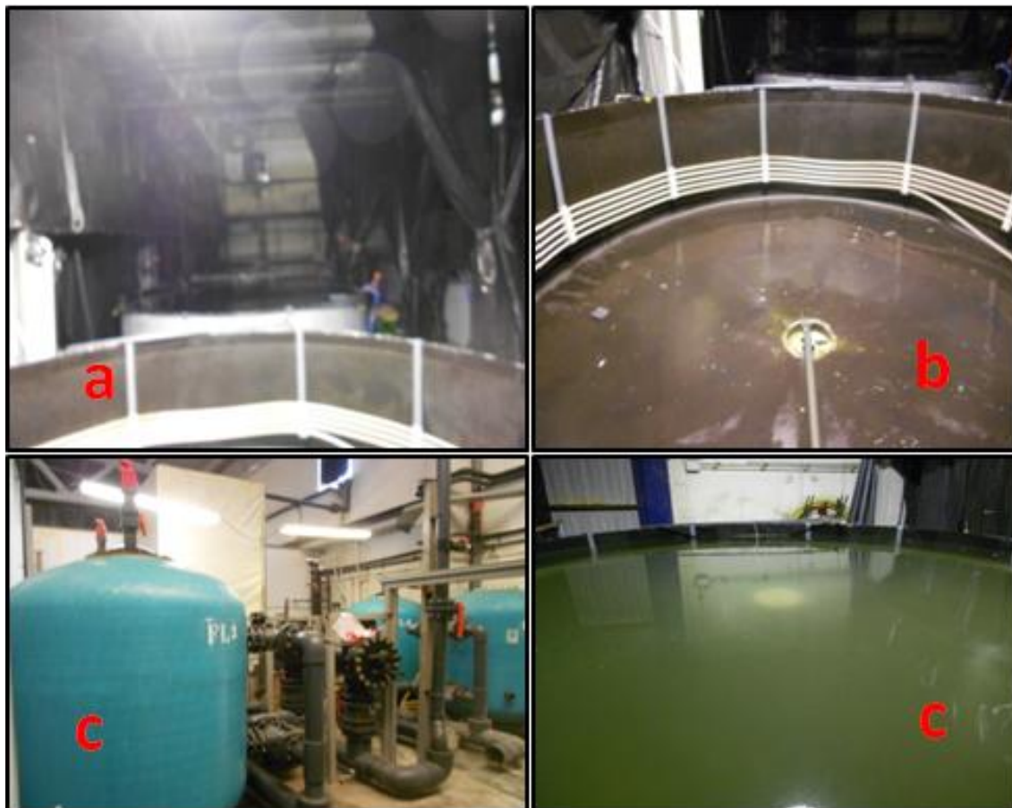
Figura 6: (a) Foto panorámica de las instalaciones del larvario, (b) tanques de larvas con detalle para el sistema de aireación, (c) sistema de filtrado y (d) tanque con agua verde. *Fuente: Alexandre Garcia Guimarães.
