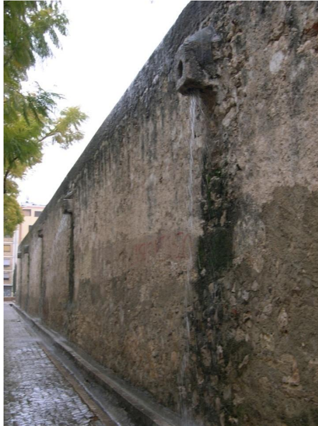
Ejemplos de humedad en la muralla_ Fotografías de la autora
