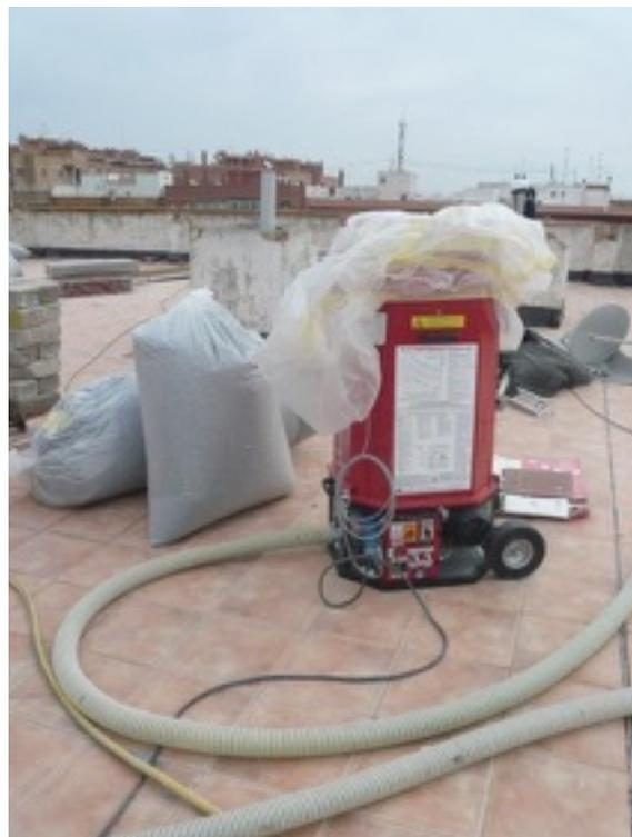
54. Imagen. Equipo de inyección mecánica y material. Fuente: IVE.
