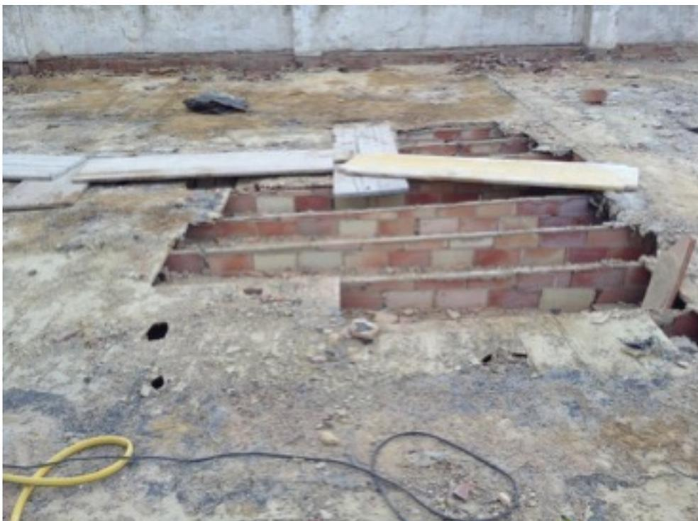
56. Imagen. Rotura de los bardos al eliminar la lámina. Fuente IVE.
