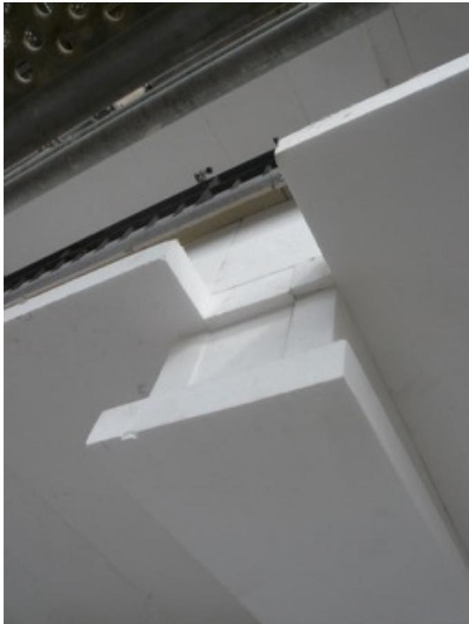
46. Imagen. Revestimiento de techos de balcones y vigas exteriores colgadas. Fuente: IVE.
