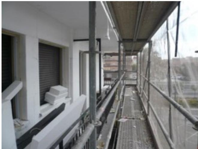
43. Imagen. Montaje de placas empleando un andamio tubular. Fuente: IVE.
