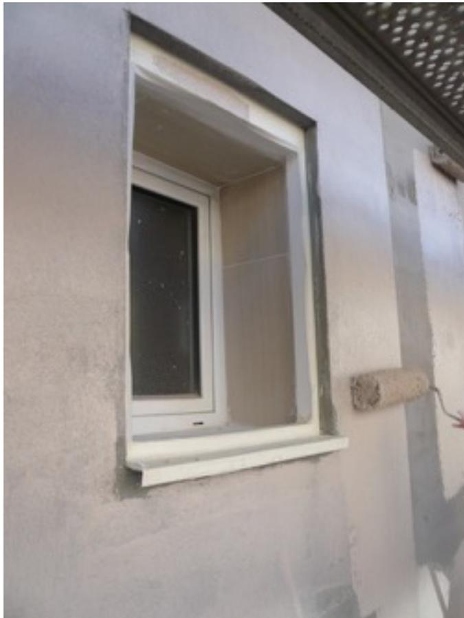
**48. Imagen. Capas finales que le dan acabado de apariencia pétreo, colocación de las ventanas con un retranqueo de cinco centímetros. Fuente: IVE.**
