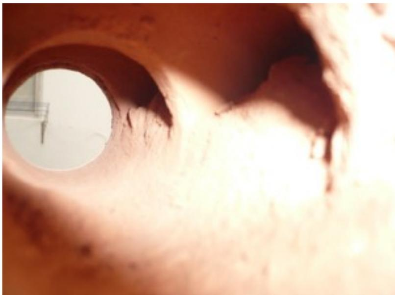
52. Imagen. Perforaciones en patios de luces para la inyección de perlas de EPS. Fuente: IVE.
