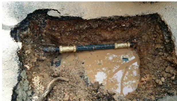
Fig. 10-3. Reparación rotura tubería
