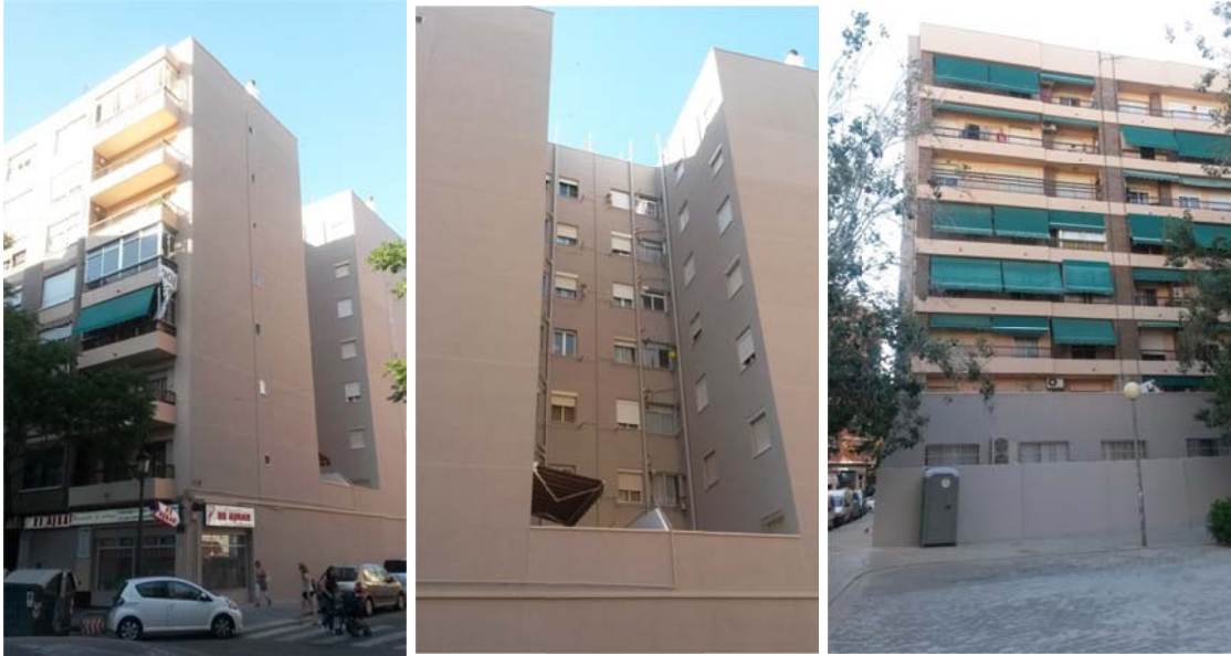
Imagen 49: Fachadas exteriores acabadas. Fuente IVE
