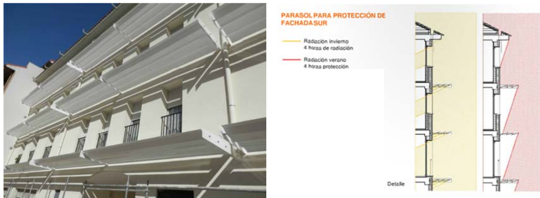
Imagen 11: Imagen de las viviendas terminadas con protecciones solares y su gráfico explicativo. Fuente Gómez Muñoz.
