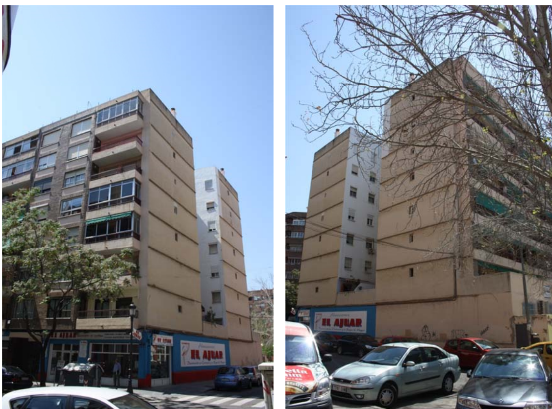
Imagen 4: Fachadas del edificio antes de la intervención. Fuente IVE
