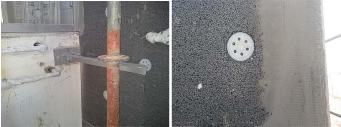
Imagen 47: placas de EPS colocadas con sus fijaciones, y remate de esquina con cantonera y solape de malla para arranque en nuevo paño. Fuente IVE
