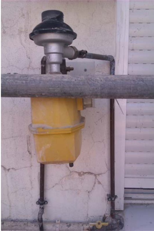
Imagen 42: en ocasiones las instalaciones existentes causaron algunos problemillas para la instalación del andamio y su desplazamiento para la colocación del SATE. Fuente IVE.
