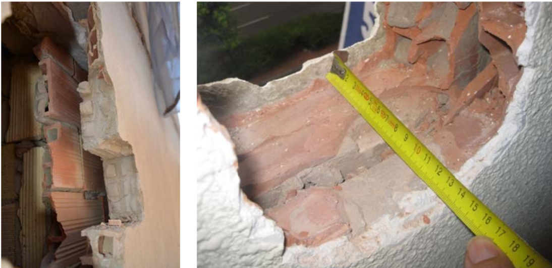
Imagen 52: Catas realizadas en la fachada principal y fachada “medianera” para constatar el cerramiento. Fuente IVE
