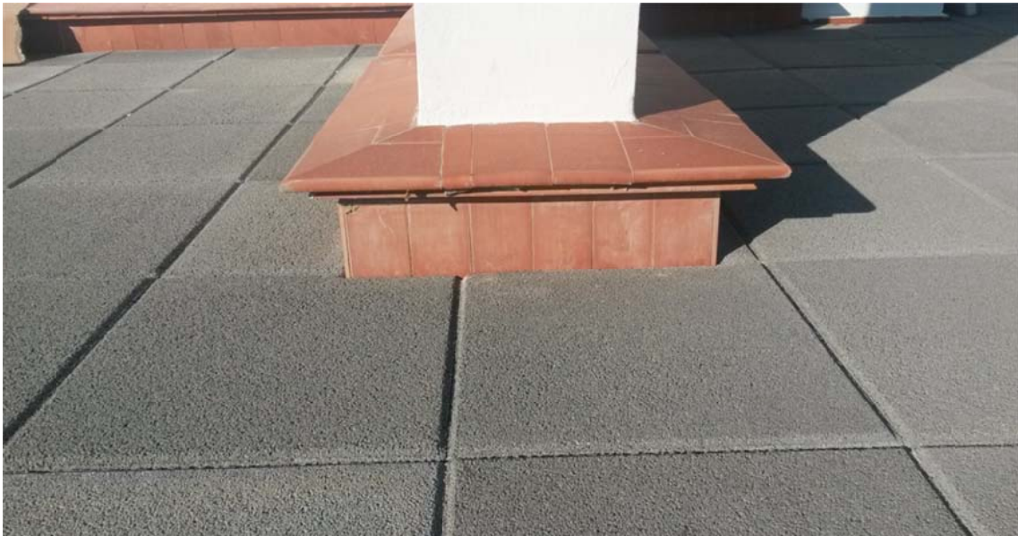
Imagen 40: Cubierta terminada. Fuente IVE
