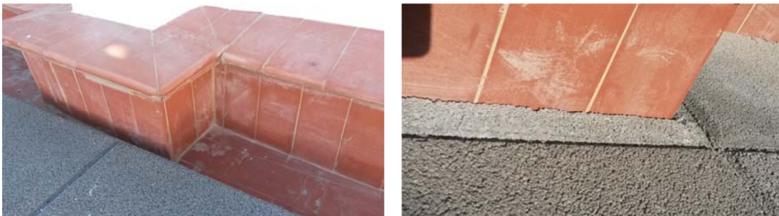
Imagen 39: La baldosa permite adaptarse a cualquier remate, encajando por completo. Fuente IVE
