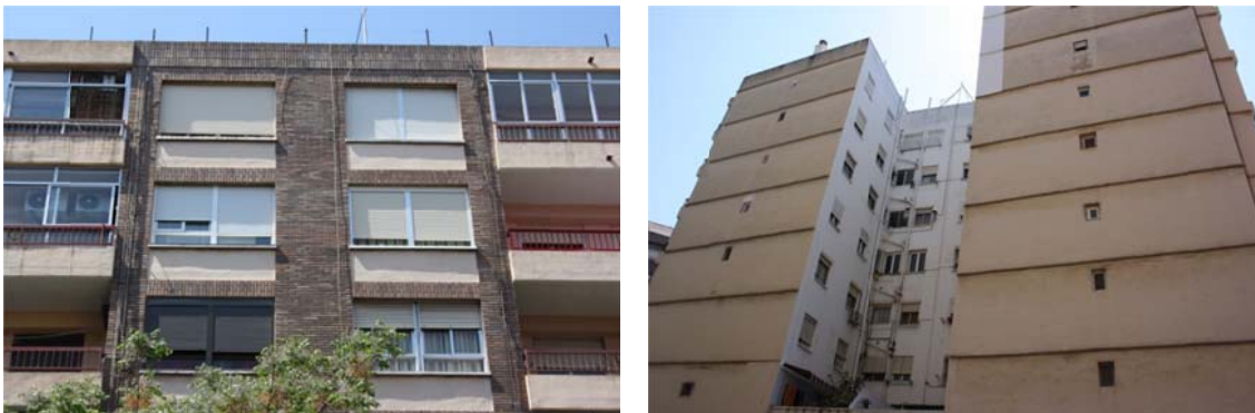
Imagen 45: Foto de la fachada delantera (C/Fontanares) donde se aprecia la dificultad de solventar el puente térmico sin afectar estéticamente, en diferencia con la fachada medianera (C/Alquería de Benloch) y el deslunado allí recayente.
