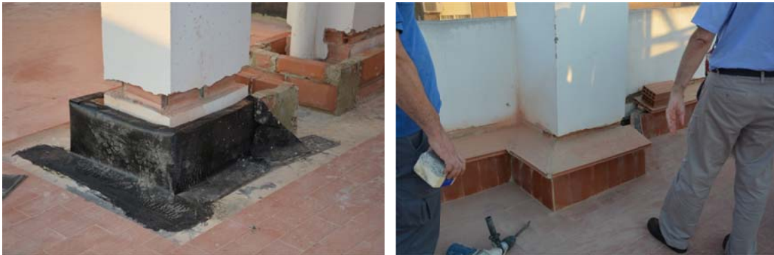
Imagen 38: Realización de refuerzo en elementos de cubierta y presentación de acabado. Fuente: IVE
