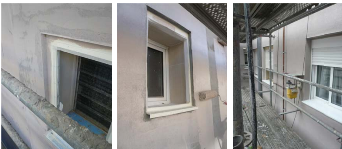
Imagen 48: Proceso de acabado con las diferentes capas. Fuente IVE.
