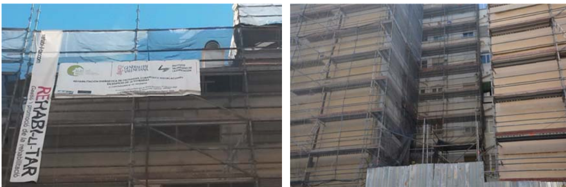
Imagen 37: Fachadas del edificio con andamiaje y la cartelería de publicidad del Proyecto ELIH-MED. Fuente IVE
