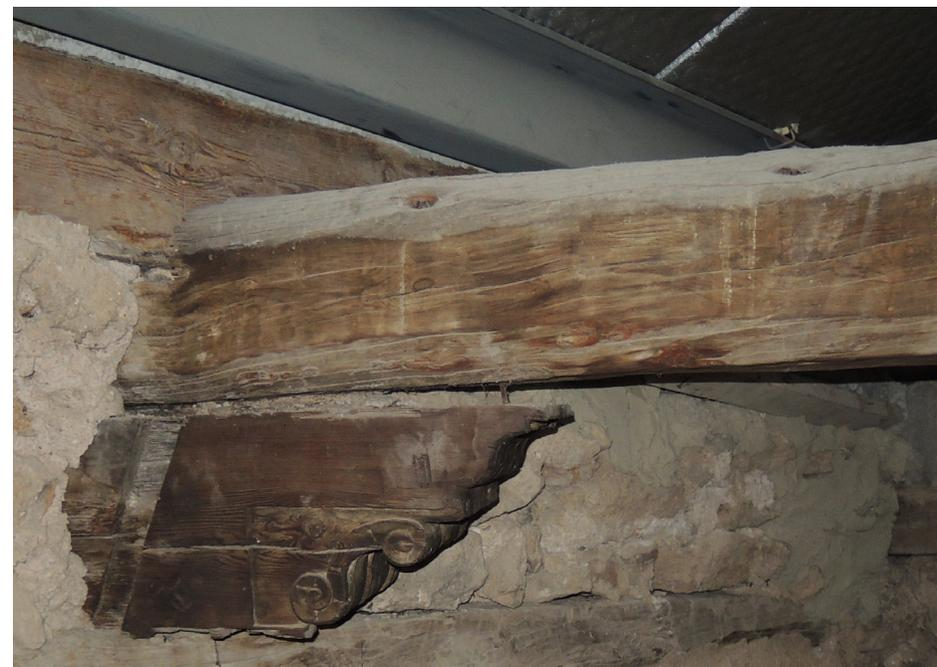
Fig. 89 - Ménsulas de la estructura de La cubierta oculta por las bóvedas. Iglesia Parroquial de Camporrobles.
