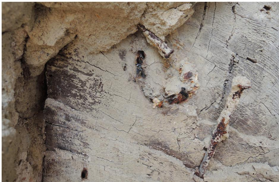
Fig. 126 – Clavos con oxido
