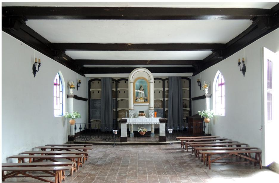
Fig. 115 -Interior de la Ermita de San Bartolomé con el falso cielo raso de yeso que ocultaba la cubierta.
