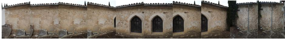
Fig. 18 -Fotografías del muro Norte de la ermita realizadas en serie para la obtención de un fotoplano.
