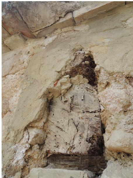
Fig. 123 – Eliminación de mortero impropio
