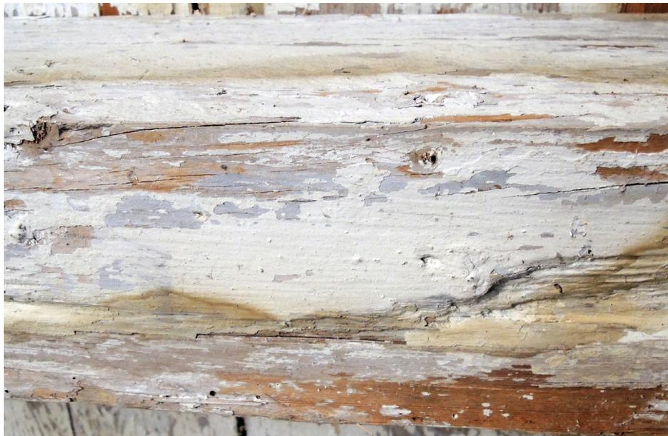
Fig. 118 - Detalle de un par de la cubierta; se observa los diferentes encalados y lesiones en la madera (Carcoma y Manchas de humedad)
