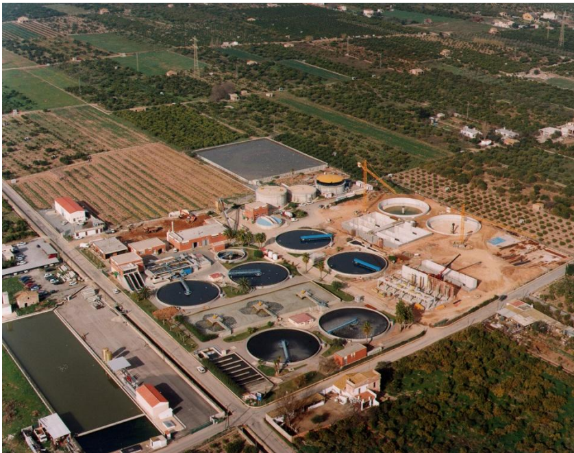
Ilustración 1.- Obras de ampliación y tratamiento terciario de la EDAR de Castellón.
