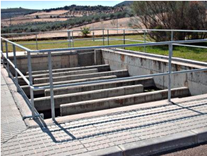
Ilustración 41.- Laberinto de cloración de una EDAR.
