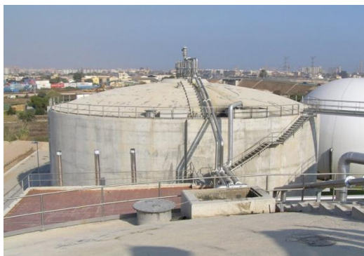
Ilustración 28.- Digestor Anaerobio para estabilización de fangos.
