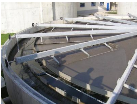
Ilustración 27.- Espeador de fangos por flotación.
