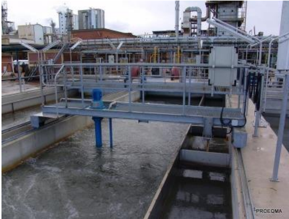
Ilustración 22.- Desarenador-desengrasador aireado.
