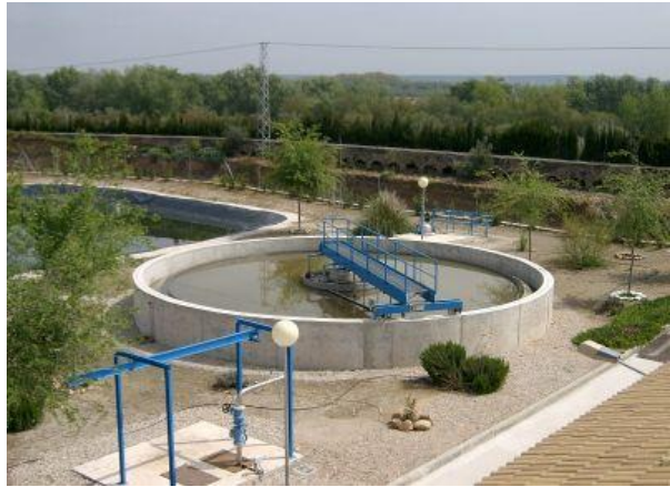
Ilustración 23.- Decantador Primario.
