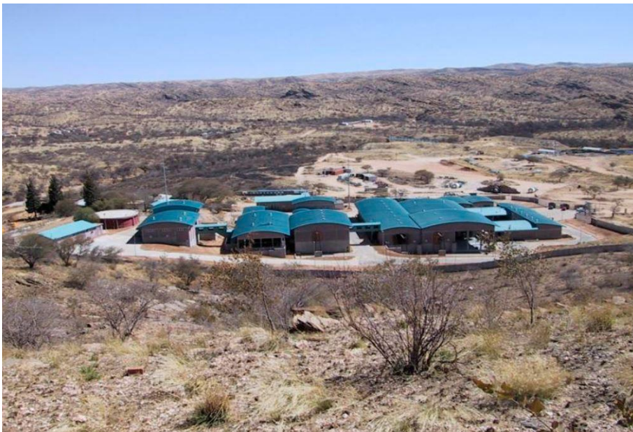
Ilustración 40.- estación de regeneración avanzada de Goreangab (Namibia).
