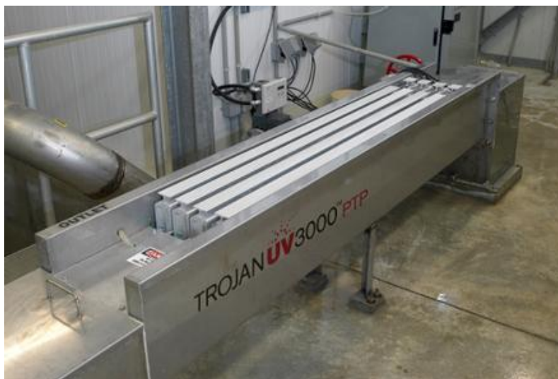
Ilustración 43.- Módulo de desinfección UV.
