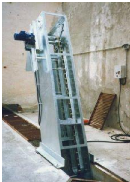
Ilustración 20.- Reja de desbaste automática.
