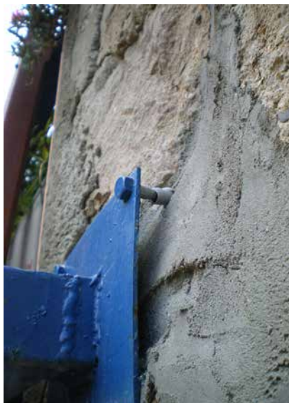
29. Fotografía del anclaje de las cerrajerías en el hormigón. Fotografía de noviembre de 2007
