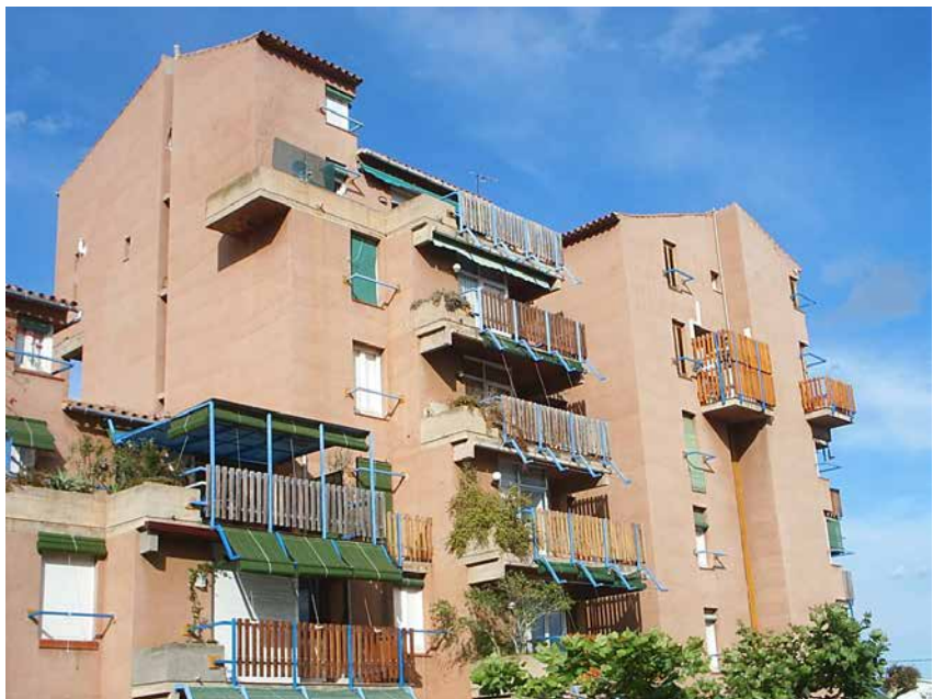
02. Estado de las fachadas del bloque A. Fotografía de septiembre de 2004
