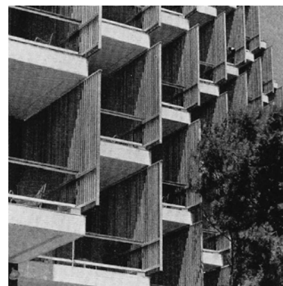
19. José Antonio Coderch y Manuel Valls, Hotel de Mar, 1962. Protección solar en las terrazas
