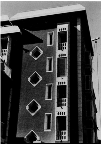
16. Huecos romboidales en el patio interior de Santa Águeda y en el edificio en Doctor Carulla, ambos de MBM
