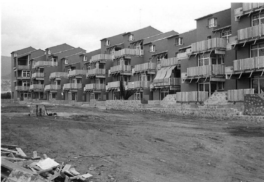
04. Santa Águeda en el momento de la finalización de los bloques A y B, sin el bloque C ni el jardín comunitario. Fotografía atribuida a Deidi von Schaewen, 1969.
