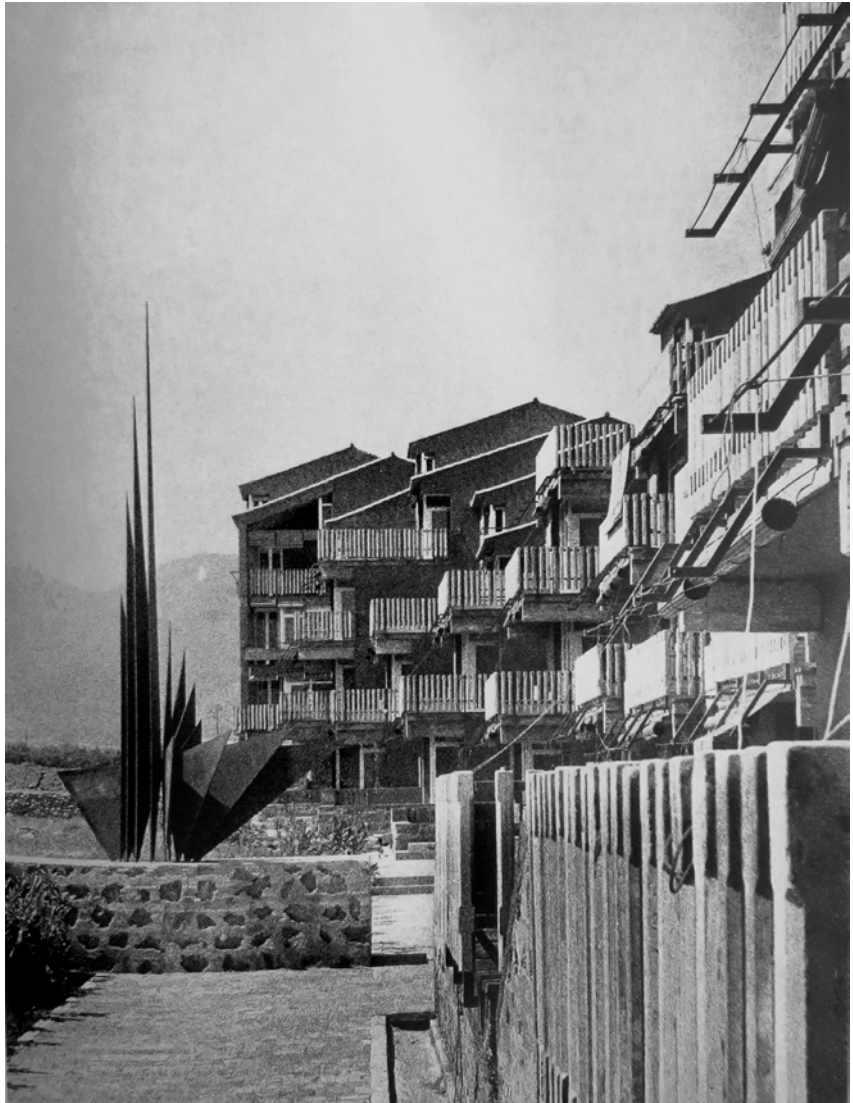
MBM, apartamentos "Santa Águeda" en Benicàssim, 1966-1968. Fotografía del conjunto en el momento de su finalización, Deidi von Schaewen, 1969
