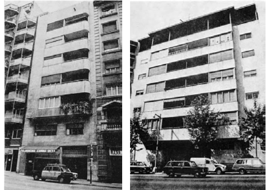
35. Raimon Duran i Reynals, Edificio de viviendas para Francesca Espona en la calle Muntaner, Barcelona, 1932
