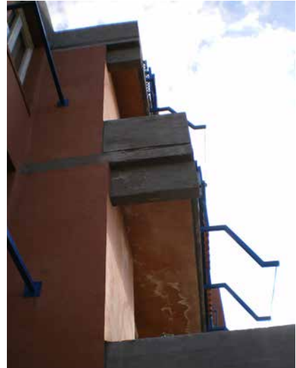
26, 27, 28. Imágenes de la persistencia de goteras en elementos de hormigón. Fotografías de noviembre de 2007
