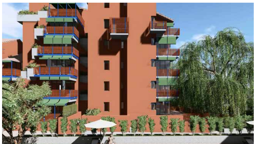
21. Detalles de la fachada interior del bloque A.
