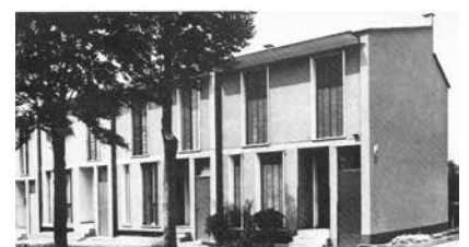
90. BBPR (Lodovico Barbiano de Belgioioso, Enrico Peressuti, Ernesto Nathan Rogers), viviendas en el quartiere INA-Casa, Cesate, 1951. Detalle de las fachadas
