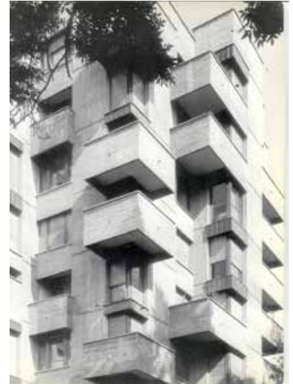
44. Vico Magistretti, Edificio en Piazzale Aquilea, Milán, 1962-1964
