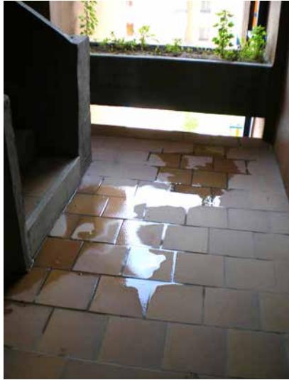
26, 27, 28. Imágenes de la persistencia de goteras en elementos de hormigón. Fotografías de noviembre de 2007
