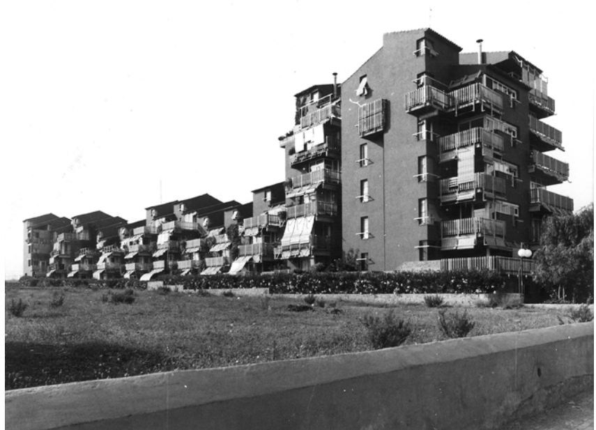
09. Bloques A y B, sin el bloque C ni el jardín comunitario en una fotografía atribuida a Xavier Miserachs, años después de la construcción de la primera fase.
