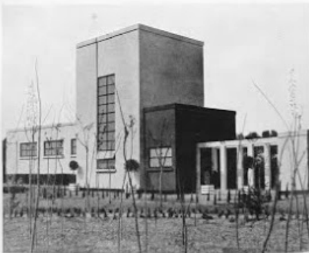
Arch. FERNANDO GARCÍA MERCADAL. 527-528 - La fachada della Biblioteca Goya a Saragozza.
