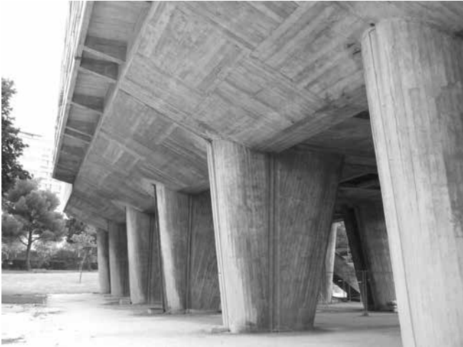
98. Le Corbusier, Unité d'Habitation, Marsella, 1945-1952. Estructura de hormigón en la planta baja con marcas del encofrado.
