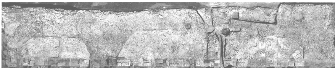
Ortofoto del sector central del macizo de opus caementicium , en el que se observan las improntas correspondientes a las exedras del frente escénico (en Ramallo et alii 2010, fig. 4).
