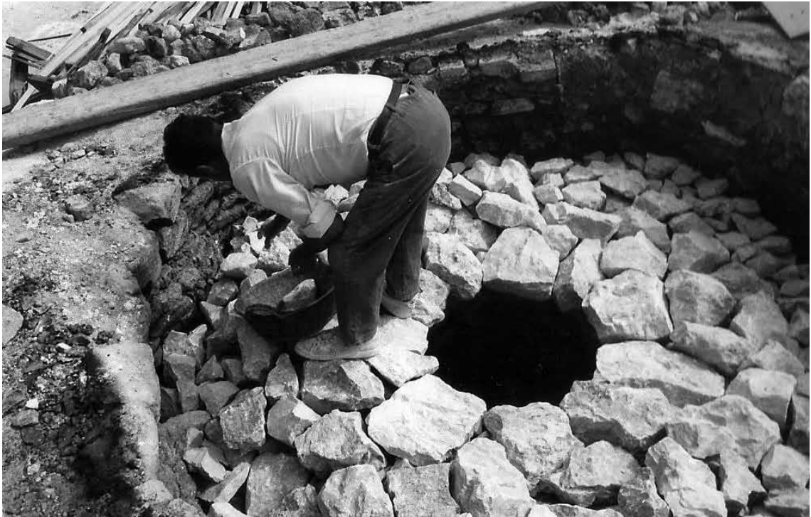
Fig. 63. Sebastián Gombau Brau, cerrando la bóveda, a punto de colocar la piedra llave. Archivo familiar Gombau Brau.
