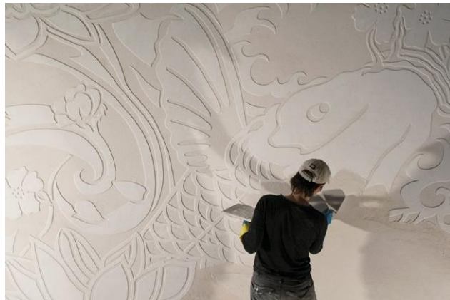
Fig. 121. Realización de un esgrafiado.
