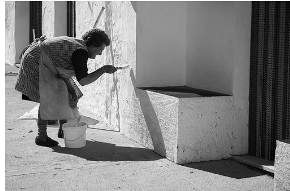
Fig. 106. Fachada encalándose con cal.
