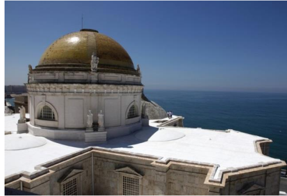
Fig. 103. Cubierta de la catedral de Cádiz, después de su rehabilitación.
