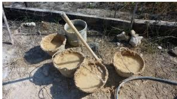
Fig. 31. Apagado de la cal de modo en pequeñas cantidades.
