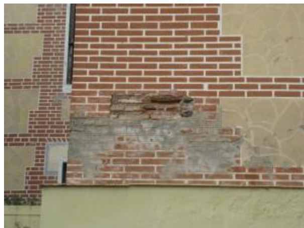
Fig. 141. Fingido de ladrillos sobre paramento de ladrillo. Basílica Parroquia y Real Santuario de Santa María de la Victoria y la Merced. Málaga.
