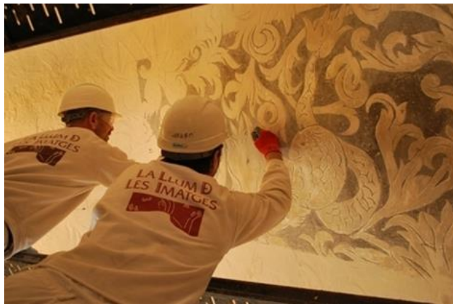
Fig. 127. Trabajos de un esgrafiado catalán.
