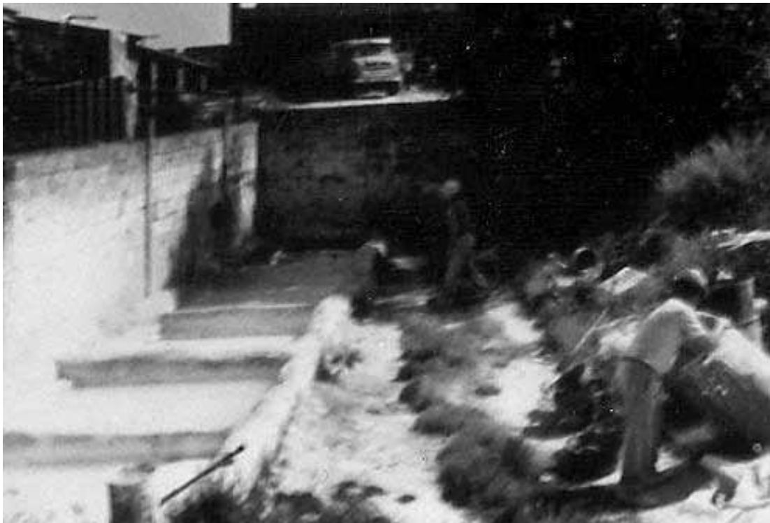
Fig. 66. Francisco Gombau Brau, sacando cal viva de los bidones, para convertirla en "cal muerta". Archivo familiar Gombau Brau.
