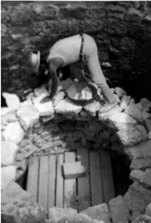
Fig. 61. Sebastián Gombau Brau, colocando las piedras de la bóveda del último horno de cal que funcionó en Vinaròs. Archivo familiar Gombau Brau.
