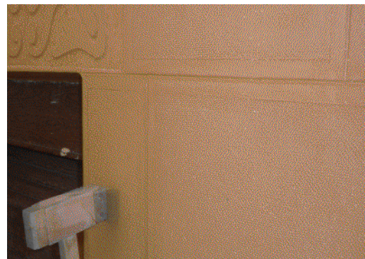
Fig. 134. Fingido de sillares con la técnica de la Martillina.
