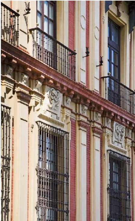
Fig. 2. Foto de Restauración Palacio Arzobispal. Sevilla. Arq.: Gonzalo Díaz Recasens.
