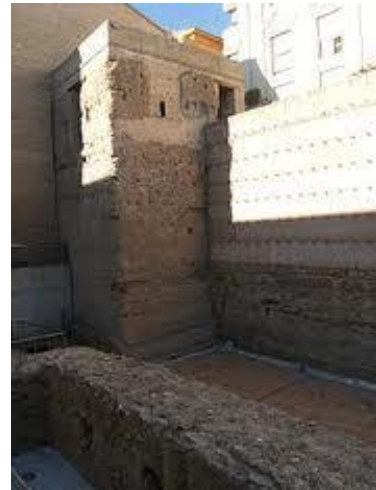
Fig. 114. Muros realizados con hormigón de cal.
