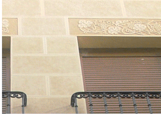
Fig. 135. Fachada mediante fingido de sillares con la técnica de la Martillina.
