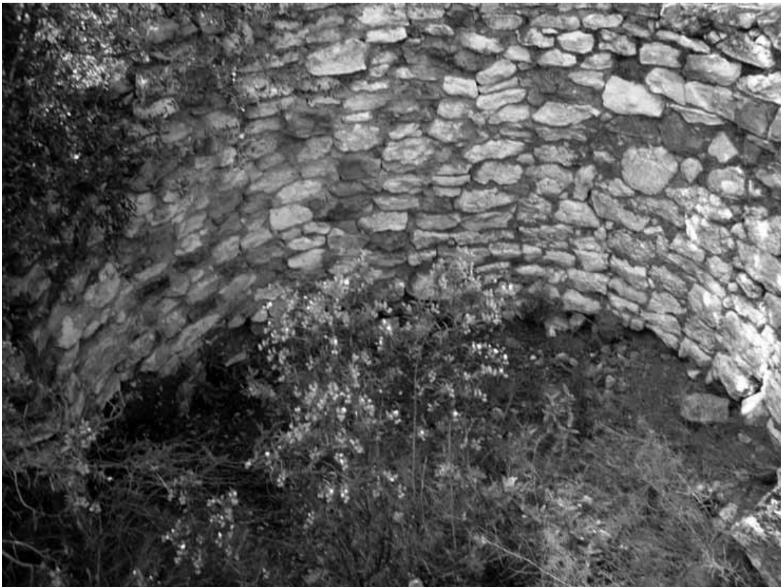
Fig. 53. Antiguo horno de cal en Vinaròs.
