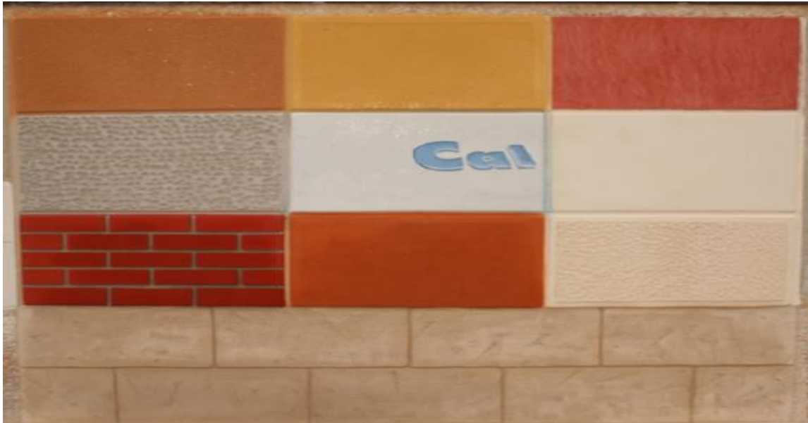
Fig. 15. Esquema diferentes acabados de los morteros de cal y mixtos. De arriba abajo y de izquierda a derecha: 1.- Rasqueta, 2.- Rasqueta con Plinto, 3.- Estuco brillo para exteriores, 4.- Pico Gavilán, 5.- Esgrafiados, 6.- Fratasado Fino, 7.- Imitación a Ladrillo, 8.- Martillina con Plinto, 9.- Piedras de abultado.
