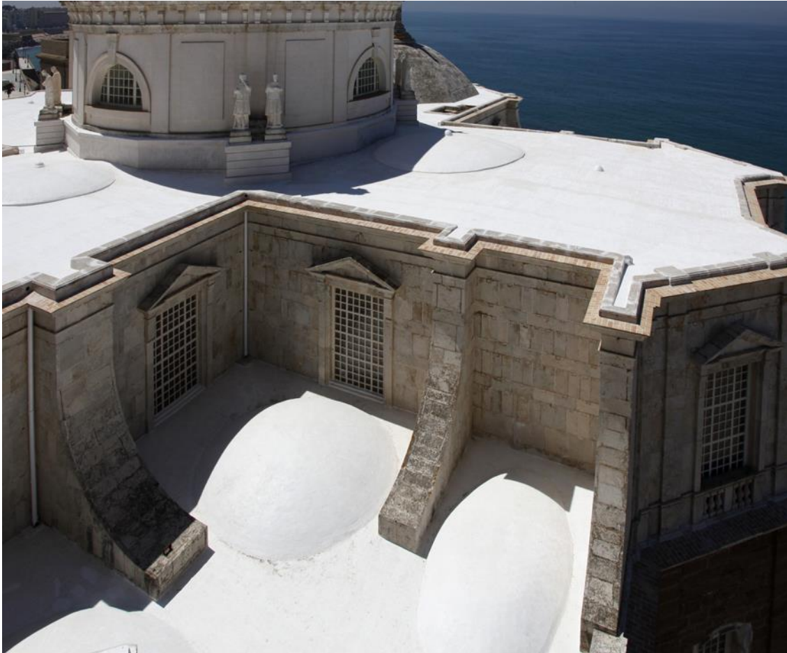
Fig. 101. Cubierta de la catedral de Cádiz, rehabilitada con pintura de cal con Grafeno.
