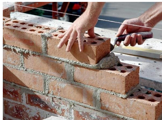
Fig. 112. Tabique realizándose con mortero de cal.
