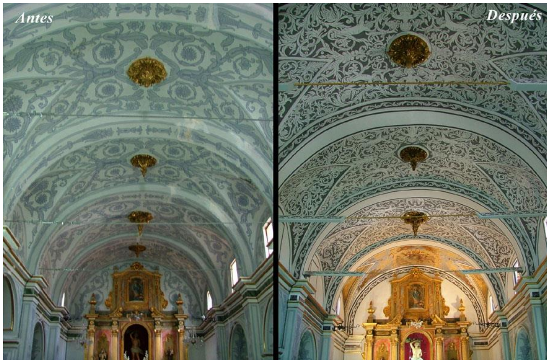
Fig. 128. Trabajos de restauración de la de la parroquia de Losa del Obispo (Valencia). Estos esgrafiados se encontraban bajo numerosas capas de pintura posteriores (la última con la decoración que se aprecia en la foto), incluso, algunas bajo una gruesa capa de yeso fruto de remiendos de las antiguas grietas.
