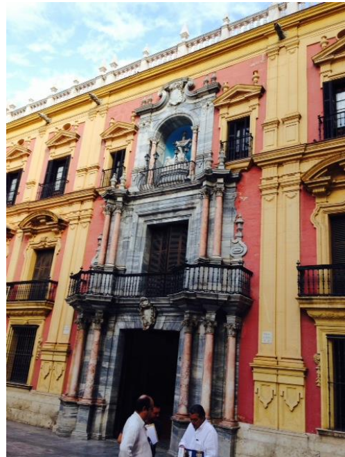
Fig. 107. Fachada del Palacio Episcopal de Málaga. Rehabilitada con pintura de cal y Grafeno.
