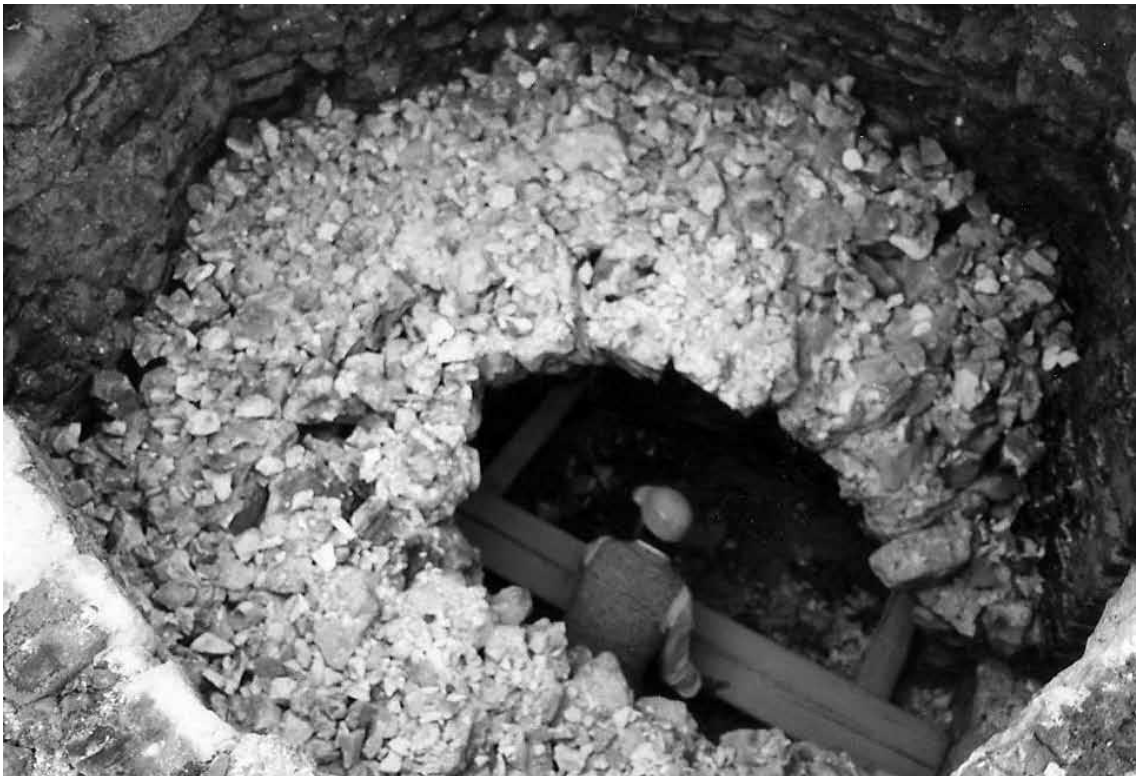
Fig. 62. Sebastián Gombau Brau, colocando una bastida para extraer cal. Archivo familiar Gombau Brau.
