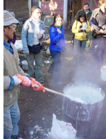
Fig. 32. Apagado de cal.
