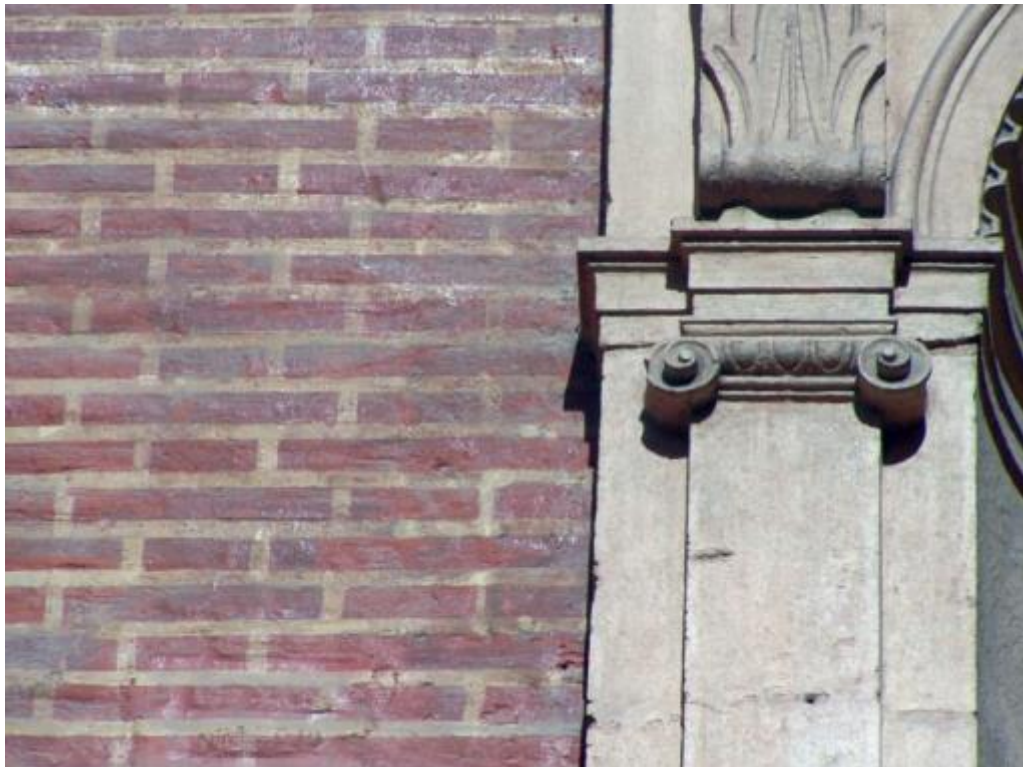
Fig. 139. Detalle de revoco fingido, emulando aparejo en ladrillos, para fábricas del s. XVIII. Los ladrillos en este caso son gruesos pero anaranjados, por esta razón se suelen enlucir. El tipo de aparejo es regular, con llagas y tendeles medio-finos. Palacio de la Aduana, Valencia.
