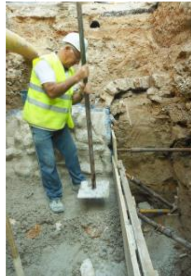
Fig. 115. Compactación de una solera de cal.
