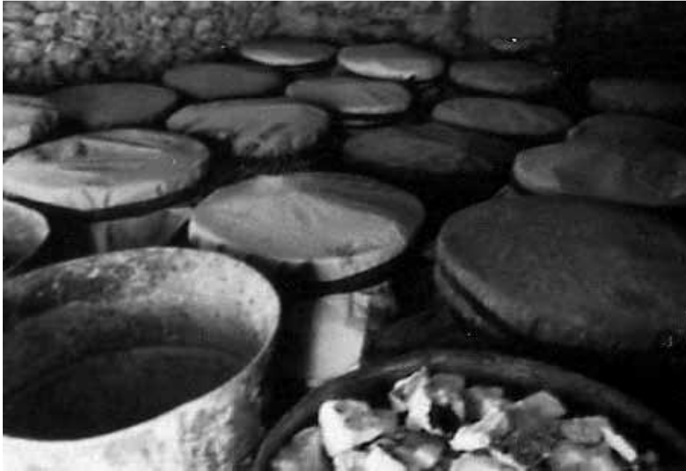
Fig. 65. Barriles de acero para almacenar la cal viva. Archivo familiar Gombau Brau.
