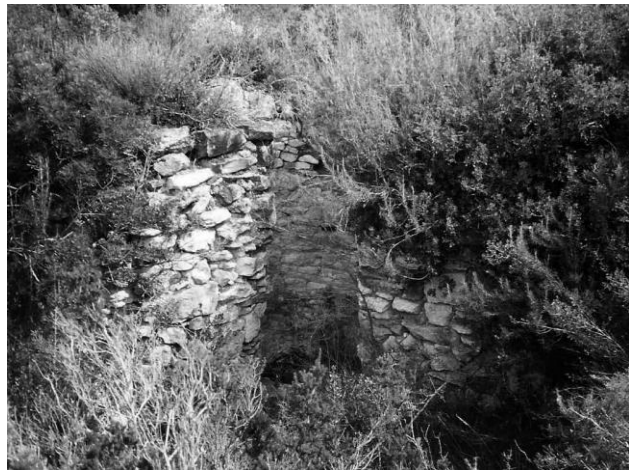
Fig. 52. Antiguo horno de cal en Vinaròs.
