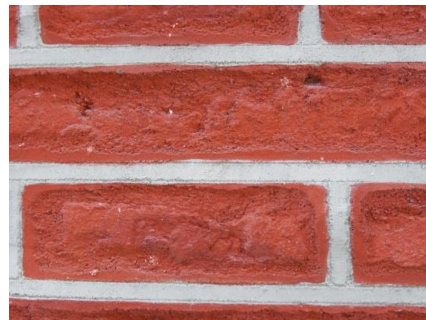
Fig. 142. Fingido de ladrillo rehundido y avitolado, con un intenso color almagra. Iglesia de los Santos Martires.
