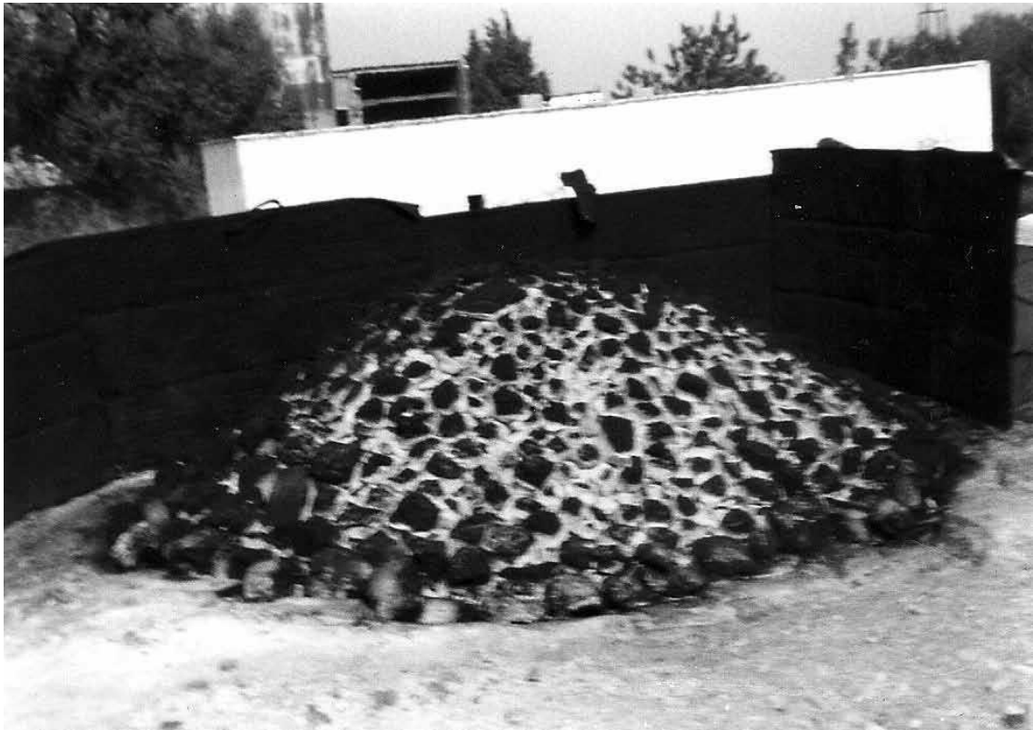
Fig. 71. El horno de los Gombau Brau, tras finalizar la fase de cocción. Archivo familiar Gombau Brau.
