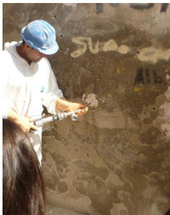
Fig. 110. Inyección de lechada de cal en muros. Lorca.
