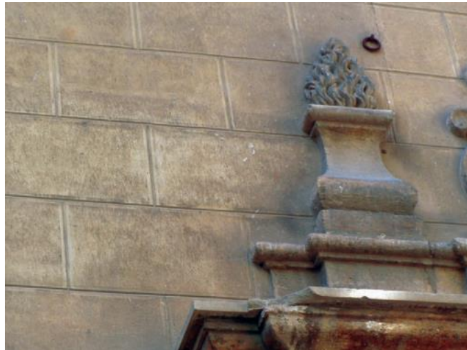
Fig. 136. Detalle de revoco fingido, emulando sillería, para fábricas de ladrillo irregulares. Los ladrillos bajo la capa de enlucido suelen ser claros, con gruesos reducidos. Los tendeles son muy marcados mientras que las llagas son bastante finas. Sacristía de la Iglesia de San Esteban, Valencia.
