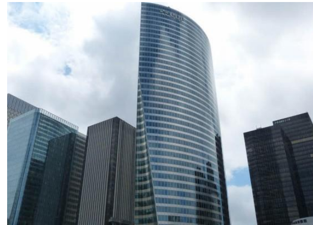
Ilustración 29 Torre EDF. La Défense France. Le guide architecture.
