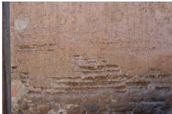
Imagen 58. Muro tapia calicostrada (Montalbán)
