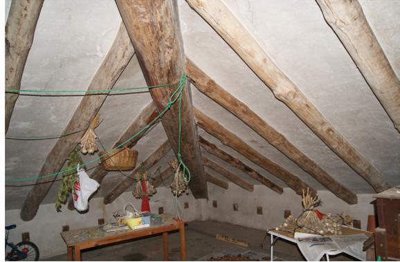
Imagen 97. Cubierta correas y yeso (Montalbán)
