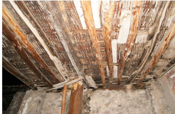
Imagen 94. Cubierta correas y cañizo (Montalbán)
