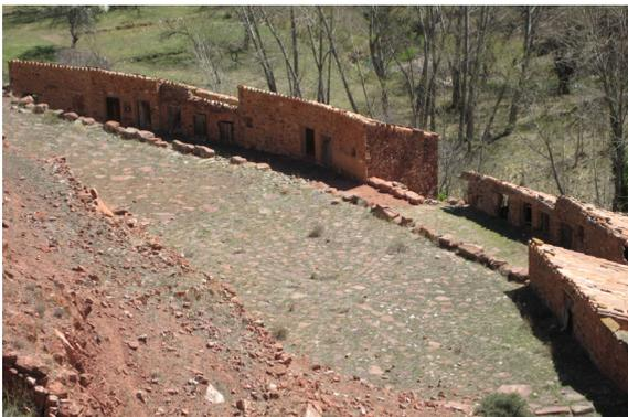
Imagen 51. Zona de las eras. Pavimento de empedrado radial de losas de rodano
