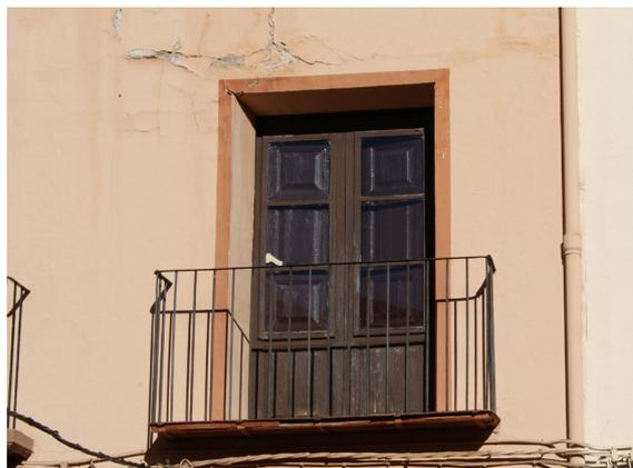
Imagen 120. Ventanas con fraileros (Montalbán)
