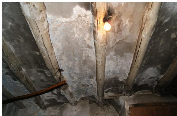
Imagen 74. Forjado revoltón yeso y cañizo (Montalbán)
