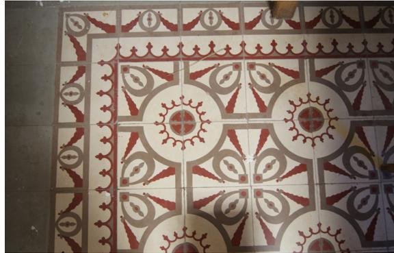
Imagen 76. Pavimento de baldosas hidráulicas (Montalbán)
