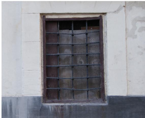
Imagen 124. Reja metálica con marco de madera (Montalbán)
