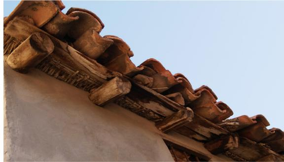
Imagen 101. Alero de cañizo con rastrel anti deslizamiento (Montalbán)
