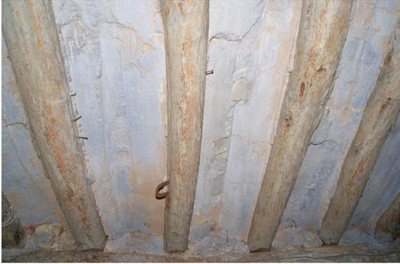
Imagen 71. Forjado revoltón yeso y tablas (Montalbán)
