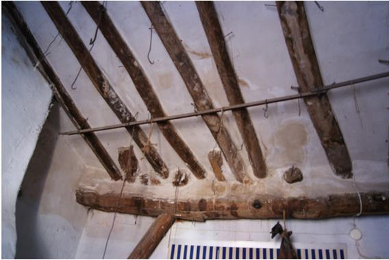
Imagen 96. Cubierta correas y yeso (Montalbán)
