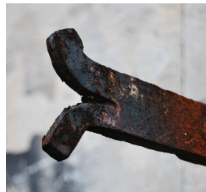
5.24. Rajado de una pletina para crear una garra de anclaje a la fábrica.
