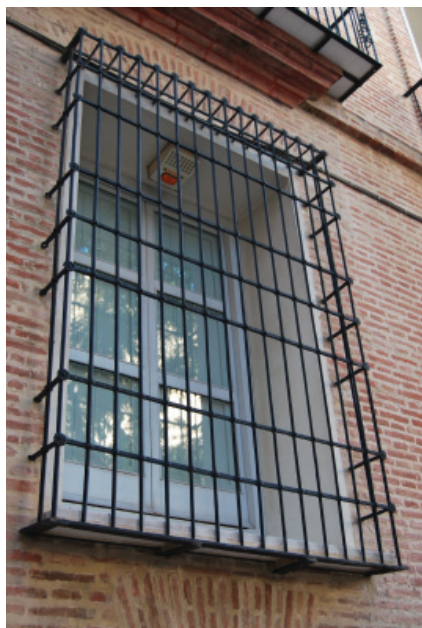
7.4. Jaula C14-02, de 1728 - 1731, en el Palacio del Intendente Pineda en la que ya aparece la solución con pletinas ocupando el plano inferior (arriba).
