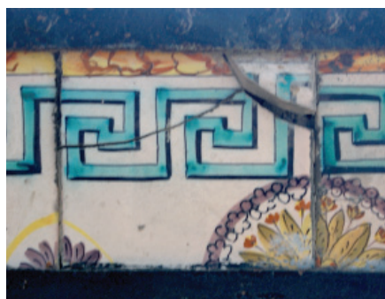
5.29. Deformación de las barras horizontales (izquierda).
