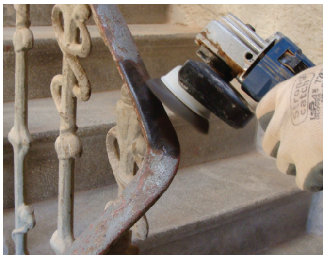
5.37 y 5.38. Eliminación del óxido mediante cepillado mecánico (izquierda) y decapante (derecha).
