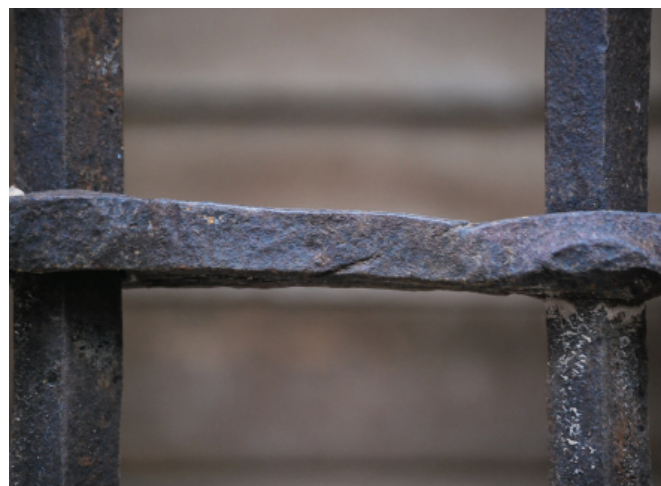
5.26. Barras unidas mediante calda en una jaula de la Casa de los Monterde en Sarrión, Teruel (derecha).
