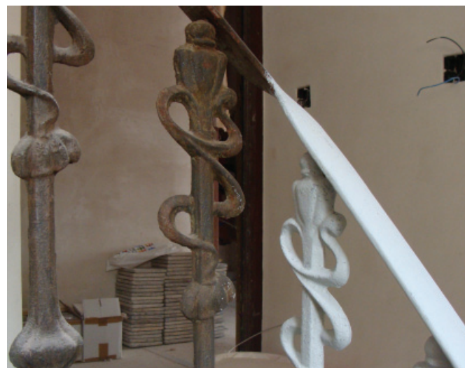
5.39 y 5.40. Eliminación del óxido mediante soplete (izquierda) y aplicación de imprimación protectora previa al entonado (derecha).
