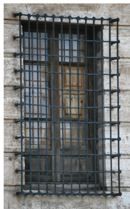
7.6 y 7.7. Jaulas V35-04, de 1756, en el Colegio de la Seda (arriba) y X30-03, de 1760 - 1770, en el Palacio Monasterio del Temple (abajo) con la distribución de barrotes horizontales propia de las jaulas de la segunda mitad del siglo XVIII.
