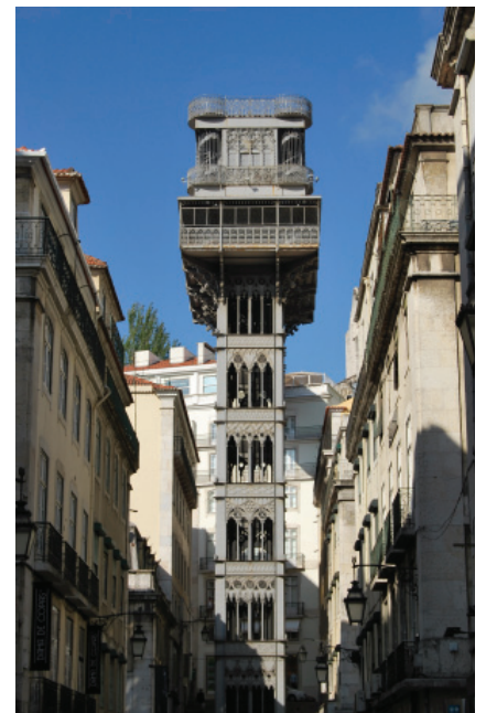
5.1 y 5.2. Elevador de Santa Justa en Lisboa (arriba) y Ponte de Dom Luis en Oporto (abajo).
