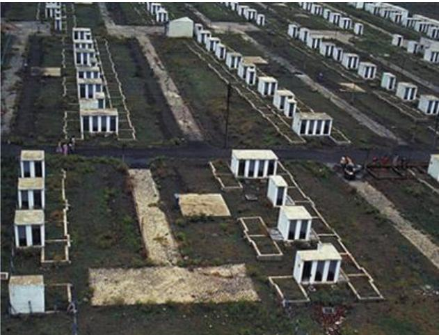
**Figura 35:** La construcción de una parte del proyecto: disposición de las fundaciones y núcleos de servicio. (Pandya, 1990)
