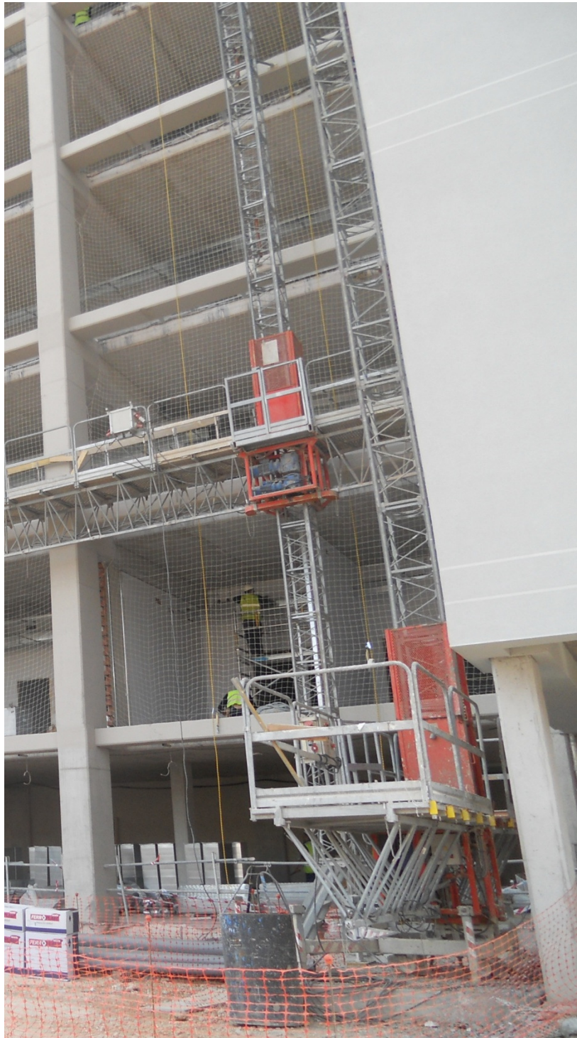
Detalle del andamio mono-mástil fachada Este. M2
