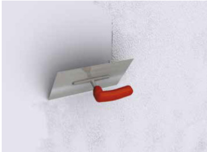
Aplicación de mortero con llana
