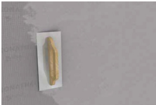
Segunda capa de mortero aplicada con llana.
