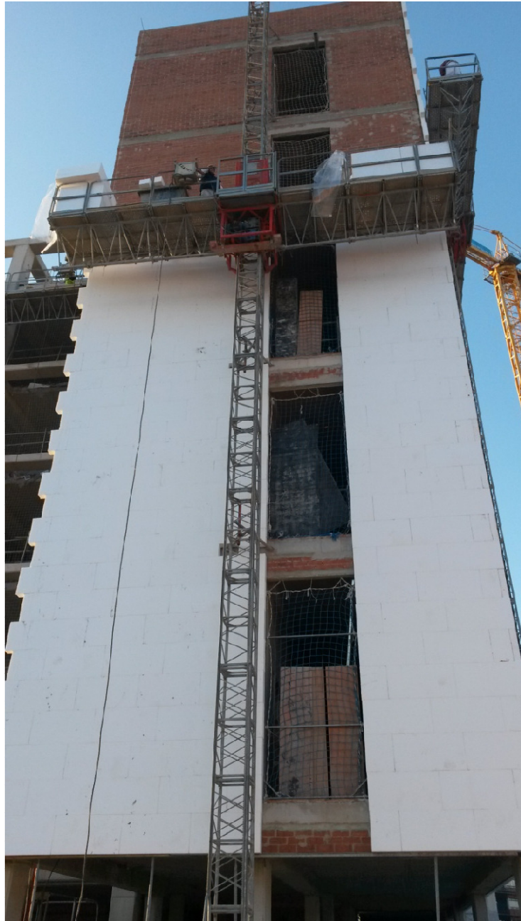
Detalle del andamio mono-mástil montado en fachada Norte. M3
