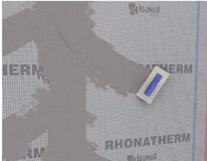
Malla embebida. Método espina de pez.
