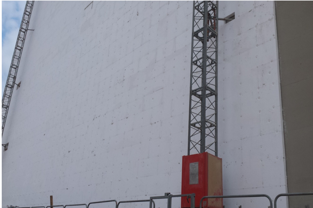
Fachada Oeste con los tacos colocados.
