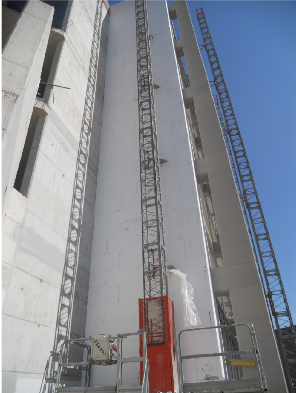
Detalle del andamio mono-mástil en fachada Oeste. M4
