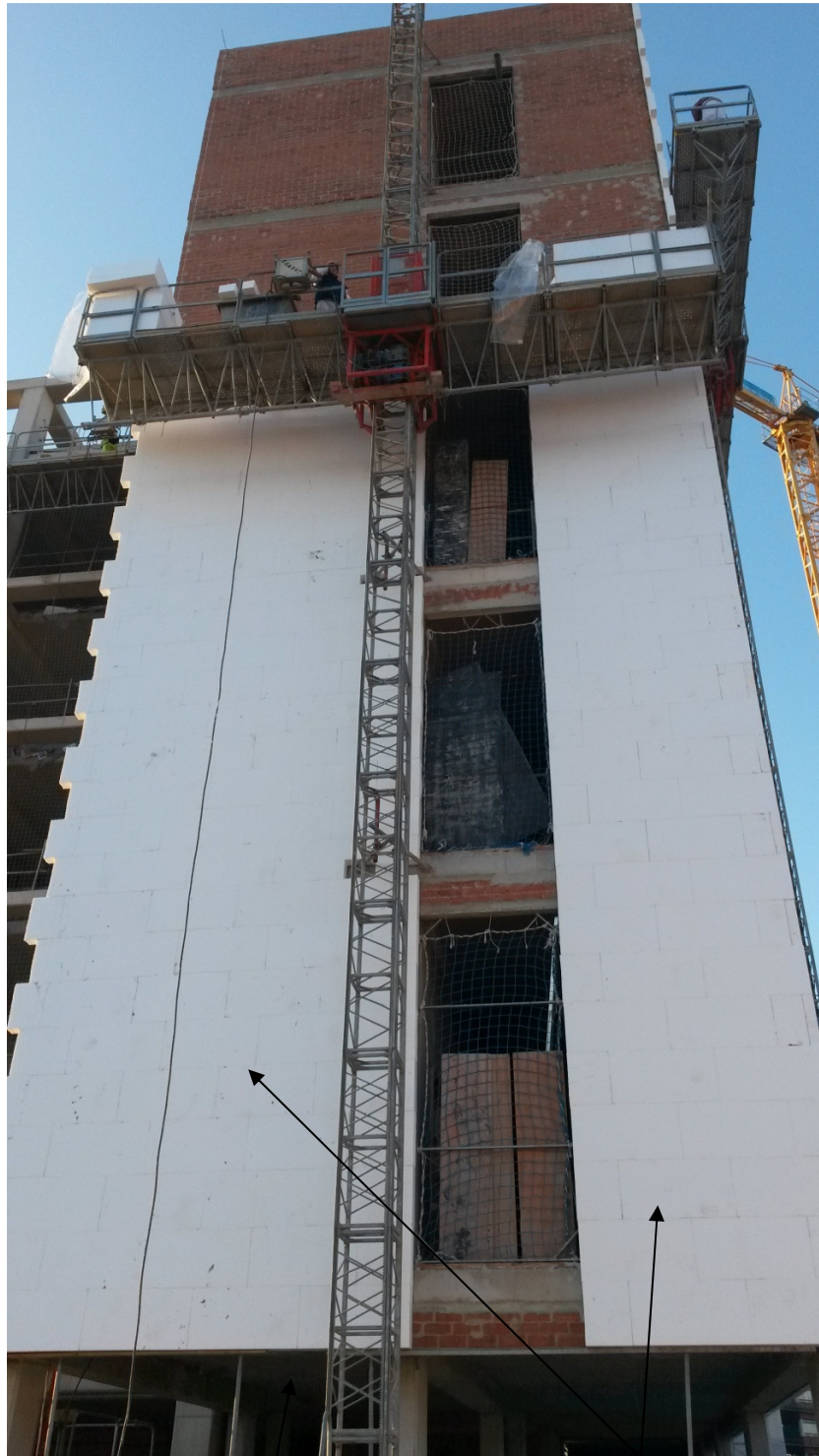
Fachada Norte, Pieza de arranque. Colocación trabada.
