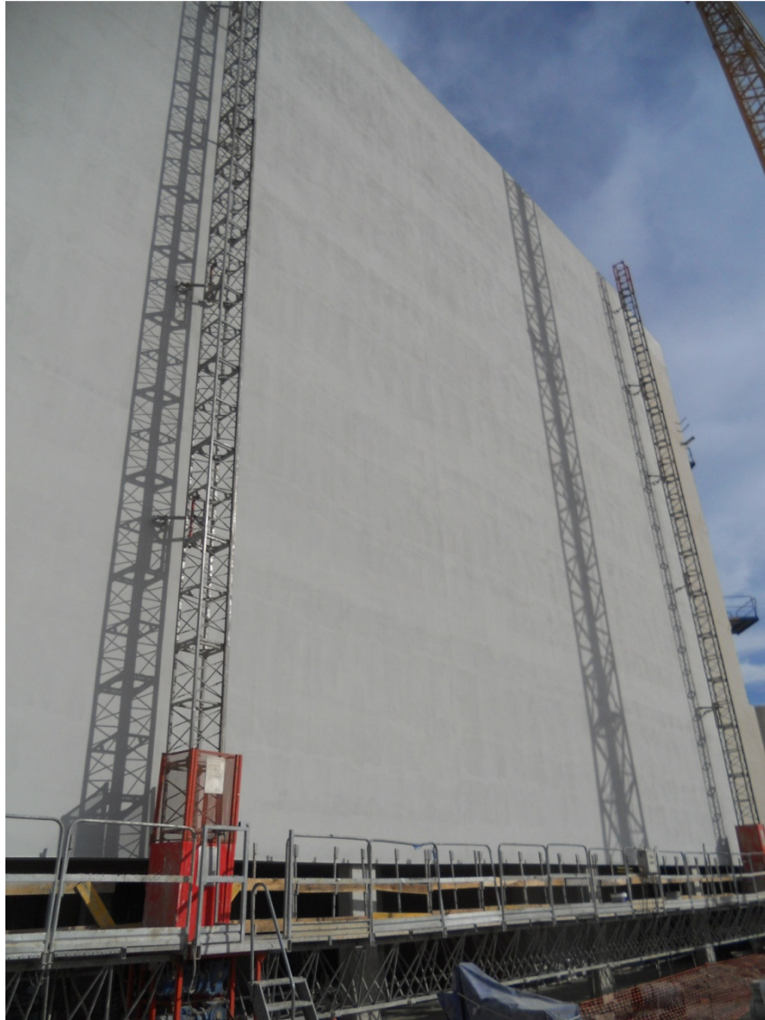
Andamio bi-mástil de cremallera empleado en Fachada Oeste 2.
