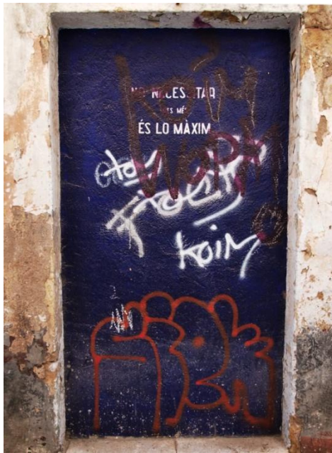
Fig 6. Obra del artista Blai Mesa en estado descuidado.
