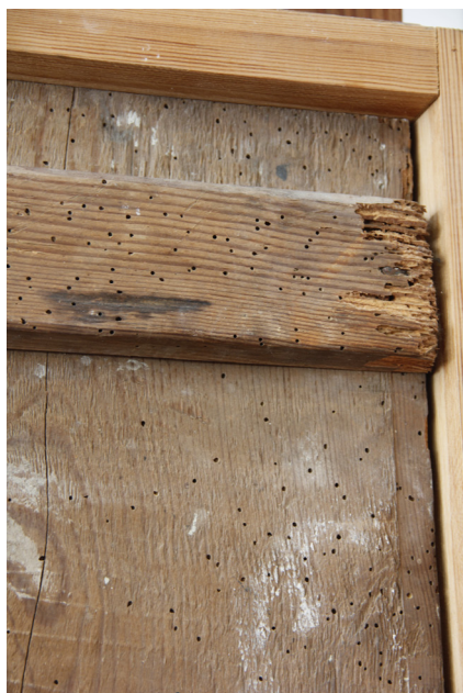
Fig.27 Detalle ataque de insectos xilófago y pérdida de soporte del travesaños.
