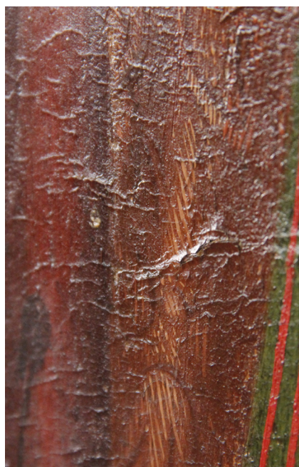
Fig.17 Detalle de un desprendimiento en forma de "cordillera".
