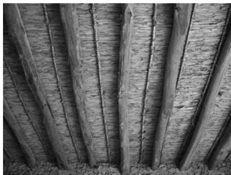
Fig. 5. Copertura costituita da travi non squadrate e struttura secondaria incanalicciata.
