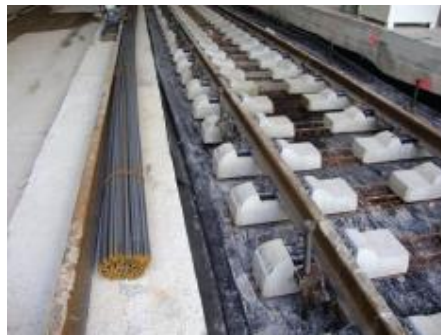
Foto 2. Vía en placa. Fuente: Rail One.GmbH.
