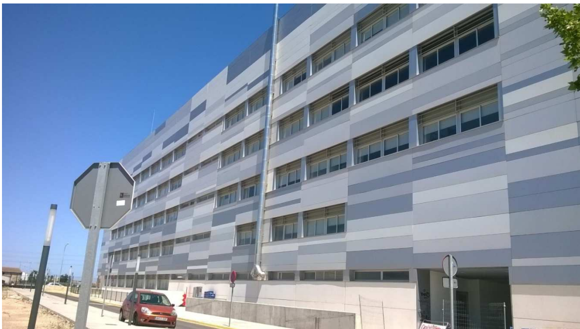
Figura 33. Edificio 3N. Fachada Oeste. Año: 2015. Fuente: Propia
