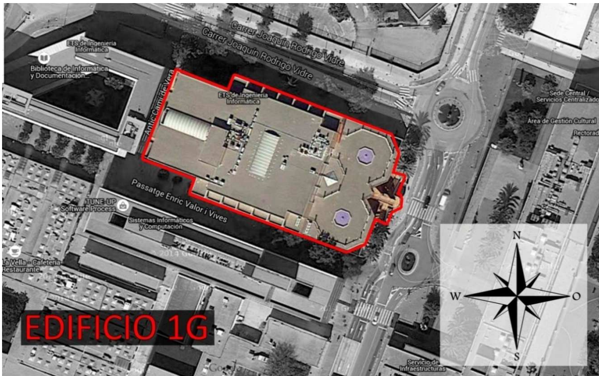
Figura 10. Edificio 1G. Situación. Año: 2015. Fuente: Google Maps.
