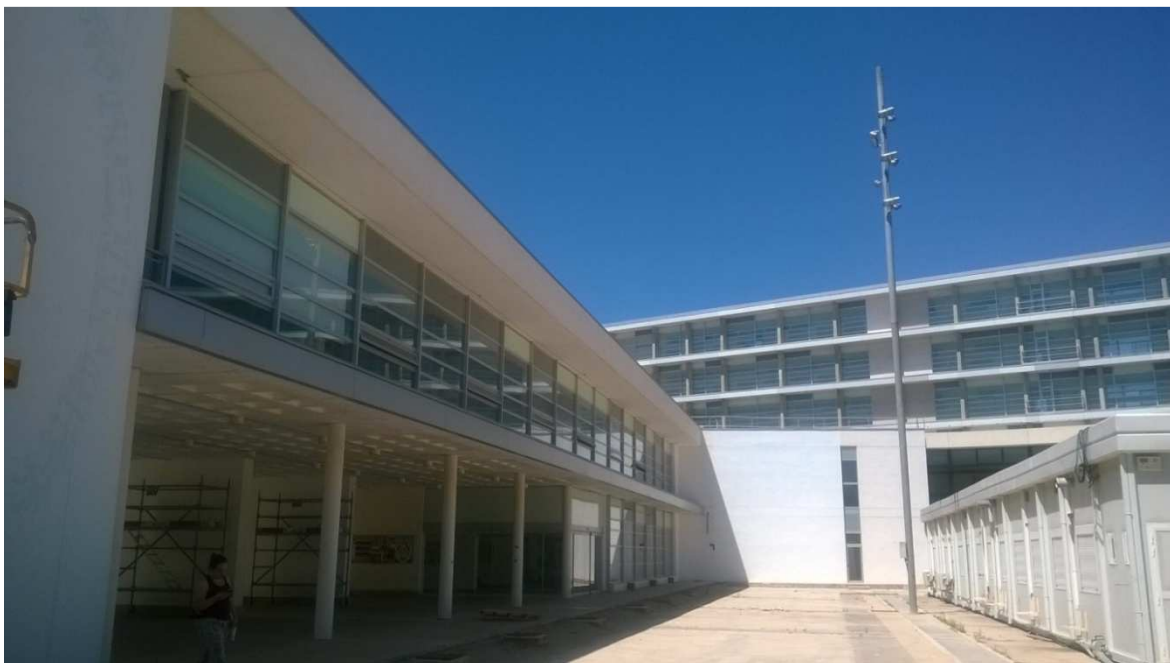
Figura 34. Edificio 3N. Fachada Este del módulo central y Sur del principal. Zona central.
