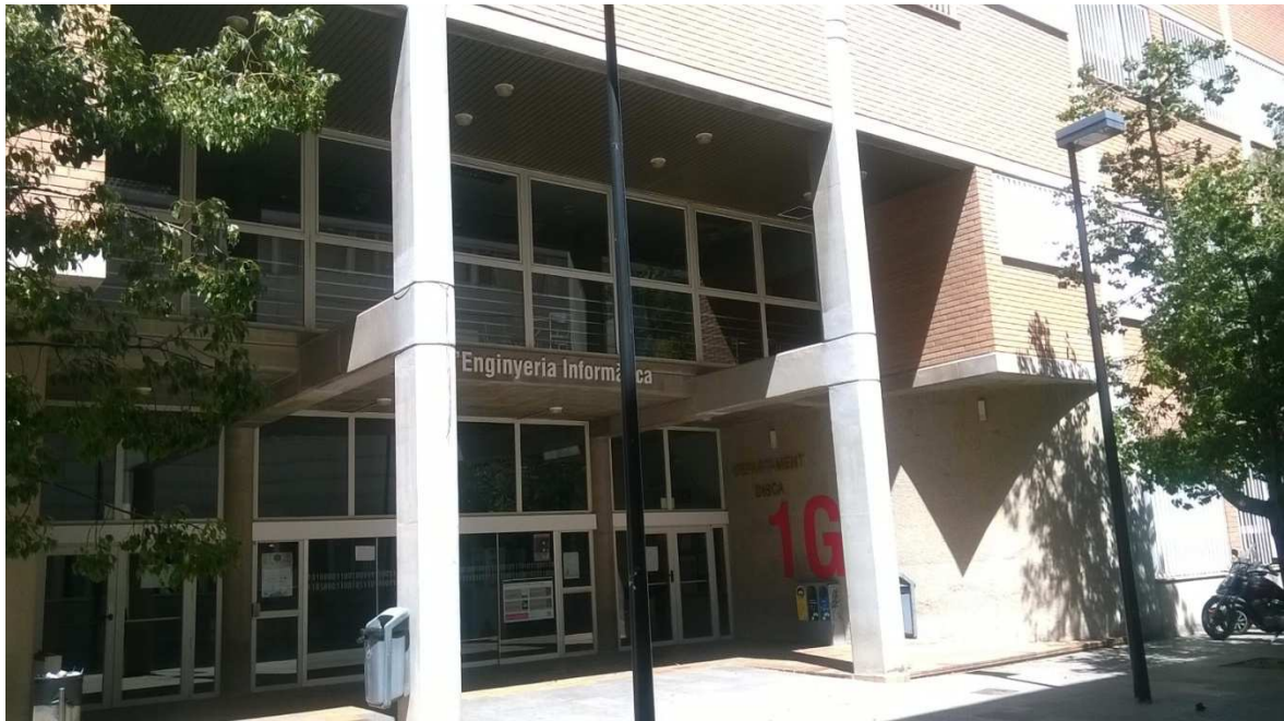
Figura 13. Edificio 1G. Entrada principal. Año: 2015. Fuente: Propia
