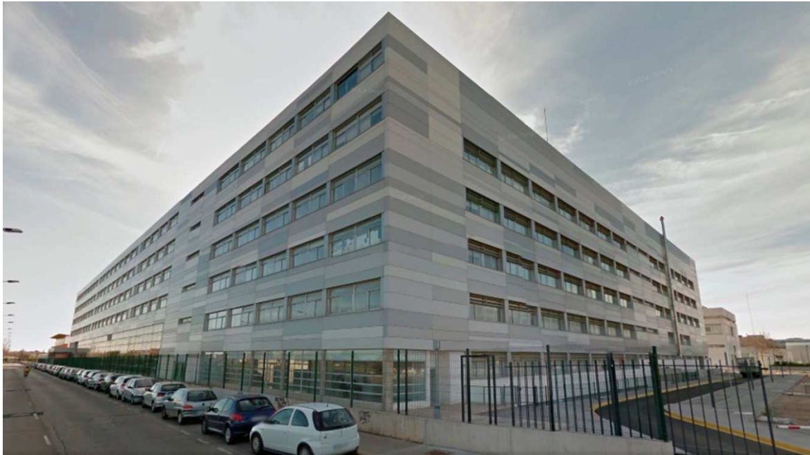
Figura 31. Edificio 3N. Fachada Norte y oeste. Año: 2015. Fuente: Google Maps.
