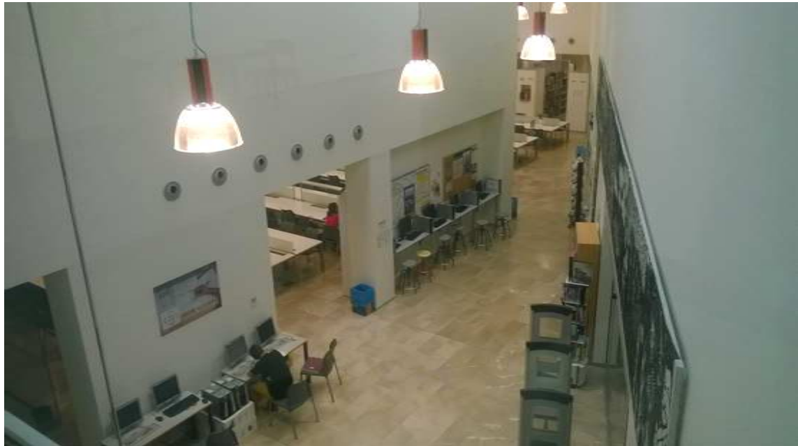
Figura 41. Edificio 3N. Interior de biblioteca. Campanas Indalux 250 W. Año: 2015. Fuente: Propia
