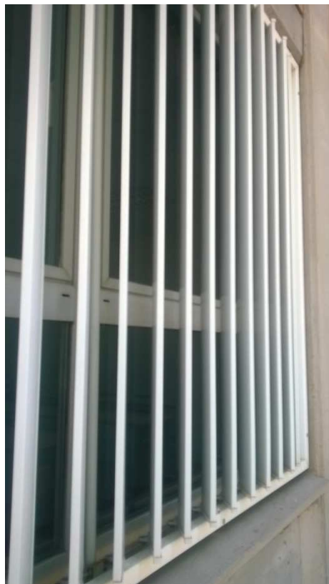
Figura 17. Carpintería exterior PVC con lamas verticales. Edificio IG. Fuente: Propia
