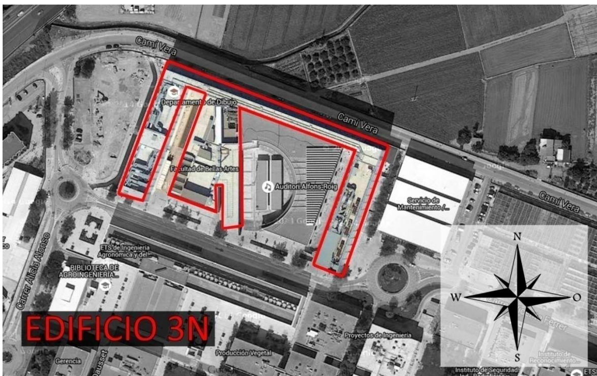
Figura 35. Situación de Edificio 3N. Año: 2015. Fuente: Google Maps.
