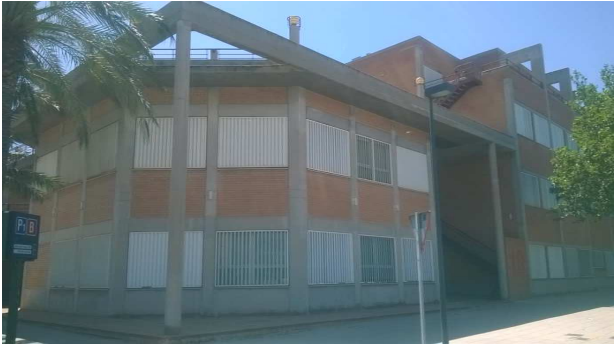
Figura 8. Edificio 1G. Esquina fachada Este y Norte. Año: 2015. Fuente: Propia
