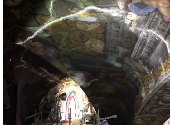
Figura 5.16 .Reparación de grieta sobre pintura mural. Espacio 6-7.
