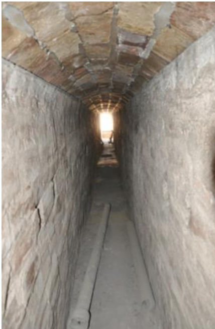
Figura 5.43. Pasillo entre la cúpula y la cubierta.
