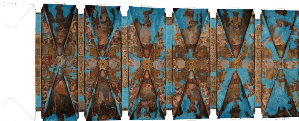
Figura 5.9. Zonas de afectación de humedades en bóveda. Iglesia de San Nicolás.
