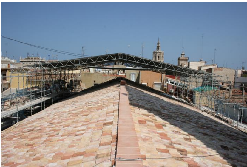
Figura 5.13. Vista general de la cubierta de tejas de la Iglesia de San Nicolás.
