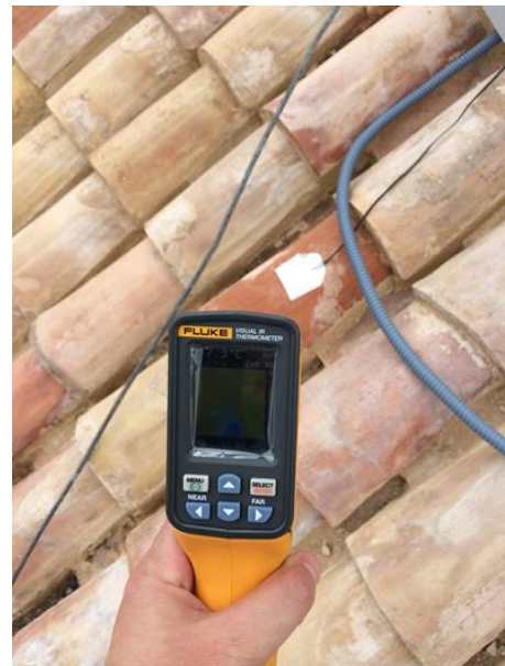
Figura 1.17. Toma de medición en Iglesia de San Nicolás (cubierta).
