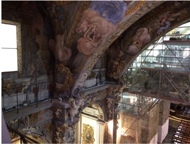
Figura 5.6. Vista parcial de la bóveda pintada. Iglesia de San Nicolás.
