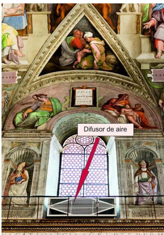
Figura 3.11. Difusor de aire bajo uno de los seis ventanales.
