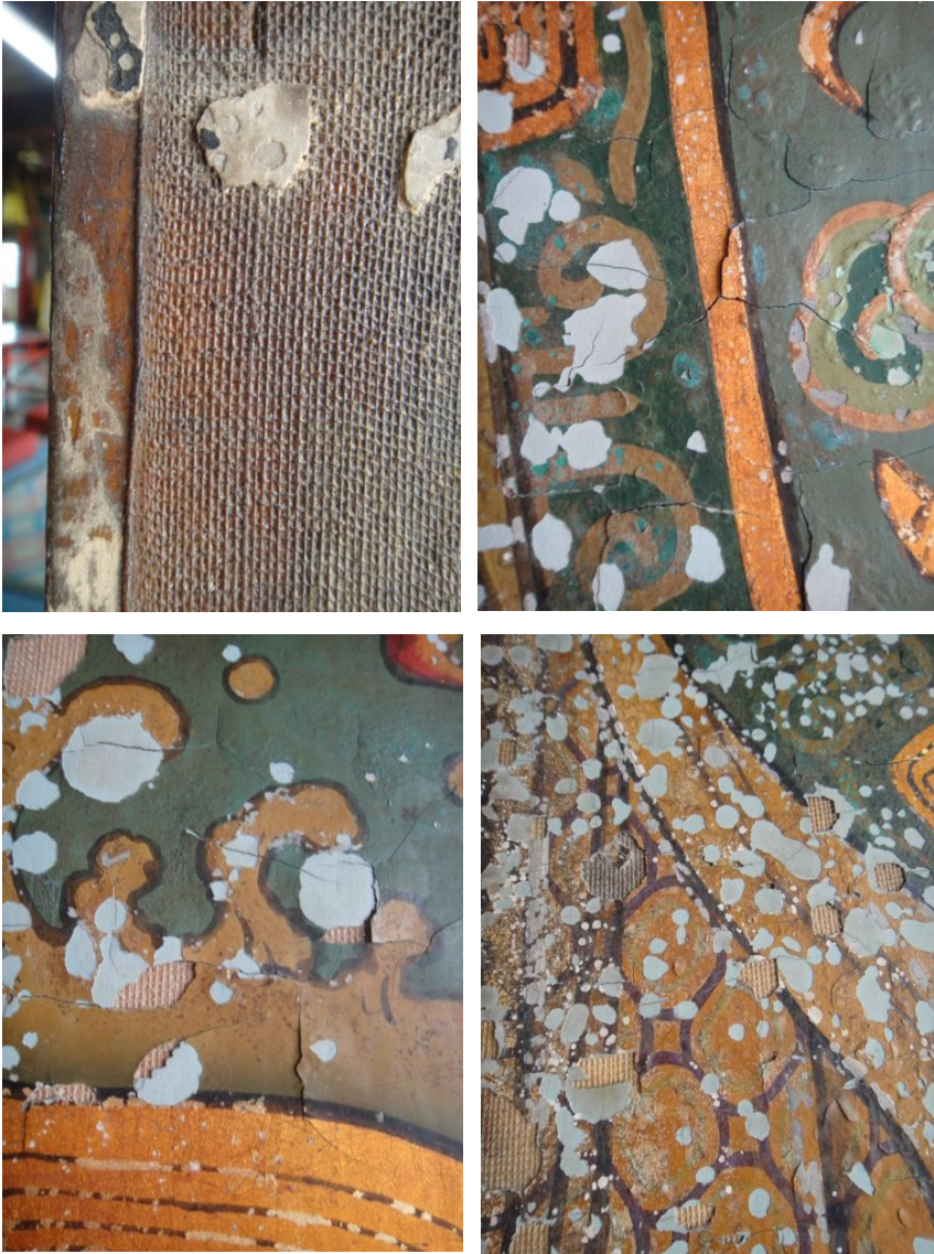
Figura 138. Detalles de las pérdidas de estructura pictórica.
