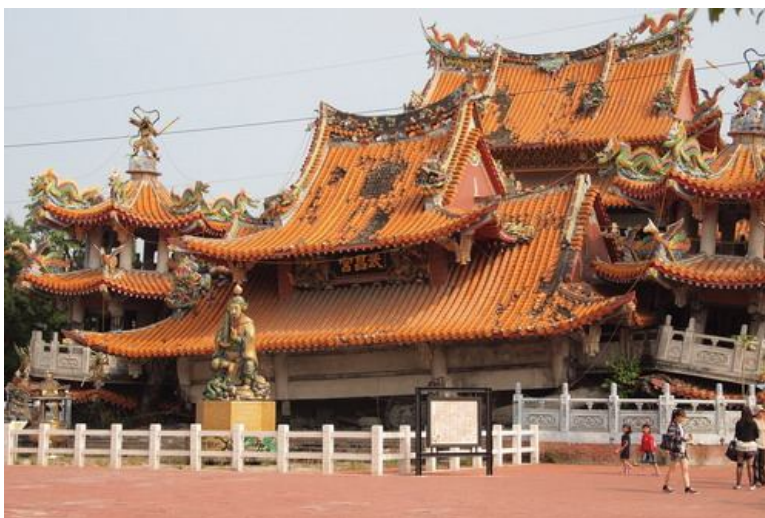
Figura 232. Templo de Wuchang (Nantou) (南投武昌宮), derrumbado por el terremoto de Chichi. 386
