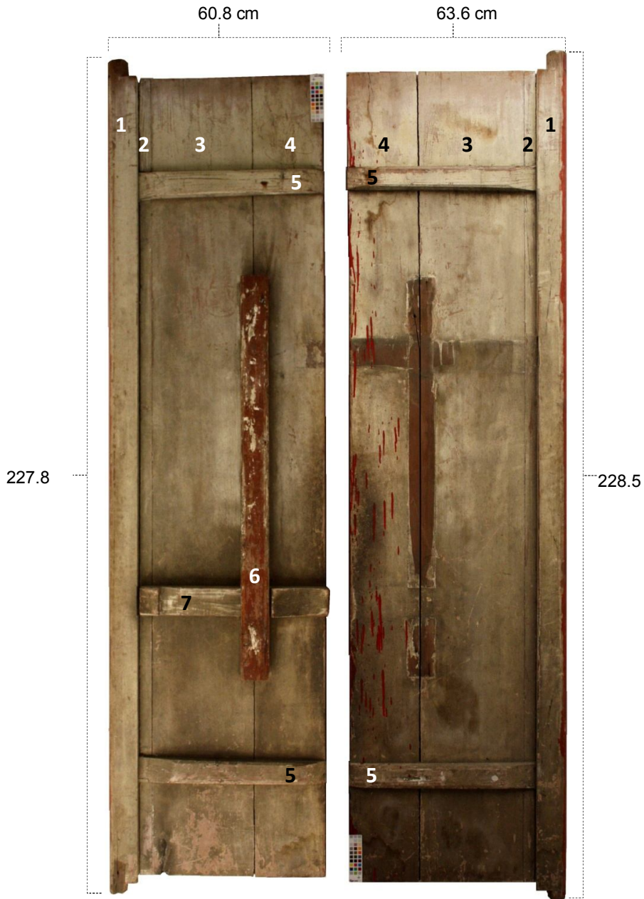
Figura 170. Estructura del soporte. 1-4. paños; 5. travesaños fijos de refuerzo; 6. pieza de madera para sujetar los pasadores; 7. travesaño móvil a modo de pasadores. Los elementos 6 y 7 de la hoja derecha están perdidos.
