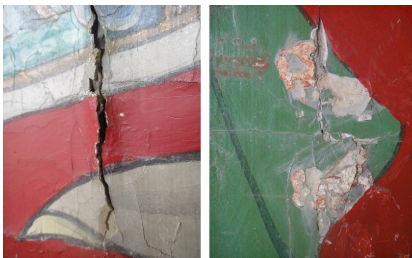
Figura 76. Detalles de grietas y pérdidas.
