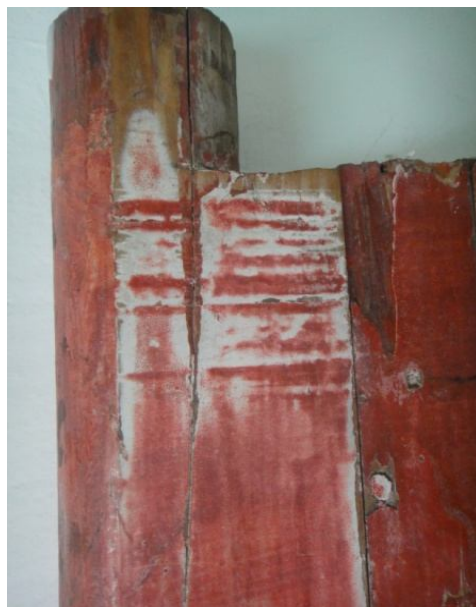
Figura 199. Abrasiones de la pintura.
