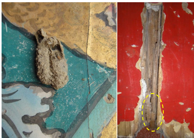
Figura 93. Detalles con signos de actividad biológica. En el óvalo amarillo se pueden ver los orificios causados por insectos xilófagos.
