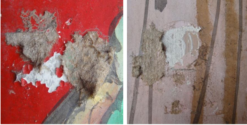
Figura 90. Residuos de los papeles adheridos. Al arrancar los papeles se han producido pérdidas de pintura.
