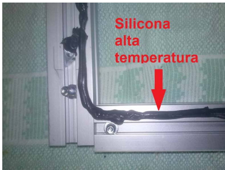
Figura 94 Aplicación de silicona sellante
