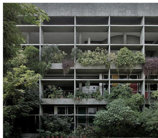
11. Soluciones de fachada con brisesoleils verticales y horizontales ajardinados y pan de verre con aerateurs A-MOA. Planos y vistas exteriores.
