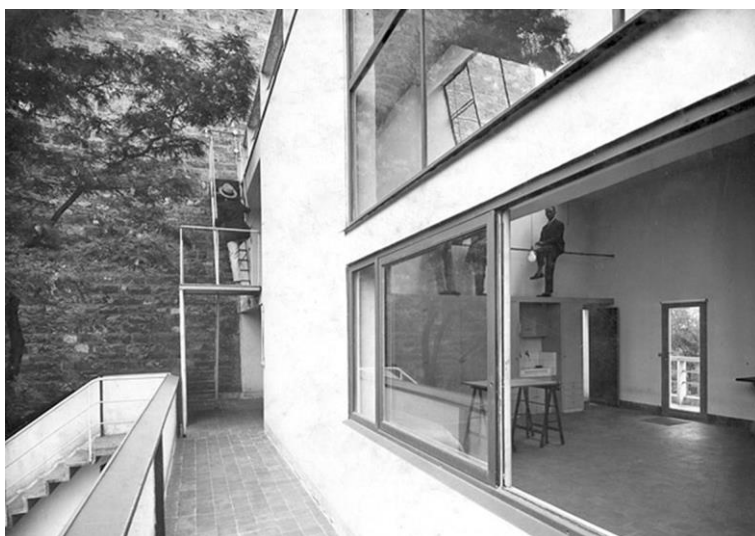
4. Casa Planeix. París 1924. Fotografía de Georges Thiriet, FLC L2(14)16. Vista tomada desde la terraza hacia la escalera exterior.
