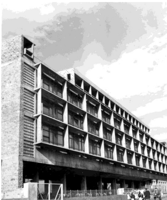
4. La fábrica de manufacturas en Saint-Dié. Fachada principal, Sudeste.
