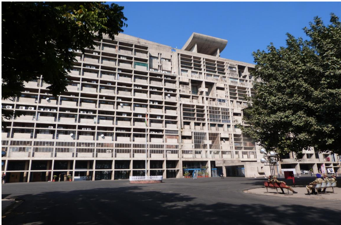
6. Fachada del edificio del Secretariado de Chandigarh.
