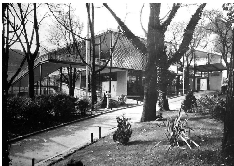
18. Pabellón de Japón, 1937. Vista desde el sur, con el acceso, la terraza restaurante y la rampa exterior de salida.
