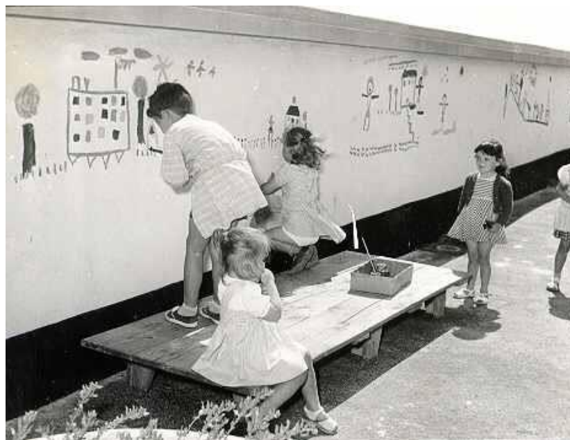
15. Decoración del antepecho que construye el límite de la cubierta. Sciarli. (FLC L1-11 77) ©FLC-ADAGP
