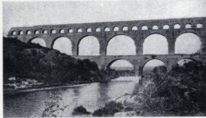
Aqueduc du Gard.
