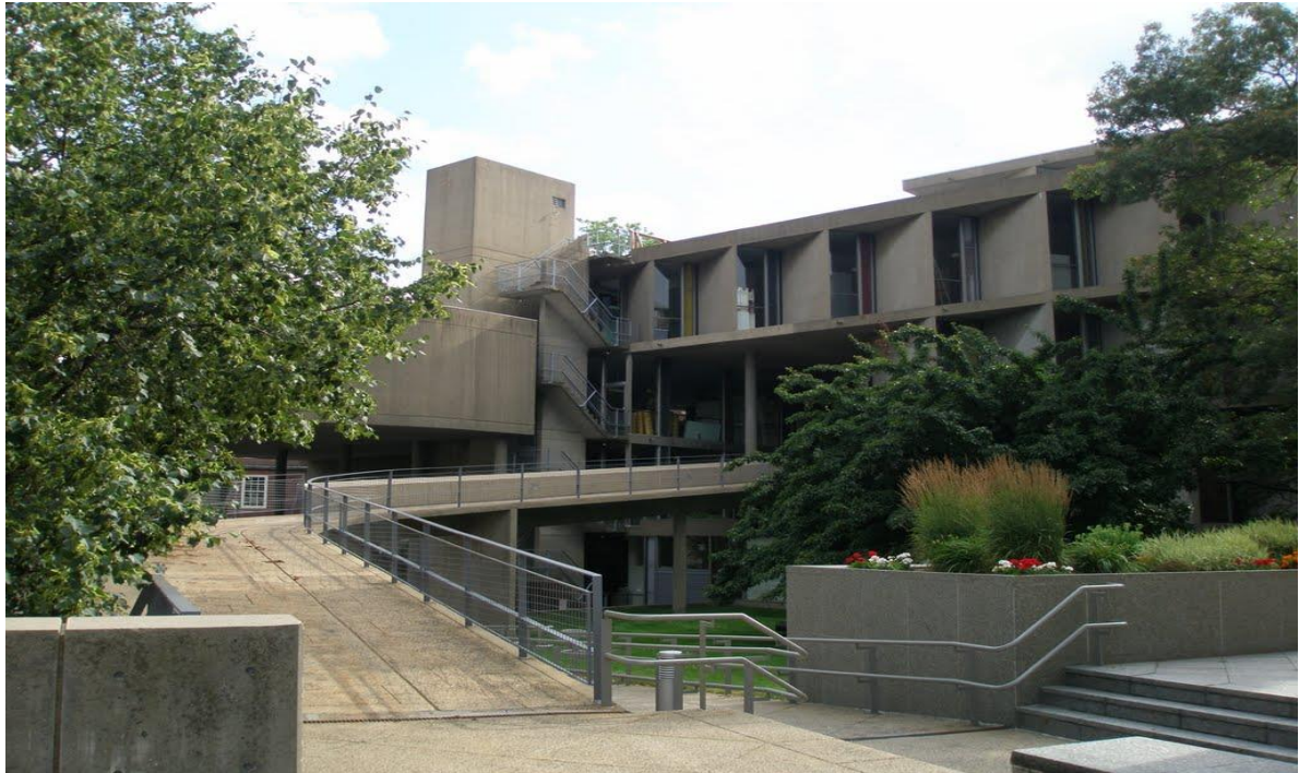
9. Fachada del Centro Carpenter de Artes Visuales.
