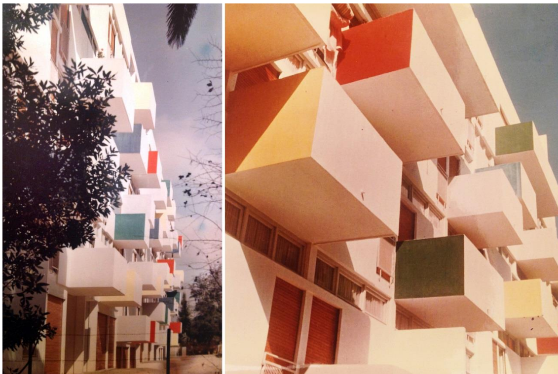
2. Immeuble à Sidi Bel Abbès, Candilis & Woods architectes, 1954
