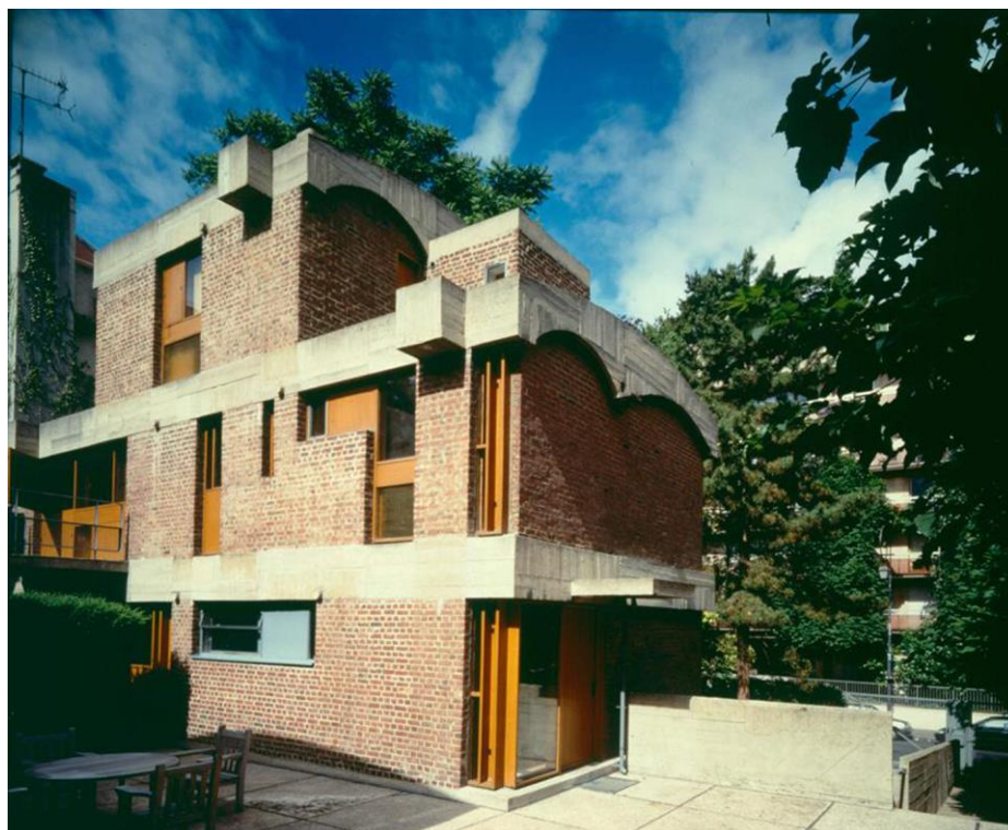
7. Le Corbusier. Vista externa de la casa Jaoul. Alternancia de hormigón y ladrillo. © FLC-ADAGP
