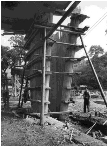
15. Encofrado de pilotis en el extremo sur del segundo sector de la Unidad de Habitación de Marsella. L1(13)1026 ©FLC-ADAGP.
