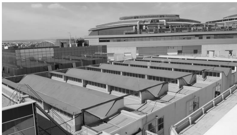
10. Cubierta del Foro Norte, única lonja existente.
