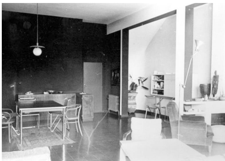
4. Maison Guette (1926). Vue de la salle à manger vers 1940.
