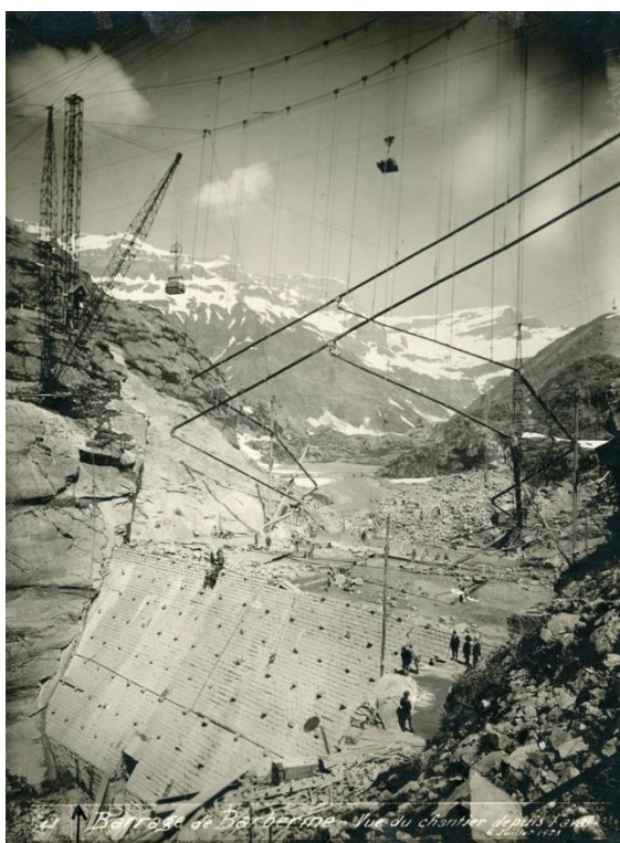
4. Le Corbusier: «la Presa». Fotografía de la construcción de la presa Barberine publicada en Urbanisme , p. 139, 1925 (©FLC-ADAGP)
