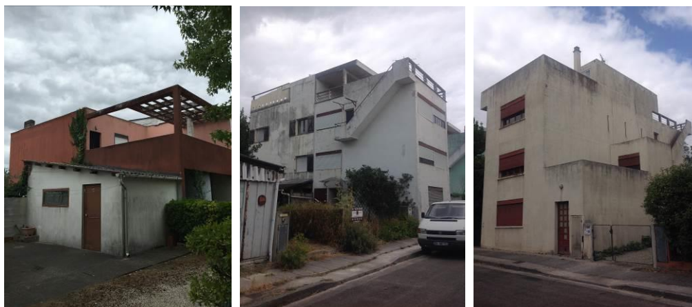
22 - 23 - 24. Quelques maisons transformées.
