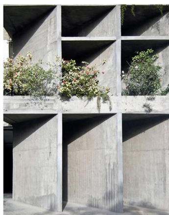
11. Soluciones de fachada con brisesoleils verticales y horizontales ajardinados y pan de verre con aerateurs A-MOA. Planos y vistas exteriores.
