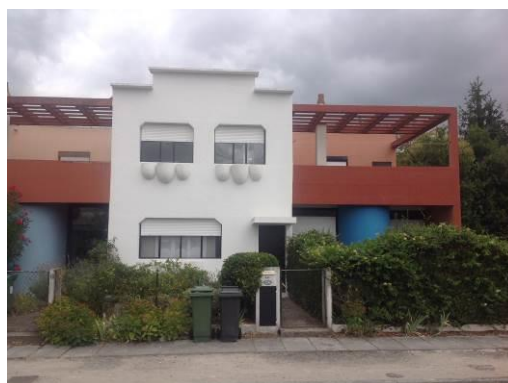
21. Une maison quinconce transformée
