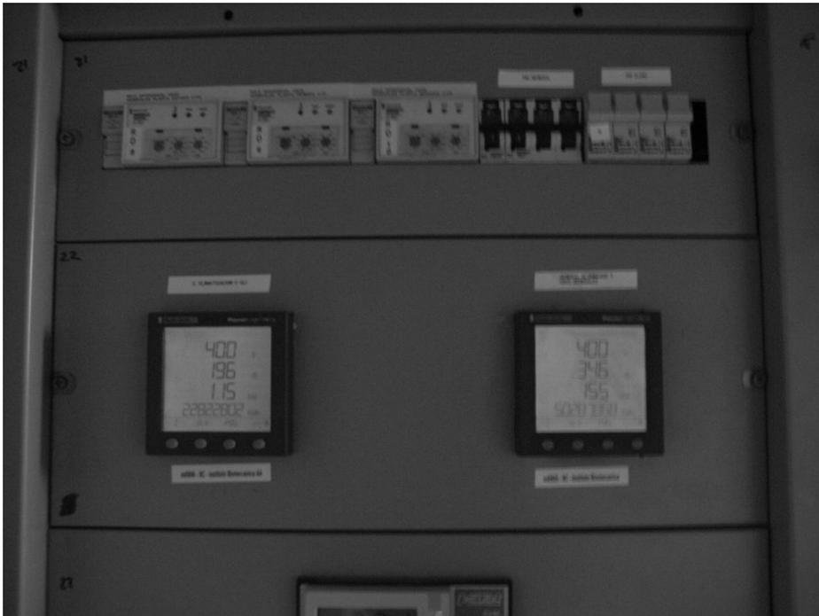
**Figura 8.6 Puntos de medida instalados en CGBT**
