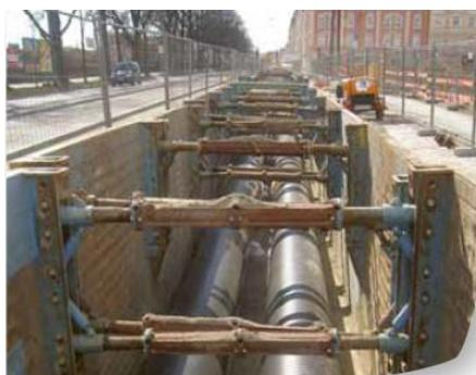
Il·lustració 4.3-12. Vista red en zanja típica dos tubos. Fuente ADHAC DISTRICLIMA
