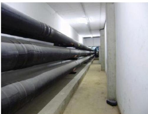
*Ilustración 4.3-10. Distribución en galería de servicio. Fuente ADHAC.*
