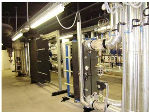
Ilustración 4.5-6. Cambiadores en subestación de gran potencia. Fuente ADHAC.
