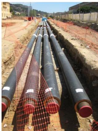
*Ilustración 4.3-1. Tubería preaislada rígida de acero. Fuente Eferterm*
