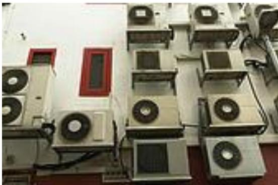
*Ilustración 1.1-1 Condensadoras de equipos de climatización individual (Split System) en fachada. Fuente ADHAC*
