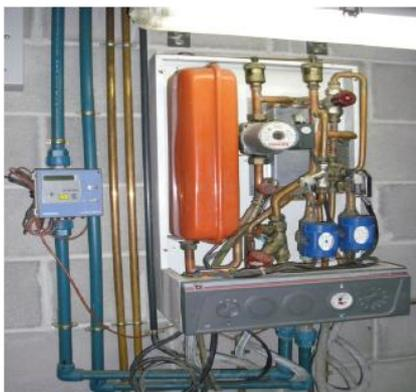
*Ilustración 4.5-8. Cambiador premontado para usuario individual. Fuente ADHAC*
