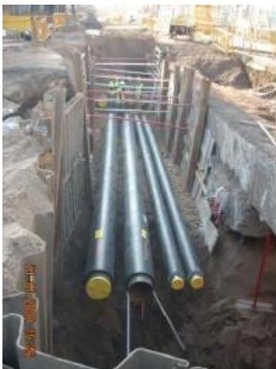
Ilustración 4.3-14. Vista red en zanja típica cuatro tubos (en línea). Fuente IDEA MINETUR.
