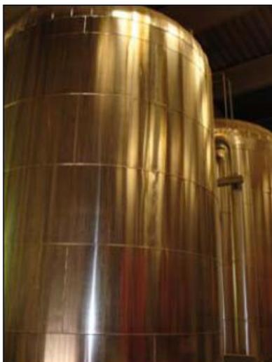
*Ilustración 4.4-4. Acumuladores de agua caliente de 100 m<sup>3</sup> (Ud). Fuente MINETUR*
