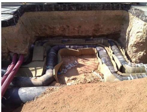
*Ilustración 4.3-2. Tubería preaislada acero. Lira de dilatación. Fuente ADHAC*
