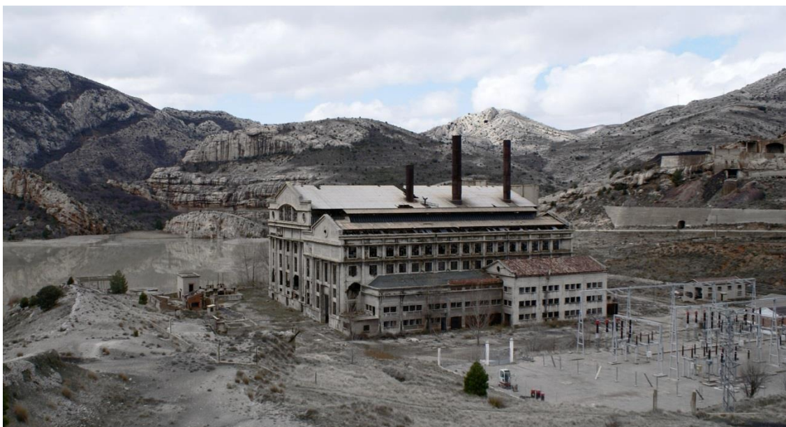
Aliaga. Embalse, central térmica y subestación eléctrica, en 2009. Fotografía: Diego Arribas.
