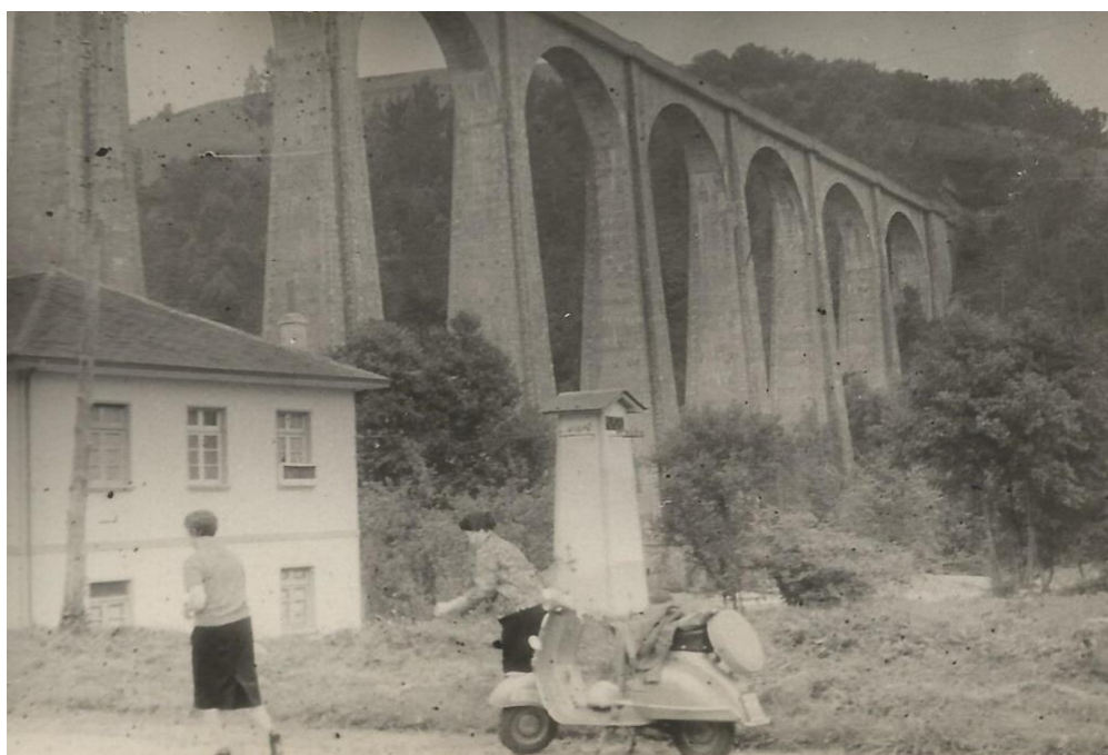
Viaducto de Artedo (Asturias) (1961). Fotografía: José Luis Arribas.
