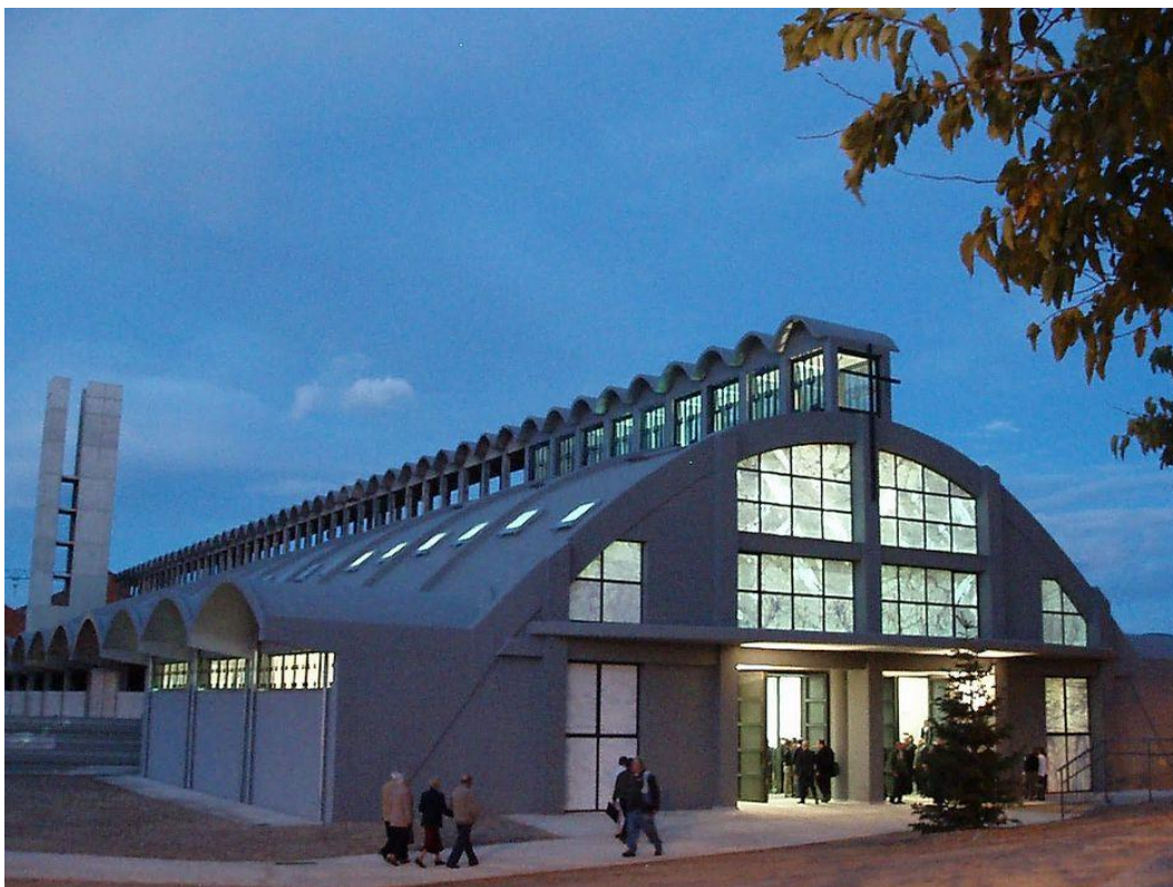
Transformación de otra de las naves de la S.A. Cros en una iglesia: la Parroquia Santuario de los Mártires Valencianos (2010). 284
