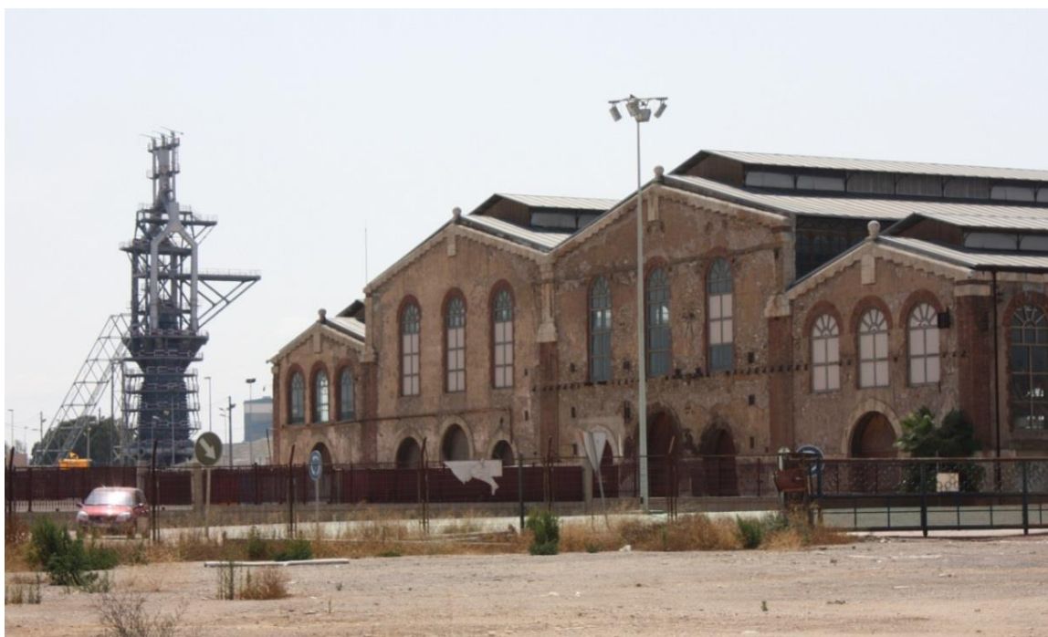
Puerto de Sagunto. Horno Alto nº 2 y Nave de Motores (2011). Fotografía: Diego Arribas
