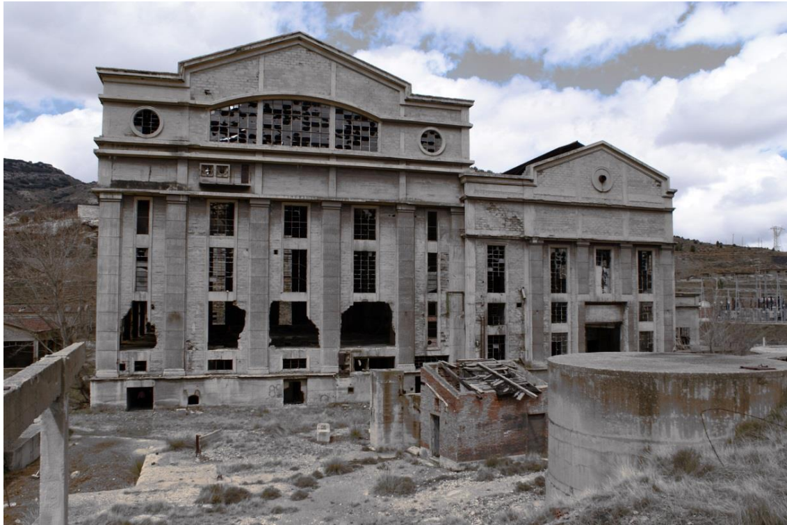
Estado de la fachada principal del edificio de la central térmica en 2009. Fotografía: Diego Arribas.
