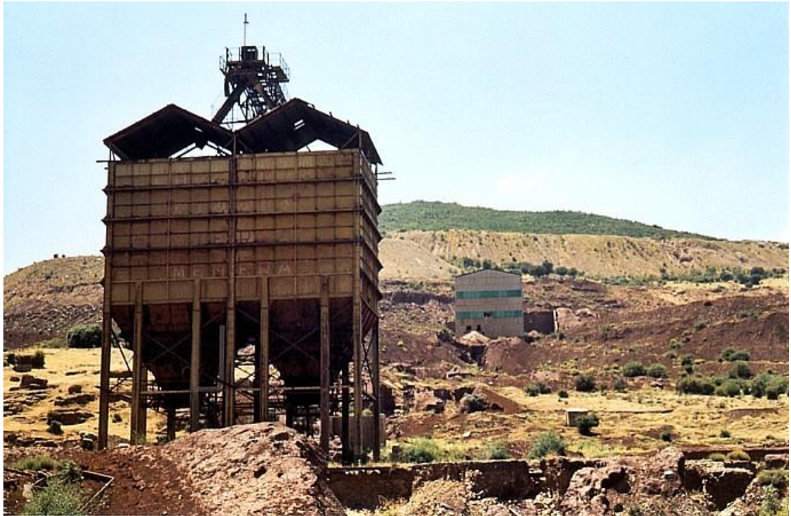
Sierra Menera. Tolvas de carga sobre vagón y nave de clasificación de mineral (2000). Fotografía: Diego Arribas.
