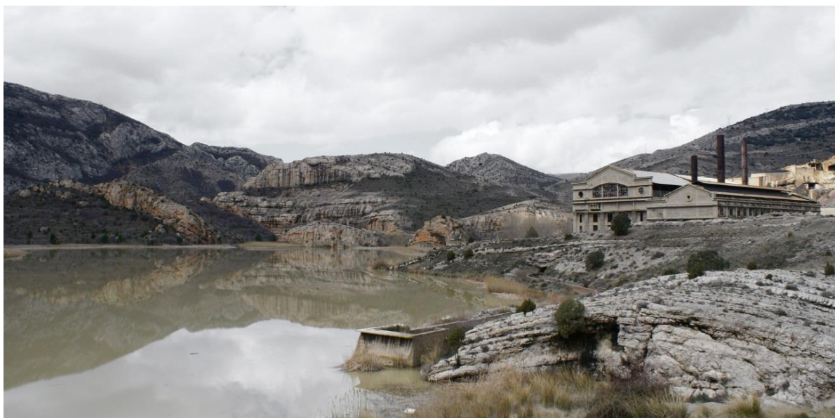
Embalse y central térmica en la actualidad (2009). Fotografía: Diego Arribas.
