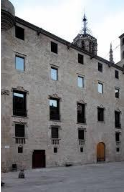
Figura II.12. Archivo de la Corona de Aragón. Palacio de los Virreyes. Edificio del siglo XVI de estilo renacentista. Fachada de la plaza del Rey. Fuente: www.mecd.gob.es
