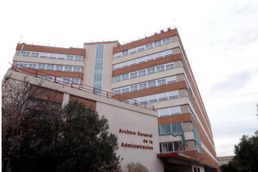
Figura II.15. Archivo General de la Administración. Alcalá de Henares. Fuente: www.mecd.gob.es
