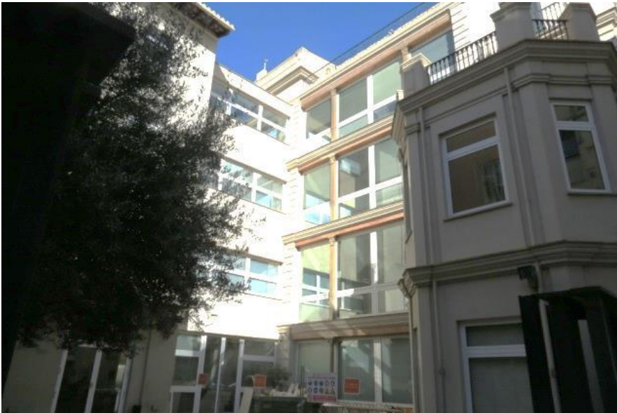
FiguraIII.181.Acceso posterior al edificio de las Cortes Valencianas. Fuente: autor.
