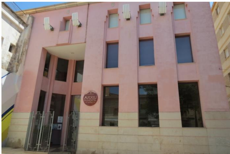
Figura III.21. Fachada principal del edificio. Fuente: autor.
