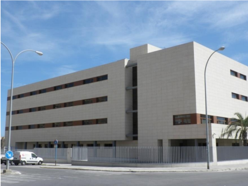
Figura III.135. Fachada oeste. Ubicación del depósito. Fuente: autor
