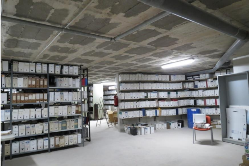
Figura III.124. Sótano de la biblioteca que actúa como depósito. Fuente: autor
