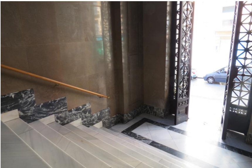
Figura III.17. Escalera de acceso a biblioteca y archivo municipal
