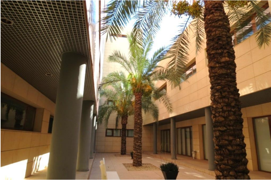
Figura III.140. Patio interior que marca la división entre área pública y área reservada. Fuente: autor
