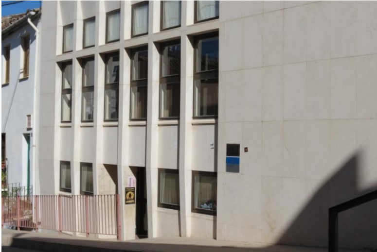
Figura III.75. Fachada del edificio anexo al Ayuntamiento que alberga biblioteca y archivo municipal.
