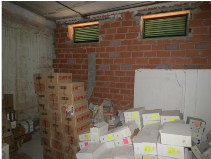
Figura III.102. Área reservada. Almacén en el pasillo de acceso de documentos en planta baja. Fuente: autor.
