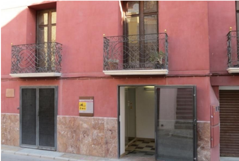
Figura III.41. Fachada principal y acceso. Fuente: autor
