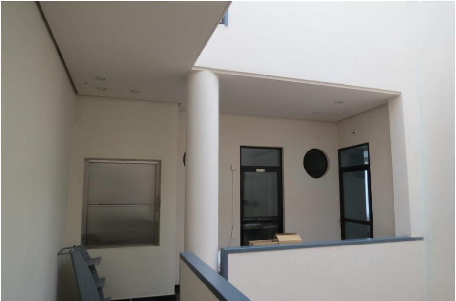
Figura III.129. Distribuidor planta primera. Montacargas de documentos. Fuente: autor.
