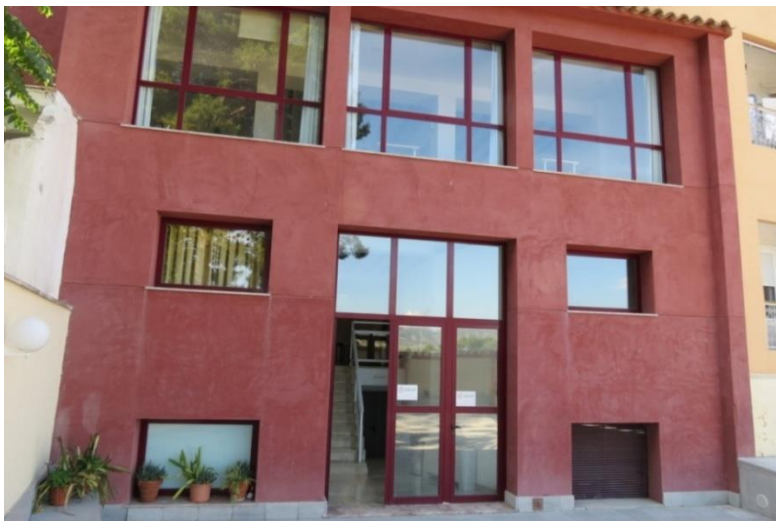
Figura III.42. Fachada posterior y acceso a patio. Fuente: autor
