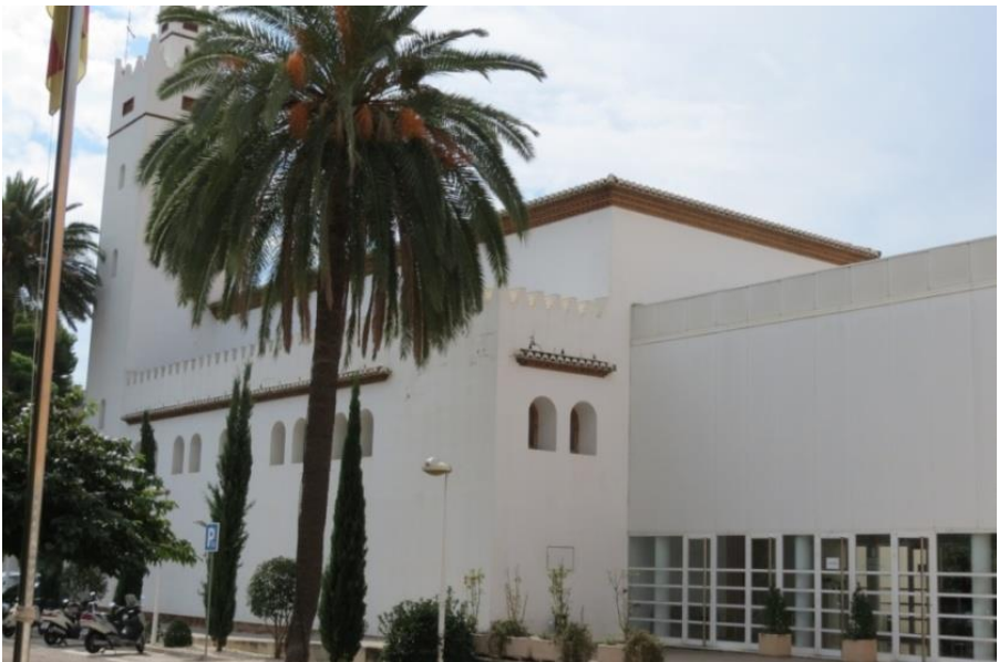
Figura III.191. Vista exterior del Archivo y ermita colindante acondicionada actualmente como salón de actos. Fuente: autor
