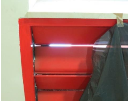
Figuras III.113 y III.114. Lamas regulables en hueco de ventilación de fachada en el depósito, cuyo deterioro dificulta su cierre y por tanto la adecuación de la temperatura y facilita la entrada de polvo, que repercute en la conservación de los documentos. Fuente: autor.
