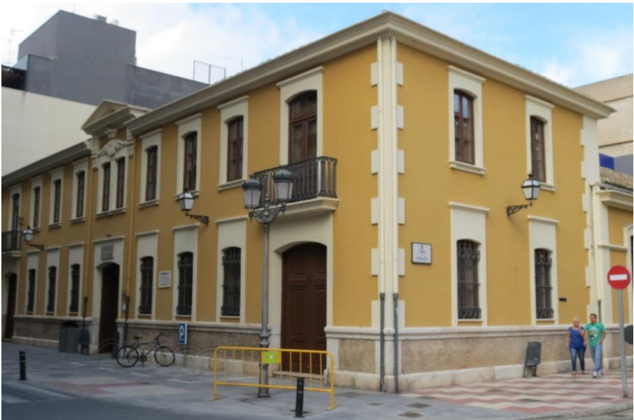
Figura III.81. Edificio que alberga biblioteca pública y archivo municipal. Fuente: autor
