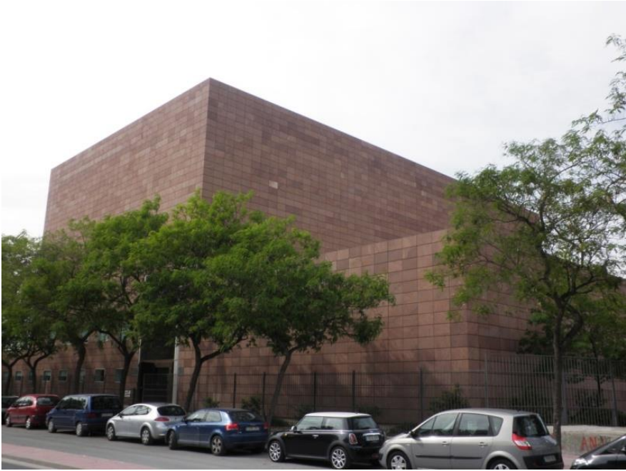
Figura III.202. Vista general del edificio. Fuente: autor.
