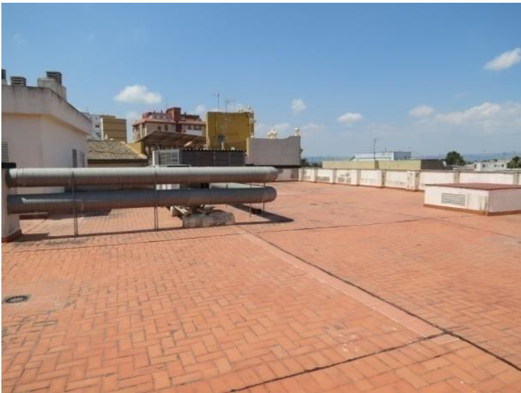
Figura III.117. Azotea transitable con conductos de instalaciones y cuarto de máquinas. Fuente: autor
