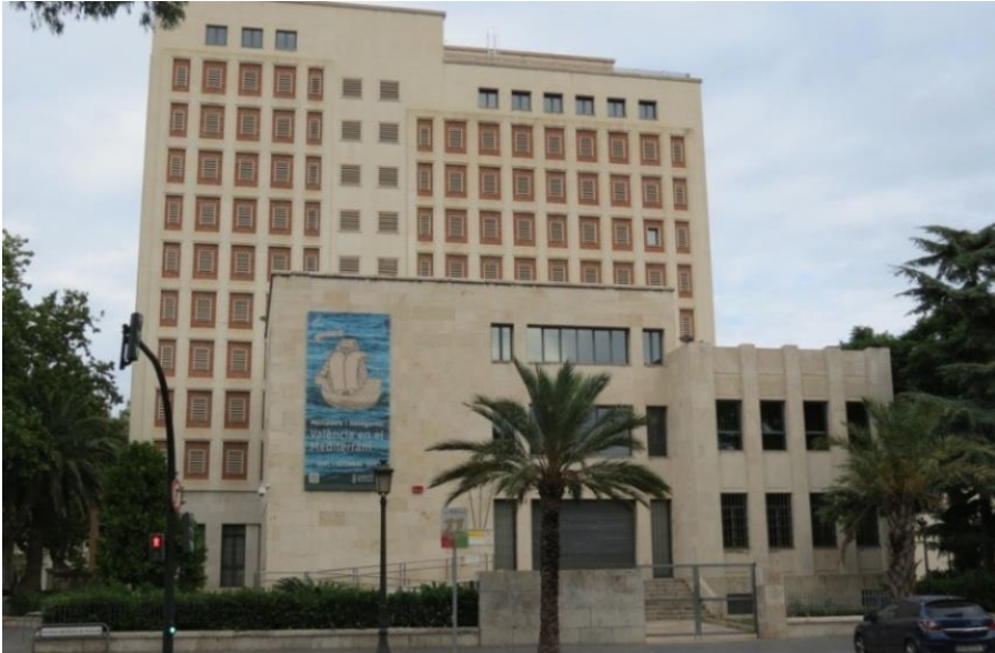
Figura III.165. Fachada principal del edificio. Fuente: autor
