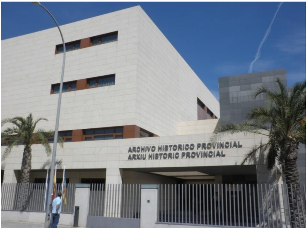
Figura III.134. Fachada sur. Acceso al edificio. Fuente: autor
