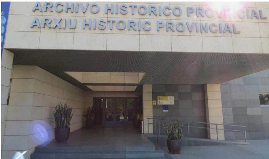
Figura III.136. Acceso al edificio. Fuente: autor
