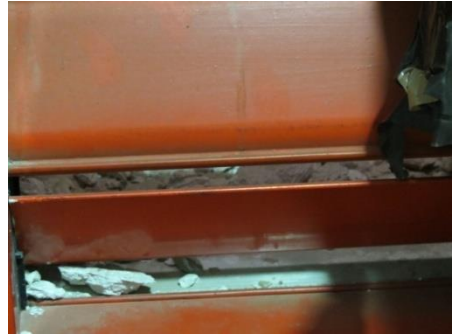
Figuras III.113 y III.114. Lamas regulables en hueco de ventilación de fachada en el depósito, cuyo deterioro dificulta su cierre y por tanto la adecuación de la temperatura y facilita la entrada de polvo, que repercute en la conservación de los documentos. Fuente: autor.
