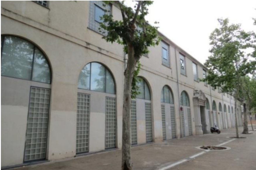
Figura II.24. Archivo de la Diputación de Valencia. Archivo General y fotográfico. Rehabilitación del Pabellón de Privados del Sanatorio Psiquiátrico Padre Jofré, instalado en el antiguo Convento de Religiosos Franciscanos de Santa María de Jesús. Ubicación en ensanche de Valencia. Fuente: autor.
