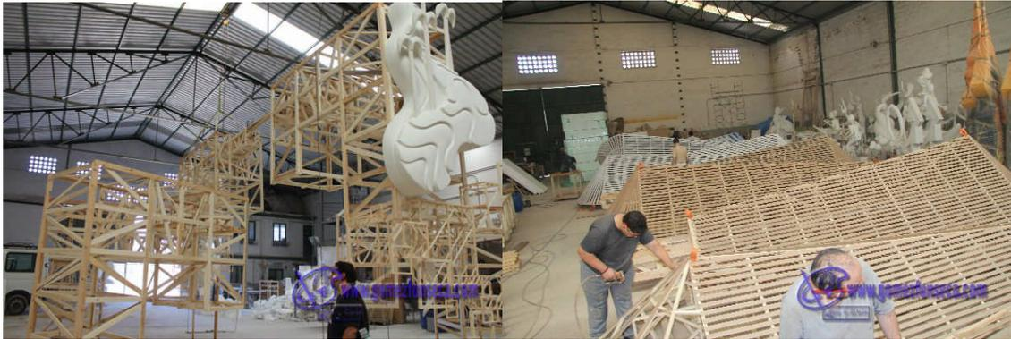
**Imagen 139.** Estructuras de madera de los Hermanos Fonseca en su taller durante su proceso de construcción.
