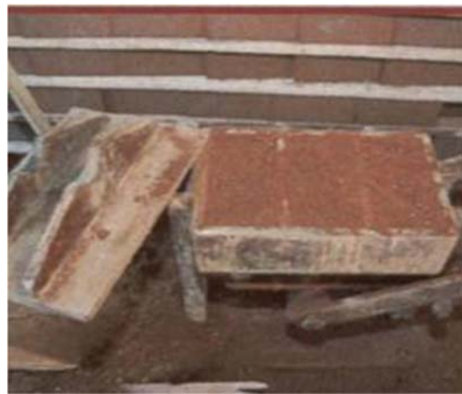
Fig. 43 - Ejecución de ladrillos de adobe. (Revista Arquitetura e Construção, São Paulo 2003).
