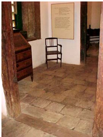
Fig. 170 - Suelo de losas de piedra del Ayuntamiento y Cárcel de la Ciudad de Goiás, Goiás. (Foto de la autora).
