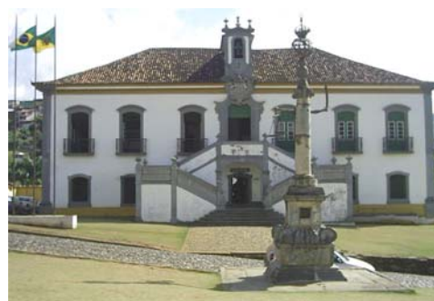
Fig. 79 – Edificio del Ayuntamiento y Cárcel, Mariana, Minas Gerais. (Disponibile en: < http://www.defender.org.br >)
