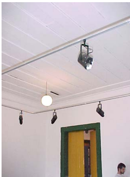
Fig. 174 - Revestimiento del techo del piso superior del Ayuntamiento y Cárcel de la Ciudad de Goiás, Goiás. (Foto de la autora).
