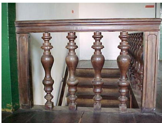
Fig. 117 - Barandal y balaústres del piso superior del Ayuntamiento y Cárcel de la Ciudad de Goiás, Goiás. (Foto de la autora).
