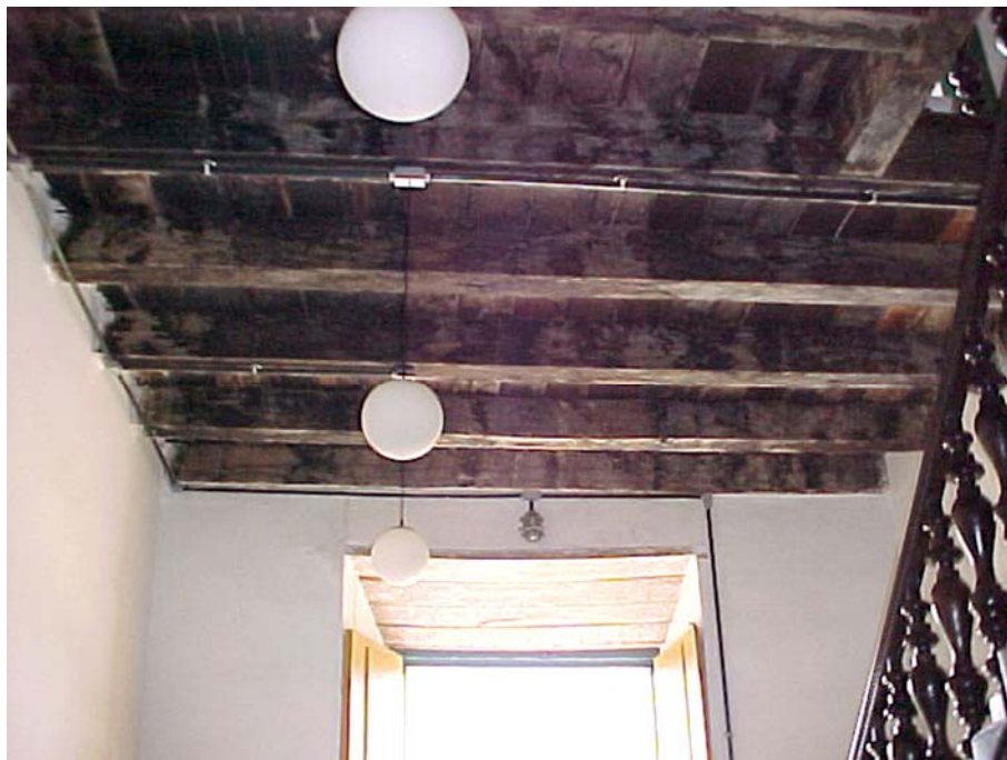
Fig. 173 - Vigas y tablado corrido del piso superior del Ayuntamiento y Cárcel de la Ciudad de Goiás, Goiás. (Foto de la autora).
