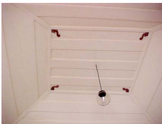
Fig. 377 – Falso techo de la Casa del Obispo - Ciudad de Goiás, Goiás. (Foto de la autora).
