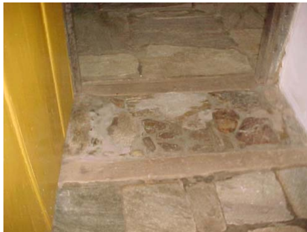
Fig. 171 - Suelo de losas de piedra del Ayuntamiento y Cárcel de la Ciudad de Goiás, Goiás. (Foto de la autora).
