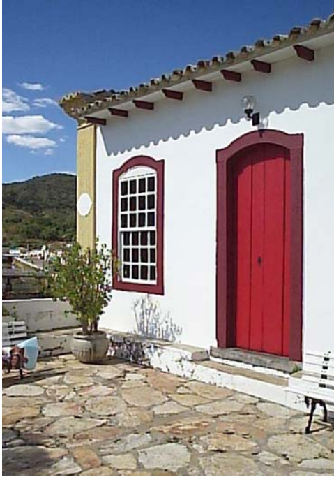
Fig. 373 – Solera y patio posterior de la Casa del Obispo - Ciudad de Goiás, Goiás. (Foto de la autora).
