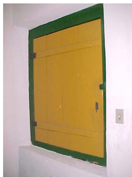
Fig. 155 - Ventana del edículo orientada al patio interno del Ayuntamiento y Cárcel de la Ciudad de Goiás, Goiás. (Foto de la autora).
