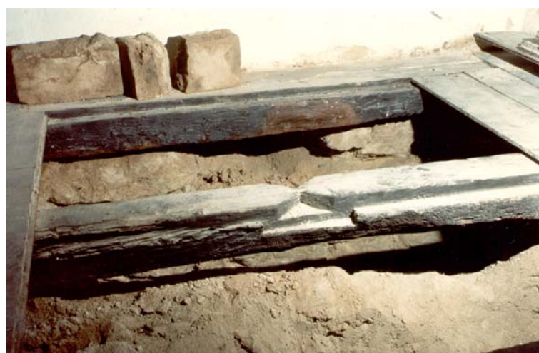
Fig. 217 – Cimiento y pavimento de madera de la Iglesia Nuestra Sra. de la Buena Muerte – Ciudad de Goiás, Goiás. (Foto del acervo de la Constructora Biapó – Goiânia, Goiás).
