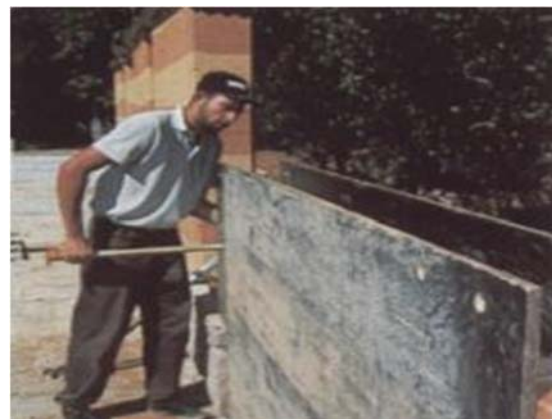
Fig. 47 - Ejecución de pared en taipa-de-pilão . (Revista Arquitetura e Construção, São Paulo 2003).
