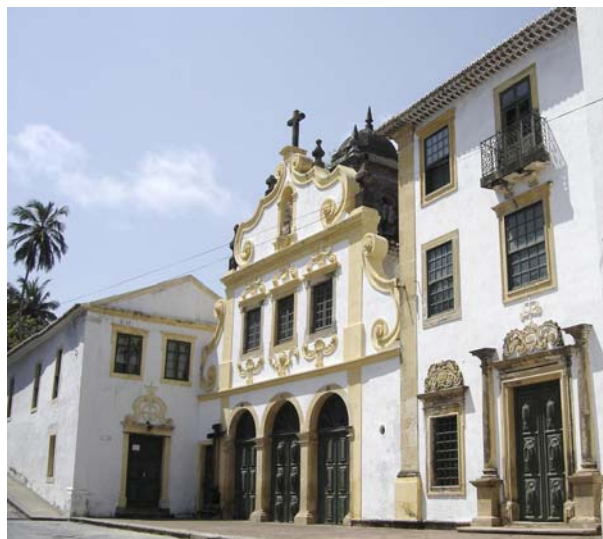
Fig. 178 – Igreja y Convento de Nossa Senhora das Neves, 1585. Olinda, Pernambuco.
