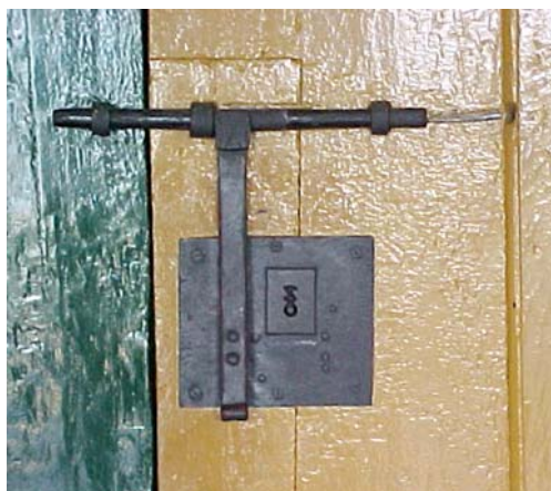
Fig. 167 - Cerrojo de la puerta del Ayuntamiento y Cárcel de la Ciudad de Goiás, Goiás. (Foto de la autora).
