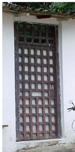
Fig. 139 - Puerta-reja del edículo del Ayuntamiento y Cárcel de la Ciudad de Goiás, Goiás. (Foto de la autora).
