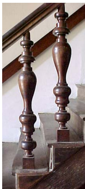
Fig. 115 - Balaústres de la escalera en el recibidor del Ayuntamiento y Cárcel de la Ciudad de Goiás, Goiás.
