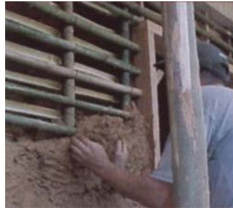
Fig. 45 - Ejecución de pared en pau-a-pique . (Revista Arquitetura e Construção, São Paulo 2003).
