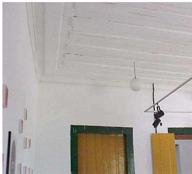
Fig. 175 - Revestimiento del techo del piso superior del Ayuntamiento y Cárcel de la Ciudad de Goiás, Goiás. (Foto de la autora).
