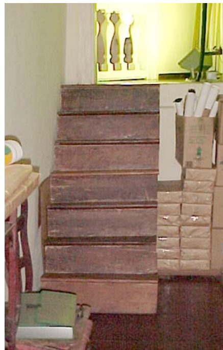
Fig. 243 – Escalera de la Iglesia Nuestra Sra. de la Buena Muerte – Ciudad de Goiás, Goiás. (Foto de la autora).
