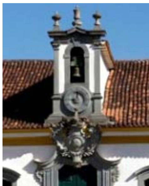
Fig. 130 – Campanario del Ayuntamiento y Cárcel de Mariana, Minas Gerais. (A. BUENO, et.al. O Patrimônio Construído. As 100 mais belas edificações do Brasil . São Paulo 2002).
