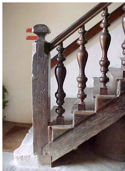
Fig. 114 – Pilar de arranque, balaústres y pasamanos de la escalera del Ayuntamiento y Cárcel de la Ciudad de Goiás, Goiás. (Foto de la autora).
