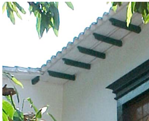
Fig. 124 - Alero de canecillo del Ayuntamiento y Cárcel de la Ciudad de Goiás, Goiás. (Foto de la autora).
