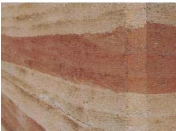
Fig. 46 - Pared en taipa-de-pilão . (Revista Arquitetura e Construção, São Paulo 2003).
