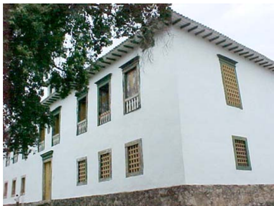
Fig. 99 - Fachada principal del Ayuntamiento y Cárcel de la Ciudad de Goiás, Goiás. (Foto de la autora).
