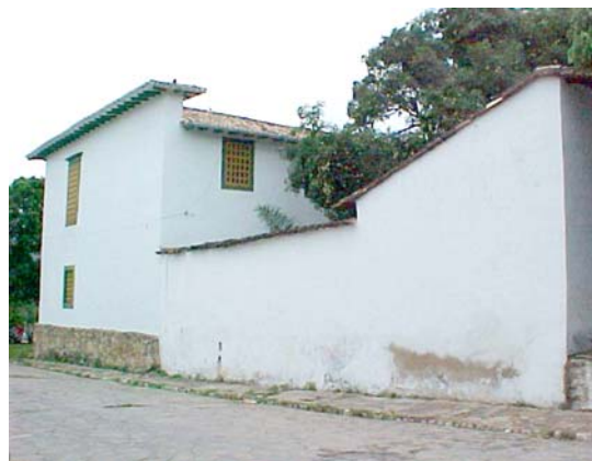
Fig. 100 - Fachada lateral derecha del Ayuntamiento y Cárcel de la Ciudad de Goiás, Goiás. (Foto de la autora).
