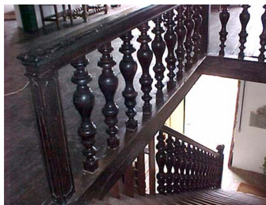
Fig. 118 - Barandilla del Ayuntamiento y Cárcel de la Ciudad de Goiás, Goiás. (Foto de la autora).
