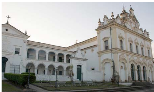
Fig. 186 – Igreja de la Orden Tercera de Nossa Senhora do Carmo, 1700. Cachoeira, Bahía. (Disponível em: < http://www.viagem.uol.com.br >).
