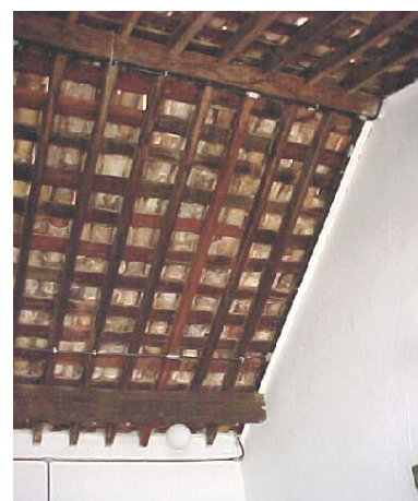
Fig. 106 – Pared hastial, sustentante del enmaderamiento del Ayuntamiento y Cárcel de la Ciudad de Goiás, Goiás. (Foto de la autora).
