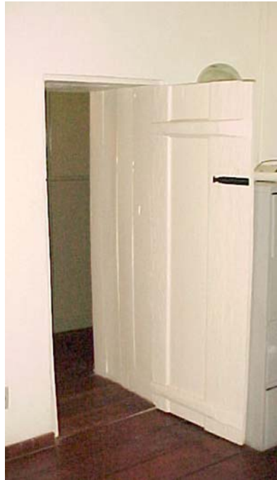
Fig. 259 – Puerta del piso superior de la Iglesia Nuestra Sra. de la Buena Muerte – Ciudad de Goiás, Goiás. (Foto de la autora).
