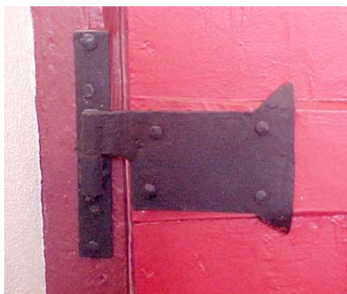
Fig. 367 – Bisagra de puertas y ventanas de la Casa del Obispo - Ciudad de Goiás, Goiás. (Foto de la autora).
