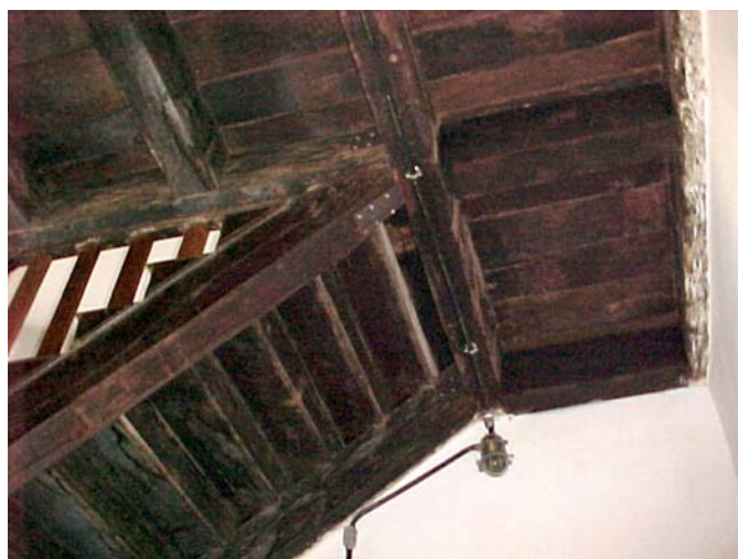
Fig. 111 – Vigas de sustentación de la escalera del Ayuntamiento y Cárcel de la Ciudad de Goiás, Goiás. (Foto de la autora).
