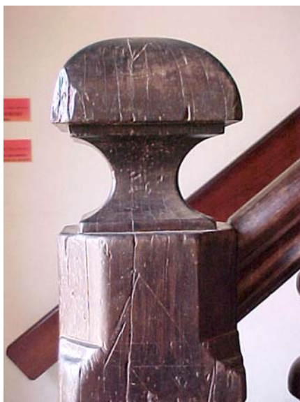
Fig. 113 – Pilar de arranque de la escalera del Ayuntamiento y Cárcel de la Ciudad de Goiás, Goiás. (Foto de la autora).
