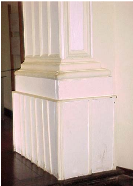
Fig. 230 – Pedestal de la pilastra del arco de la Iglesia Nuestra Sra. de la Buena Muerte – Ciudad de Goiás, Goiás. (Foto de la autora).
