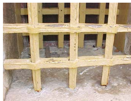
Fig. 148 - Reja externa de la ventana de la celda mayor del Ayuntamiento y Cárcel de la Ciudad de Goiás, Goiás. (Foto de la autora).
