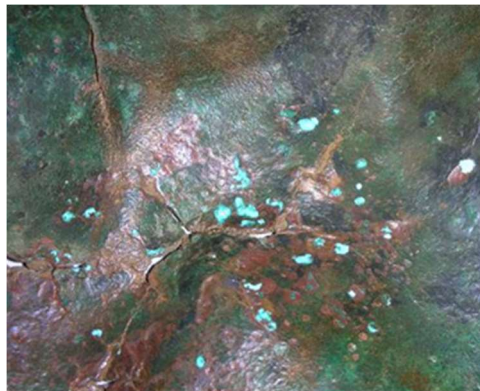
Figura 9.16. Detalle de las eflorescencias en la parte interna del Casco
