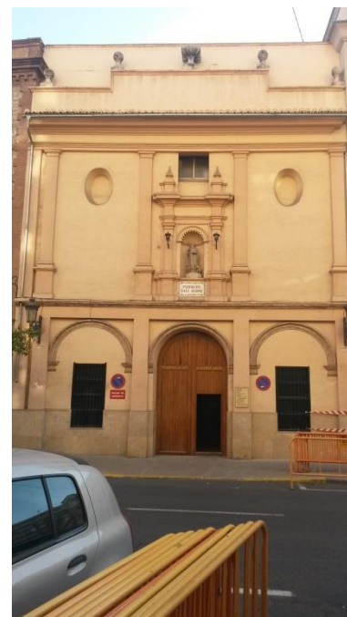
33 SAA. Fachada iglesia San Antonio Abad.
