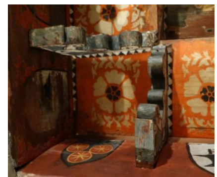
49 SAA. Modillones ensamblados en friso y correa.
