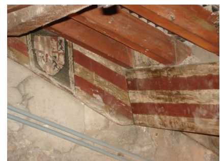
52 SAA. Engargolado de alicer sobre correas.
