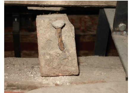
56 SAA. Enclavado de cabio sobre correa.
