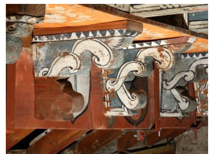
108 SAA. Reposición piezas perdidas y acuñamiento tablas sobre modillón.
