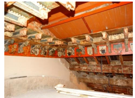
54 SAA. Almizate sin la tabla de cierre y proyección de las correas y cabios en vertical.
