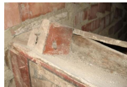
45 SAA. Rebaje correa para apoyo cabio, la sujeciones son con clavos.
