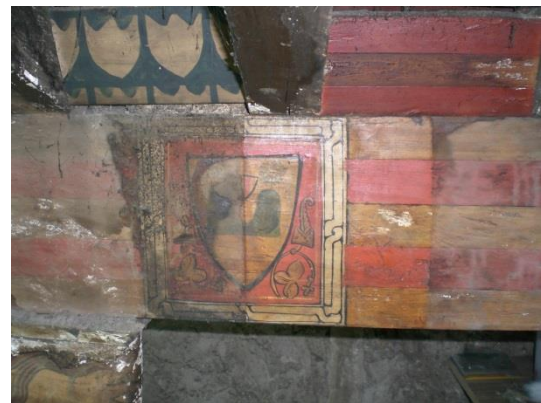
Encuentro elementos de la armadura (Foto Josep L. Gil i Cabrera)
