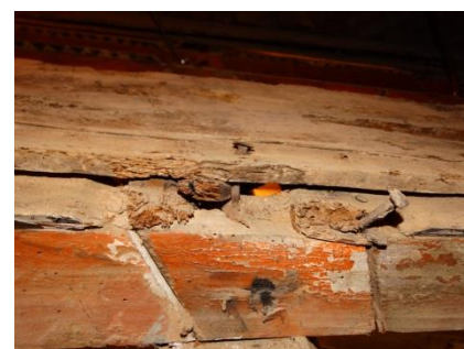
46 SAA. Gárgol para tablas y clavado tablero.
