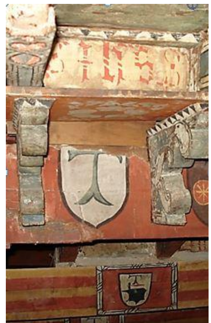
64 SAA. Estructura de vigas y almizate. Tabica crismón de Jesucristo \text{̄jhs} .
