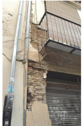
Daños principales en las fachadas de los edificios: desprendimientos del revestimiento.
