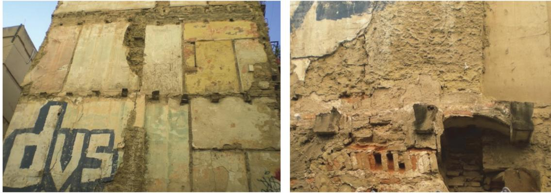
Imagen 210. Detalles de forjados en restos de construcciones demolidas en Seu-Xerea.
