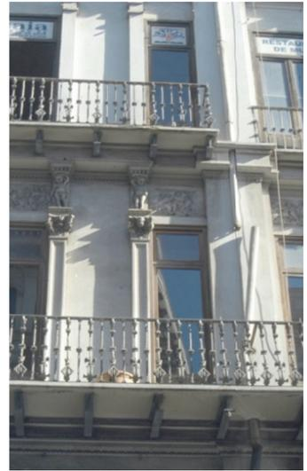
Daños principales en las fachadas de los edificios: deterioro y desprendimientos en voladizos.
