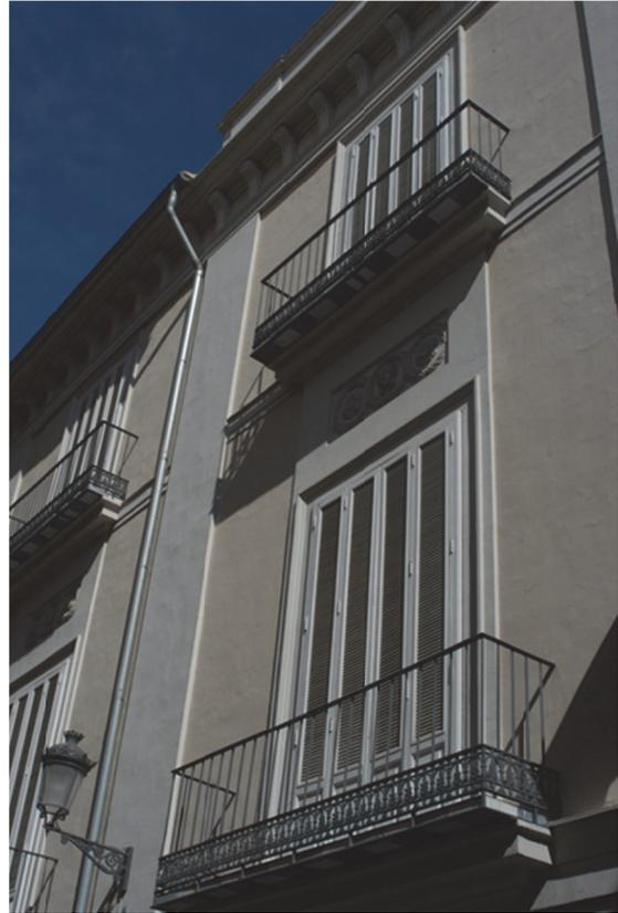
Imagen 359. Protección con mallorquinas exteriores.
