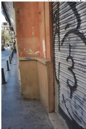
Imagen 343. Humedad sobre el zócalo.
