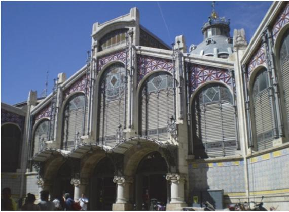
Imagen 238. Fachada exterior del Mercado Central: parasoles y lamas metálicas para ventilación.
