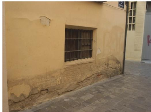
Imagen 342. Degradación de pintura y revestimiento.
