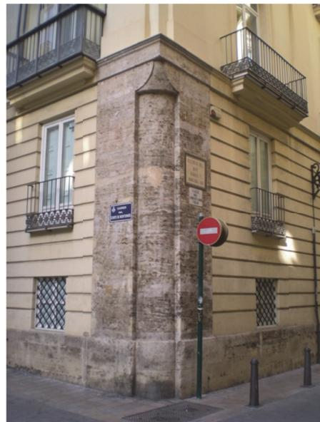
Imagen 350. Refuerzo singular de esquina para facilitar el paso.
