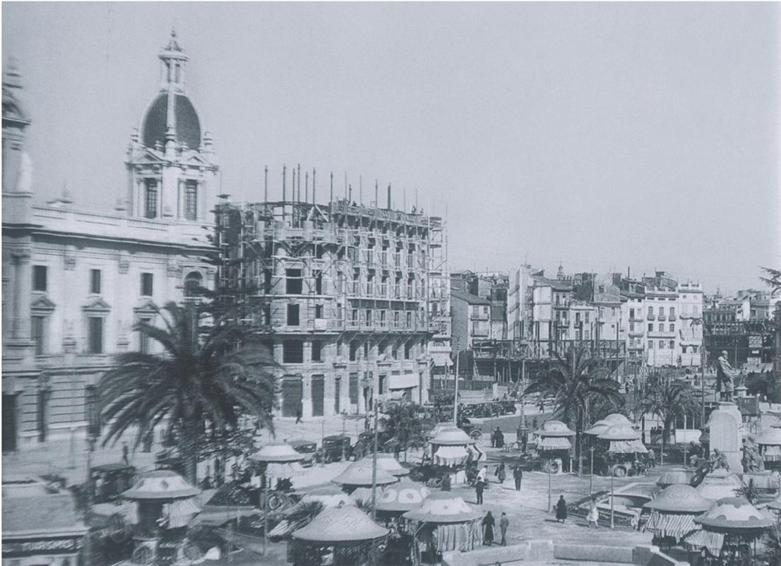
Imagen 101. Construcción de viviendas con estructura metálica en Valencia (ca.1920).
