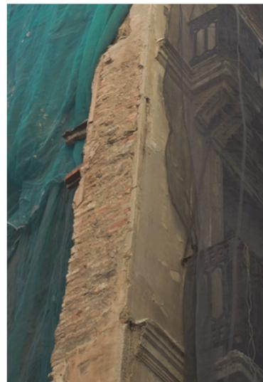
Imagen 348. Muro de una hoja de ladrillo con impostas.
