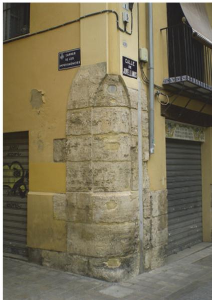
Imagen 349. Refuerzo curvo de esquina para facilitar el paso.
