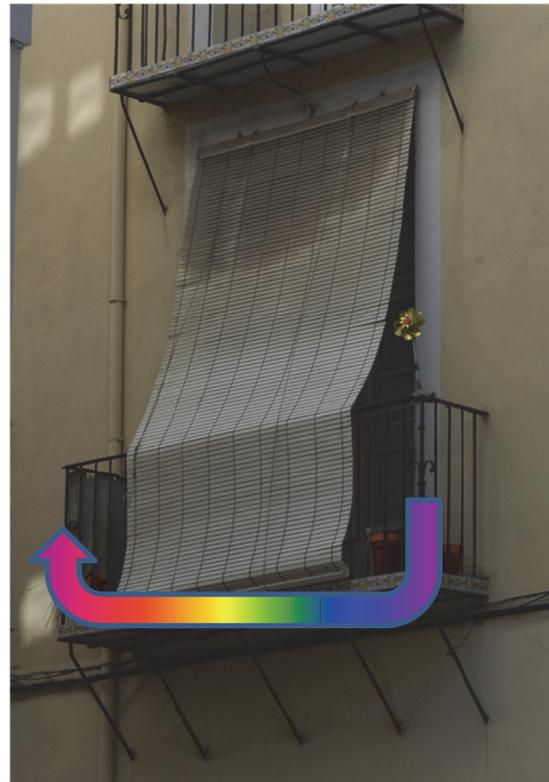
Imagen 361. Detalle de la persiana y efecto de ventilación.
