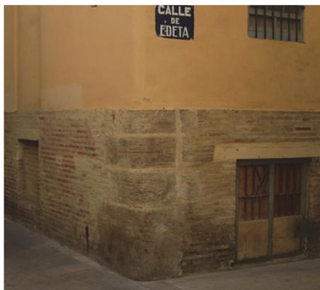
Imagen 351. Refuerzo de esquina con sillares y zócalo con fábrica de ladrillo o de piedra.
