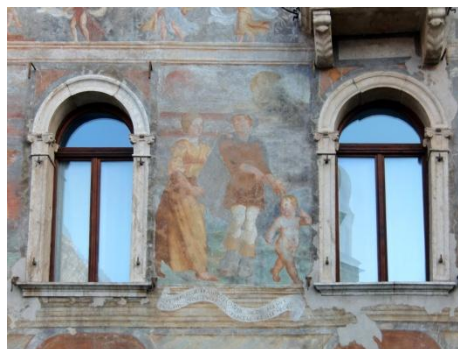
Fig.10 Detalle fachada Casa Cazzuffi, Trento, Italia.
