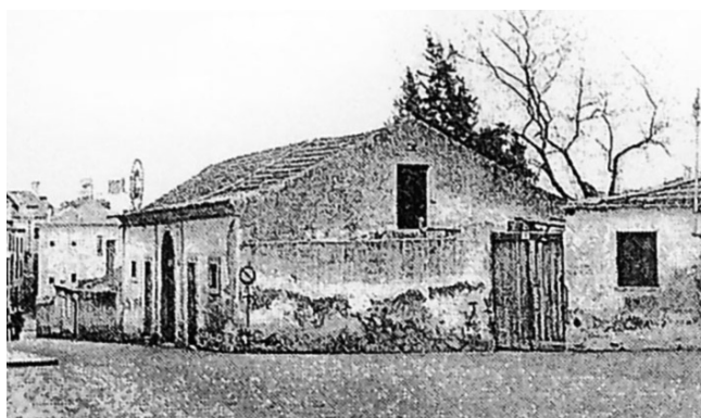
Figura 28. Armazém da fábrica do Cojo (Fotografia de arquivo de Jorge Marques)
