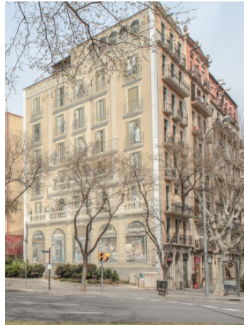
Fig. 38 "Balcons de Barcelona": tratamiento de medianera mediante la técnica de trampantojo.
