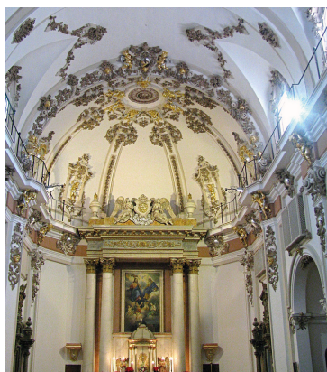
Fig. 5 Bóveda de la Trinidad de Valencia.
