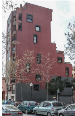
Fig. 38 "Jardins dels Castellars": el diseño ha permitido abrir huecos en la medianera, mejorando la calidad de las viviendas.
