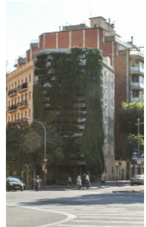
Fig. 40 "Jardí Tarradellas": se incorporan un jardín vertical confiriendo mejores condiciones térmicas y estéticas.
