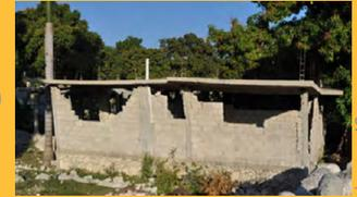
Edificio de un nivel, paredes de mampostería sin reforzar compuesta por bloques prefabricados, marco estructural de pilares y vigas de "hormigón armado" preparado in situ, cubierta de hormigón y suelo cemento. Esta tipología generalmente la construyen una vivienda sobre la otra, de manera escalonada en laderas .
