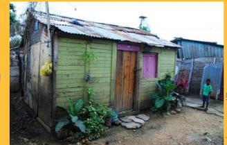
Edificio de madera de un nivel, cubierta de hojas corrugadas de zinc y suelo de tierra, de aprox. 5 x 6 mt.
