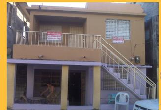
Edificio de 2 o más niveles con paredes de mampostería reforzada compuesta por bloques prefabricado, marco estructural de pilares y vigas de "hormigón armado" preparado in situ, cubierta de hormigón vacada in situ y suelo cemento.
