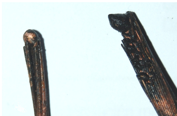
Figura 2.22 Cableado de cobre multifilar seccionado con perlado, a consecuencia de un cortocircuito en el cuadro eléctrico de un bar que sufrió un incendio (imagen propia)
