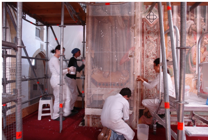
Fig.36 Preparación de la superficie de los “pilastris” de la pared norte destinada a recibir el impacco de hidróxido de bario. Momento de aplicación del “bachino” perimetral sobre la superficie ya protegida por papel Japón aplicado con agua y sujetado adicionalmente con puntos de ancoraje realizados con pasta neutra, con el fin de evitar que caiga dicha protección.
