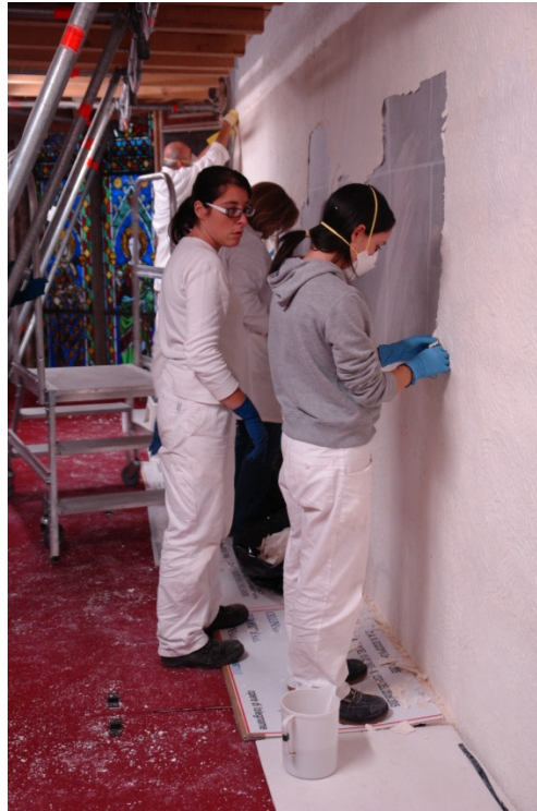
Fig.48 Operaciones de retiro del gran impacco de las escenas laterales de la capilla en donde se inicia desde el centro. En este caso se dejaba la capa de papel Japón en directo contacto con la superficie para retirar cuidadosamente en un segundo momento.
