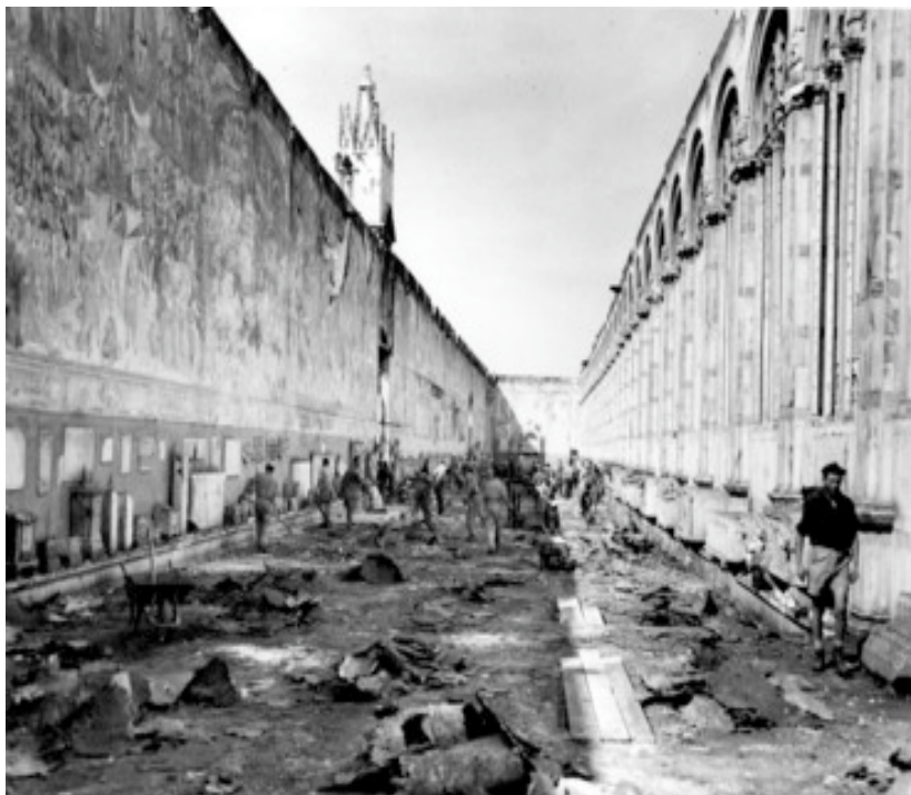
Fig.3 Imagen de estado en el que quedo el Camposanto di Pisa después de los bombardeos del 1944
