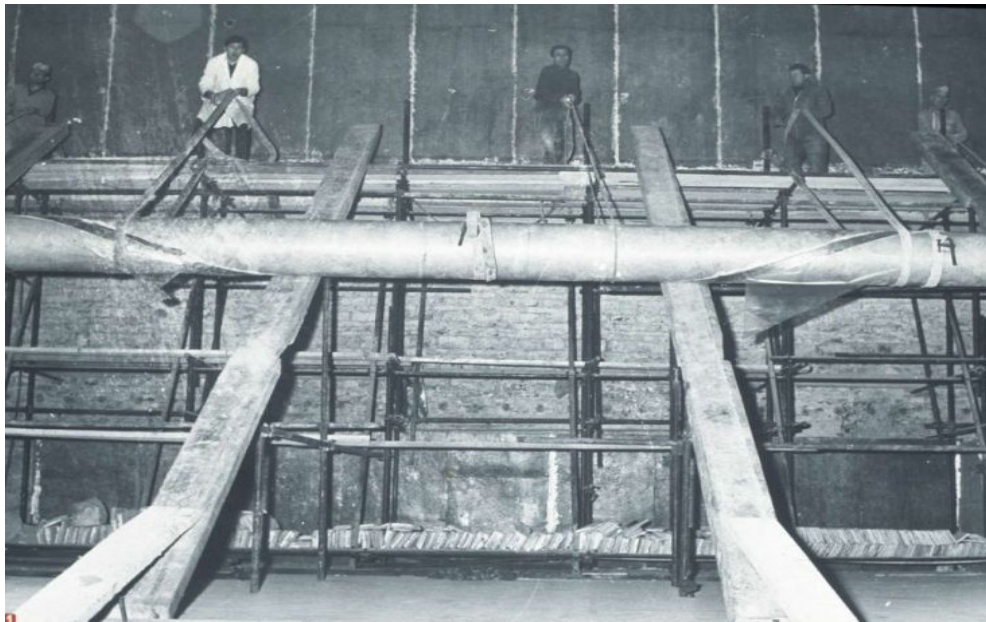
Fig 10. Momento en el que se coloca "L'Albero della Vita" de nuevo en su ubicación original en la pared del refectorio. La pintura enrollada gracias a su nuevo soporte de vetro-resina flexible.
