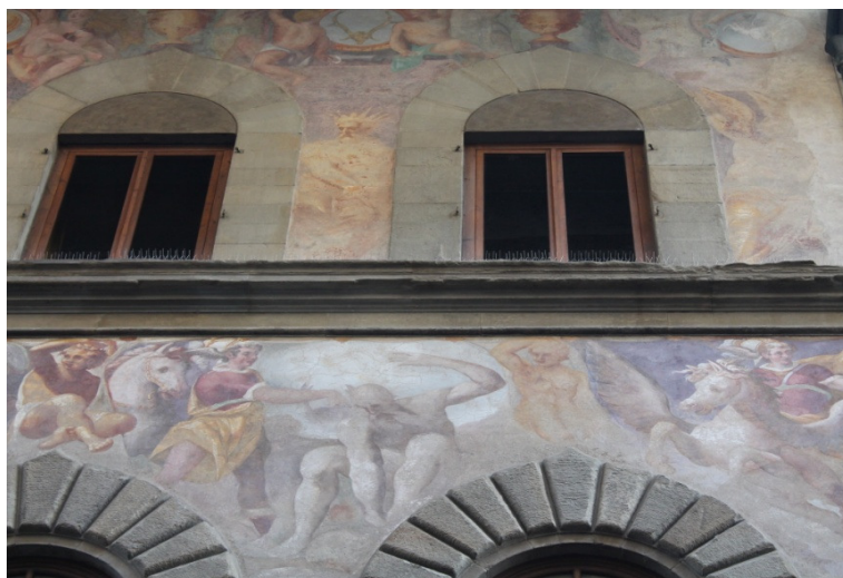
Fig. 13 detalle de la fachada Palazzo Mellini Fossi en el que se utilizó solución de hidróxido de bario como protectorio del retoque. Foto realizada en agosto 2015
