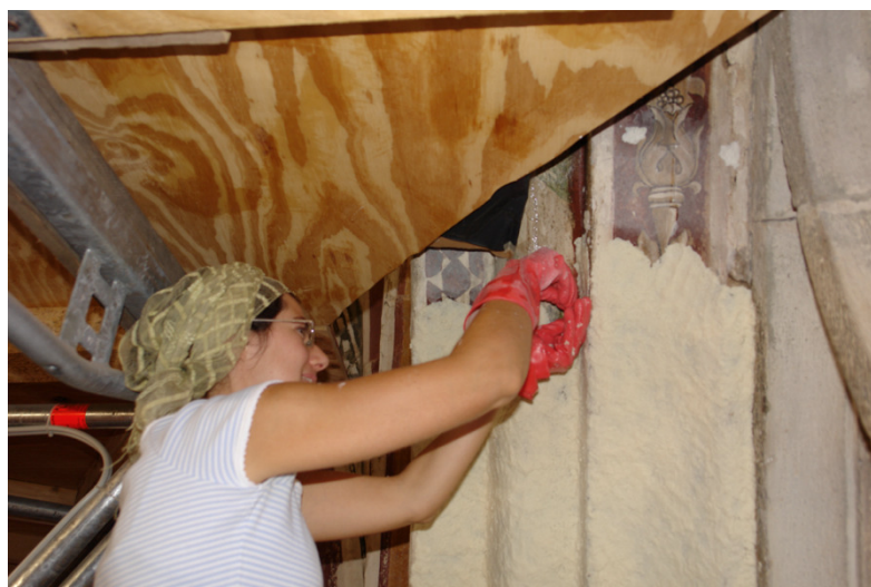
Fig. 39 Aplicación convencional de la pasta del impacco de abajo a arriba
