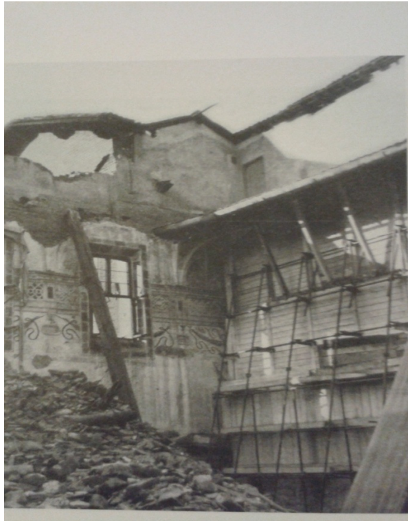
Fig.2. Ejemplo de Andamiaje y protección contra los ataques bélicos del Cenacolo de Leonardo da Vinci. Única pared que quedó en pie del refectorio de Santa Maria delle Grazie. Milano
