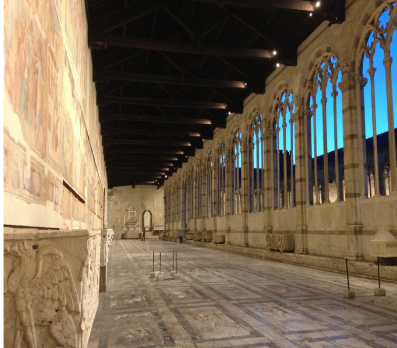
Fig.4 Estado actual de una de las galerías del Camposanto di Pisa
