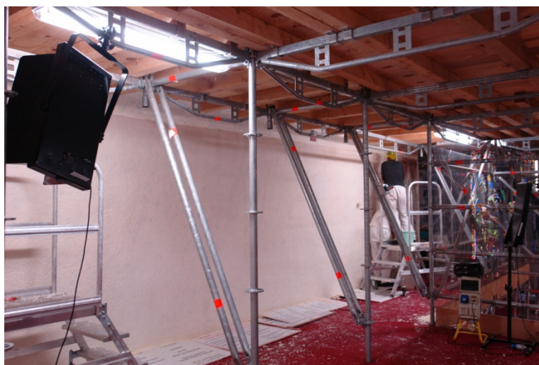
Fig. 43 Parte del impacco que cubría toda una escena finalizado de aplicar
