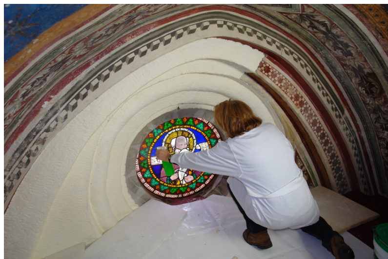
Fig.32 Aplicación de impacco de bario en las zonas altas de la capilla
