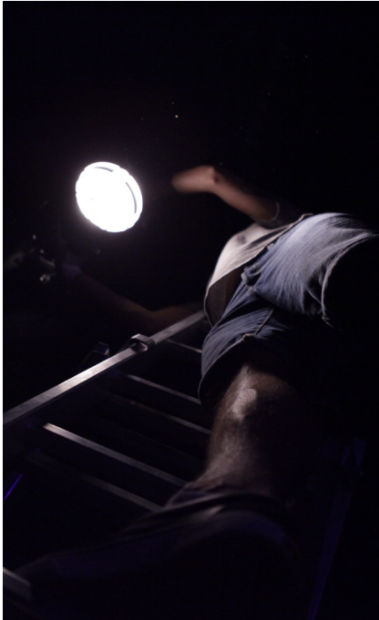
1. Instalación de la iluminación.
