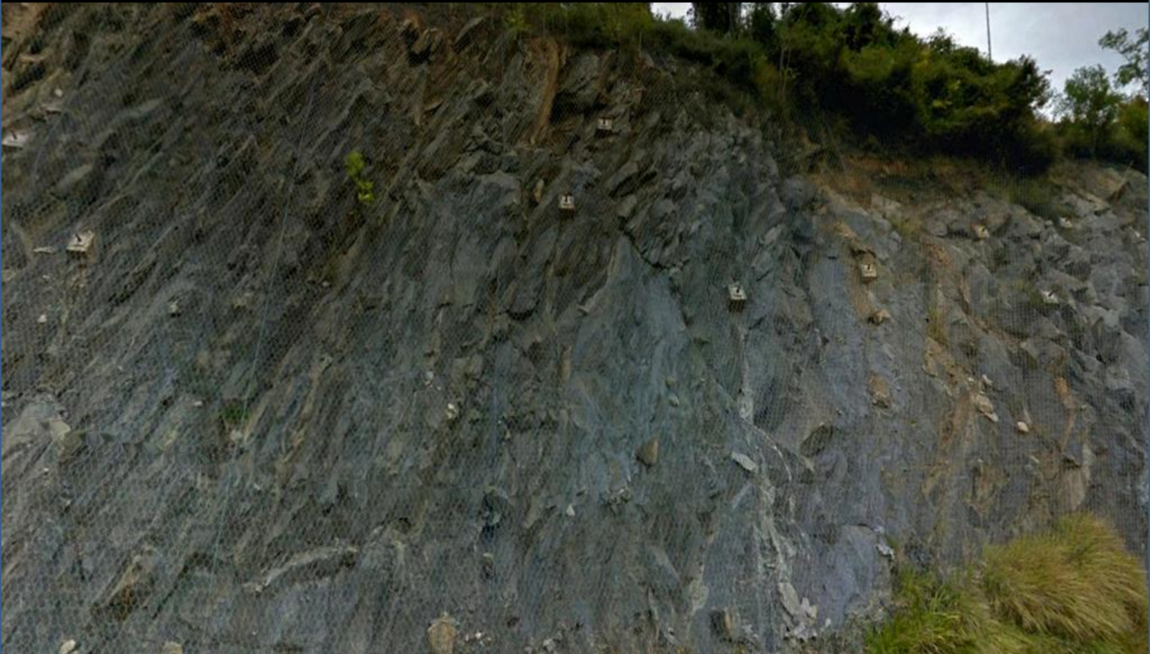
E de la anterior: Mallazo y bulones en las margas –tectonizadas- del Albiense, Cretácico Inf. S de Sodupe, Vizcaya. SW Hoja de Bilbao.
