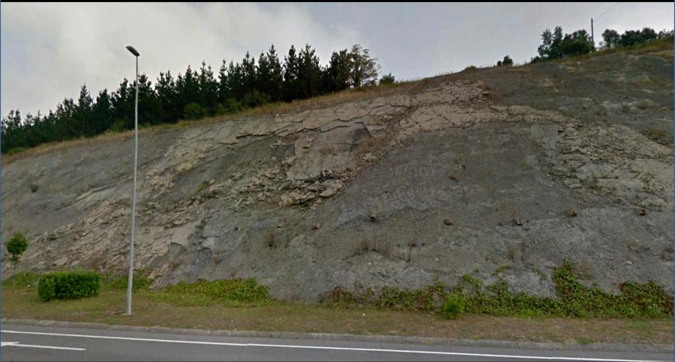
Bulonado en las calizas y margas del Santoniense Sup.-Maestrichtiense, Cretácico Sup. S de Meakaur de Munguía. NW Hoja de Durango.
