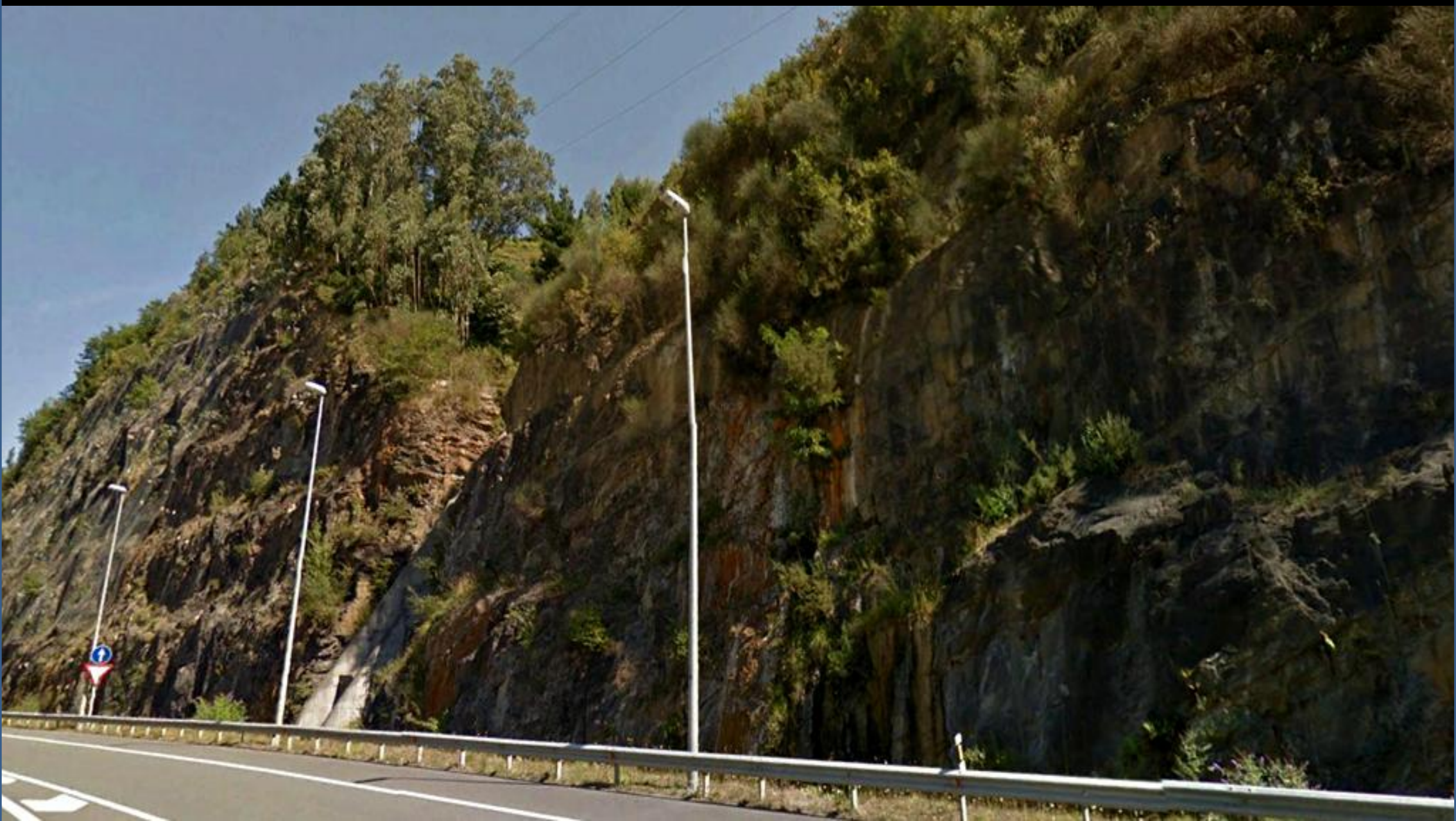
Taludes con fuerte inclinación. En las areniscas, margas y areniscas calcáreas- con mallazo- del Barremiense, Cretácico Inf. Autopista al NE de Zaramillo, Vizcaya. Centro S Hoja de Bilbao
