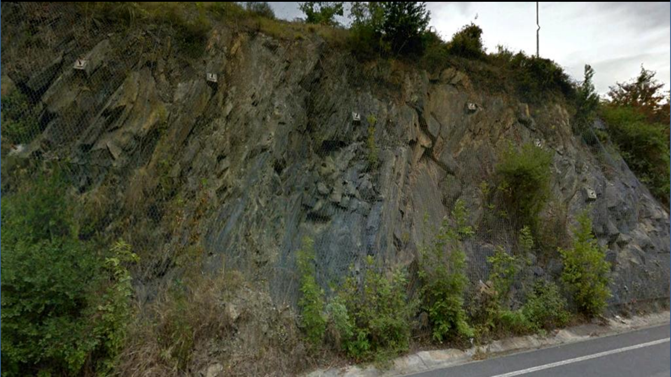
E de la anterior: Mallazo y bulones en las margas y margocalizas –tectonizadas- del Albiense, Cretácico Inf. S de Sodupe, Vizcaya. SW Hoja de Bilbao.
